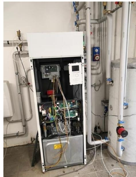
Figura 42 - PdC Struttura interna [31]
