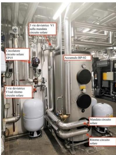
Figura 51 - Accumulo BP-02 centrale termica e componenti [31]
