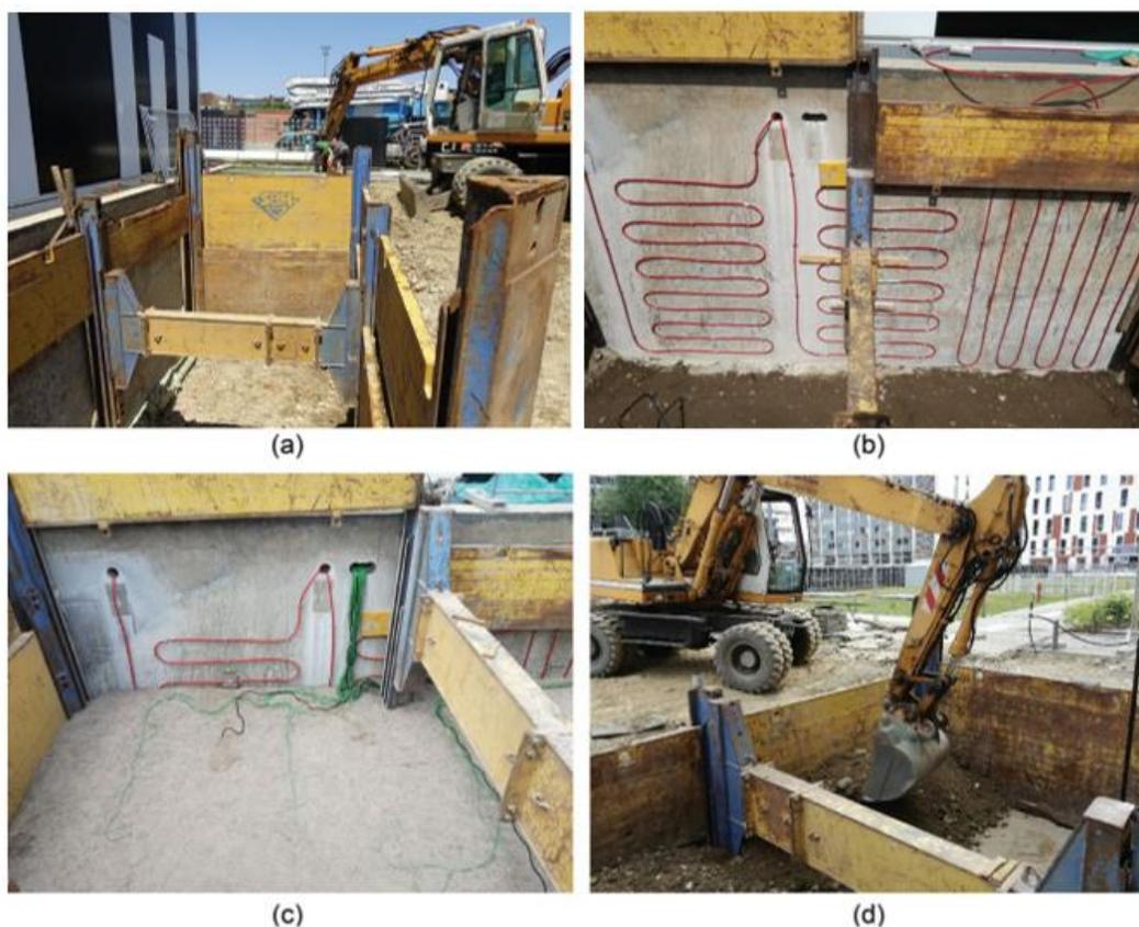
Figura 38 - Fase di installazione di GeothermSkin: opera di scavo (a), dispiegamento tubi (b), posizionamento sistemi di sensoristica e monitoraggio (c) e riempimento dello scavo (d) [30]
