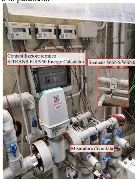
Figura 44 - Collettore primario e contabilizzatori [31]
