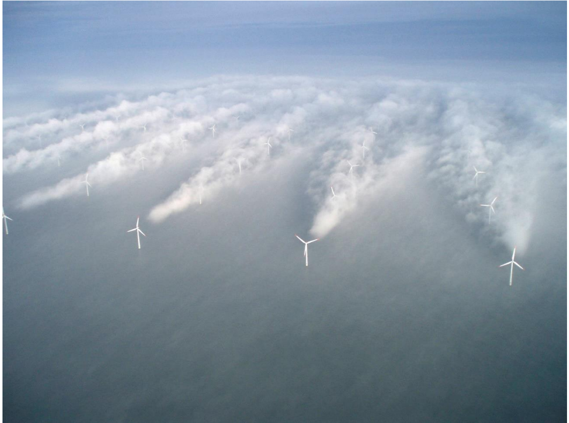
Figura 5 Effetto scia in un impianto eolico [2]
