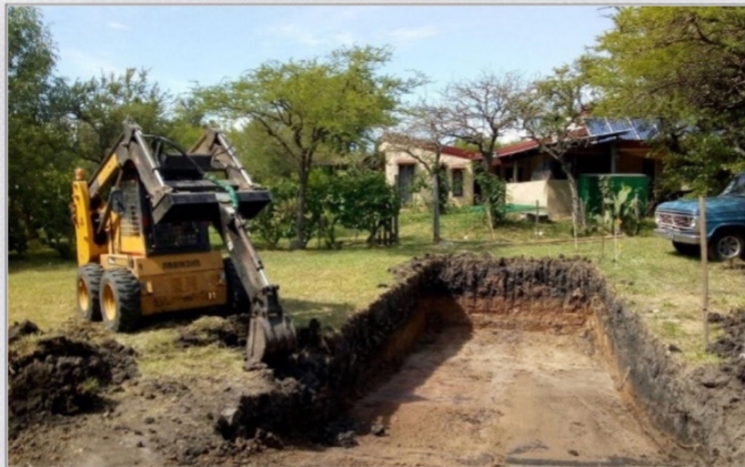
Fig. 9. Excavación manual para un humedal unifamiliar. Ing. Fernando Raffo
