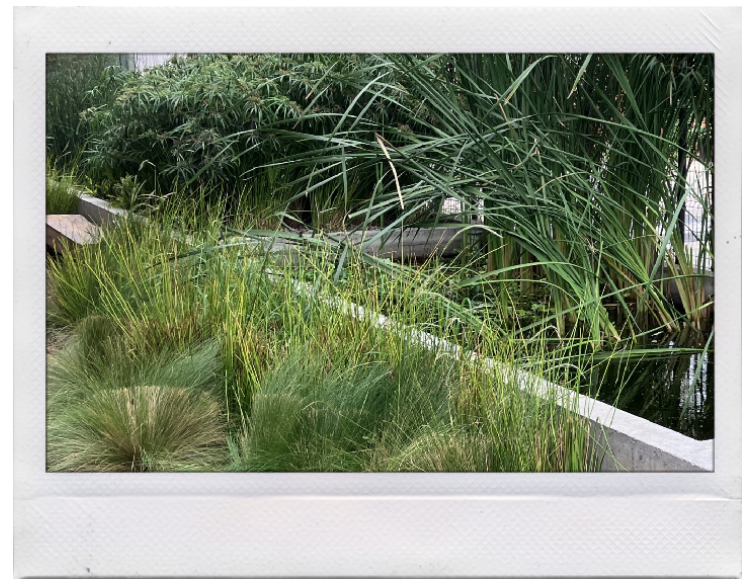
Fig. 5. Humedal de tipo subsuperficial combinado con un humedal de tipo superficial, con un acabado de hormigón visto. TIM Technologies.
