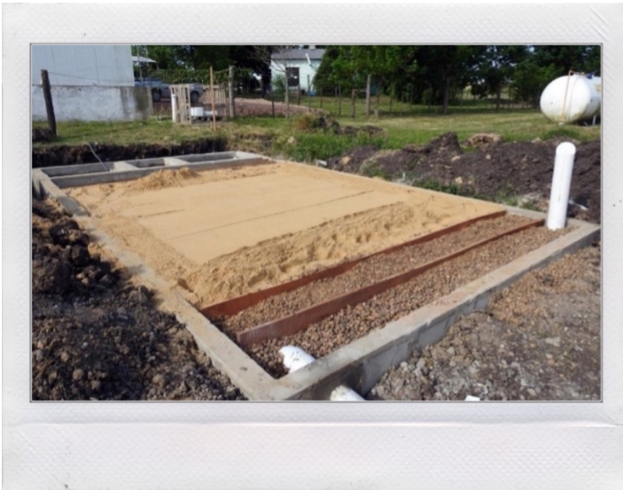
Fig. 14. Vista del relleno de áridos en un humedal compacto, mostrando la colocación de los paneles de separación, el tubo de drenaje y su ventilación, que en este caso es de 160 mm. Falta el revestimiento final con piedra. Ing. Fernando Raffo
