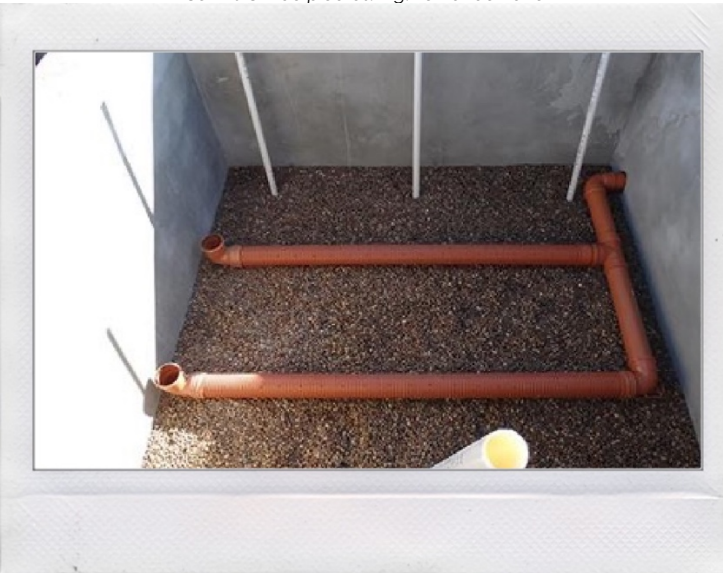
Fig. 8 Vista de la tubería de salida, donde deben conectarse las tuberías para trabajar a presión atmosférica y evitar que sellos hidráulicos de aire que dificulten el drenaje de la salida. Ing. Fernando Raffo.
