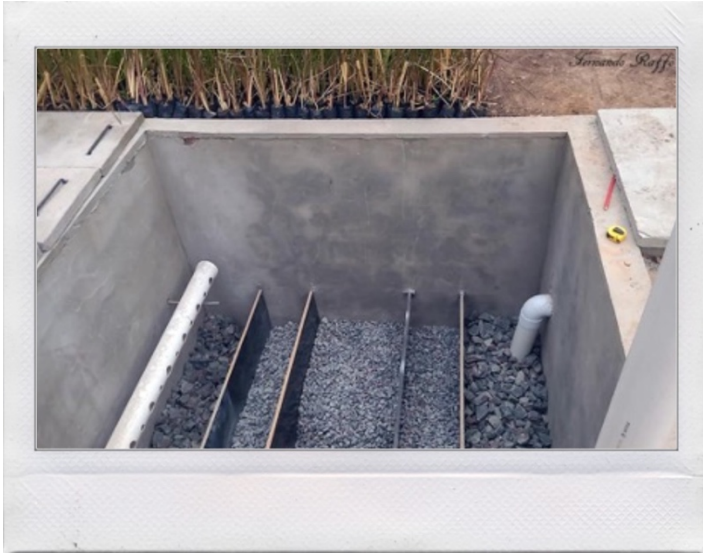
Fig. 13. Vista del relleno de áridos en un humedal de tipo unifamiliar, mostrando la colocación de los paneles separadores, la tubería de entrada, las conexiones de la tubería de salida el relleno de piedras. Ing. Fernando Raffo
