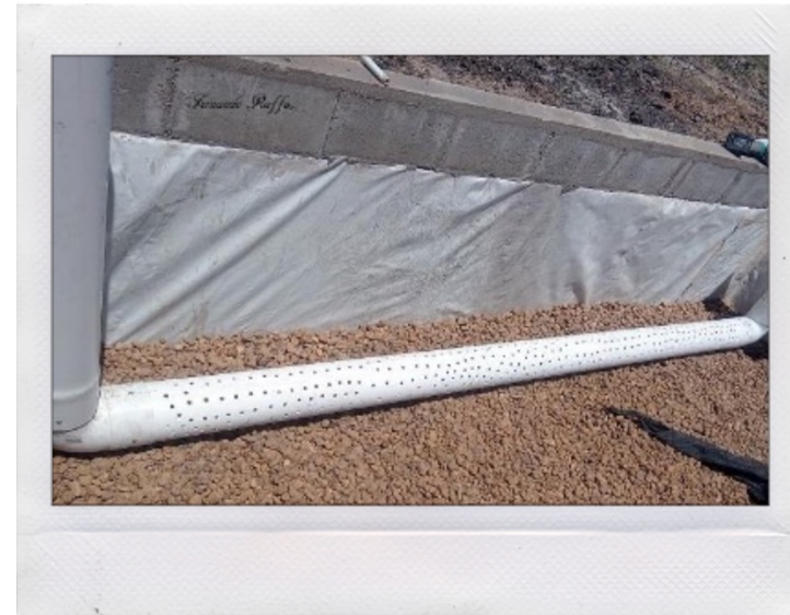
Fig. 15. Tubo di uscita prima di essere ricoperto con geotessuto. Ing. Fernando Raffo
