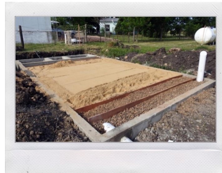
Fig. 14. Vista del riempimento di aggregati in una zona umida compatta, che mostra il posizionamento dei pannelli di separazione, il tubo di scarico e la sua ventilazione, che in questo caso è di 160 mm. Manca il rivestimento finale con pietra. Ing. Fernando Raffo
