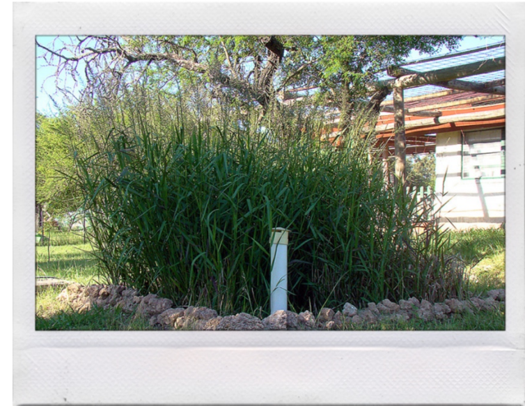
Fig. 6. Zona umida di casa unifamiliare in Bosque Pequeño, con pianta carrizo. Ing. Fernando Raffo.
