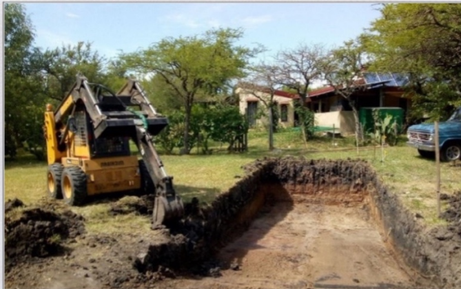
Fig. 9. Scavo manuale per una zona umida unifamiliare. Ing. Fernando Raffo
