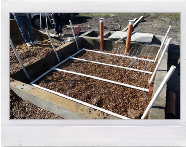
Fig. 7. Vista della prova idraulica del tubo di ingresso, poi ricoperto con 10 cm di pietre. Ing. Fernando Raffo
