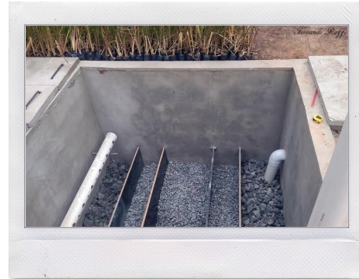
Fig. 13. Vista del riempimento di aggregati in una zona umida di tipo familiare, che mostra il posizionamento dei pannelli separatori, il tubo di ingresso, le connessioni del tubo di uscita e il riempimento di pietre sul fondo. Ing. Fernando Raffo
