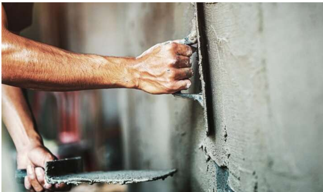
Figura 3 - Applicazione cemento
