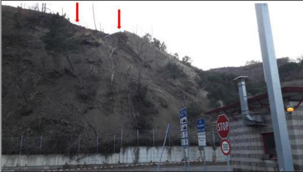
*Figura 3.17: Frana del 1° gennaio 2020, scivolamento rototraslazionale e ribassamento sul coronamento.*
