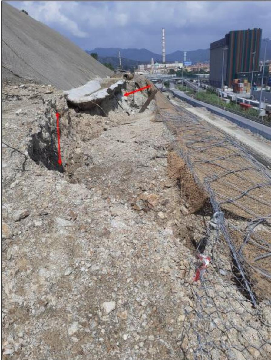
*Figura 4.36: Vista del fenomeno franoso lato sud dalla seconda banca, ben visibile il rigetto metrico della frana.*
