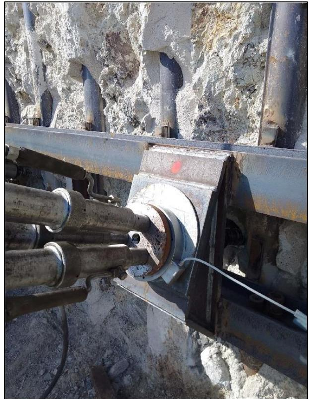
*Figura 5.21: Sistema di tesatura su tirante a 3 trefoli con applicazione dei martinetti*
