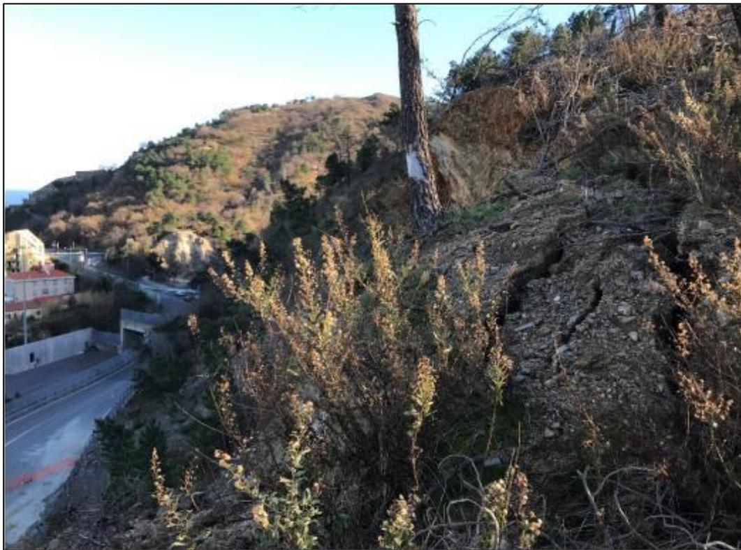
*Figura 3.18: Terreno ribassato con presenza di fessurazioni di trazione subverticali impostesi nel basamento milonitico alterato.*
