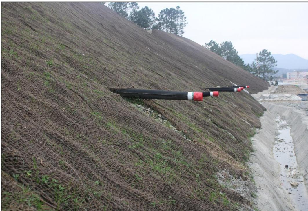
*Figura 2.18: Dreni sub-orizzontali e canaletta di scolo in cemento all'interno di una gradonatura realizzata nel cantiere di Vado Ligure.*
