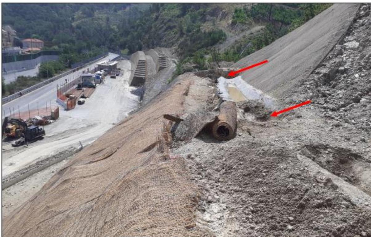
*Figura 4.35: Vista del coronamento della frana impostosi nella seconda banca lato nord.*
