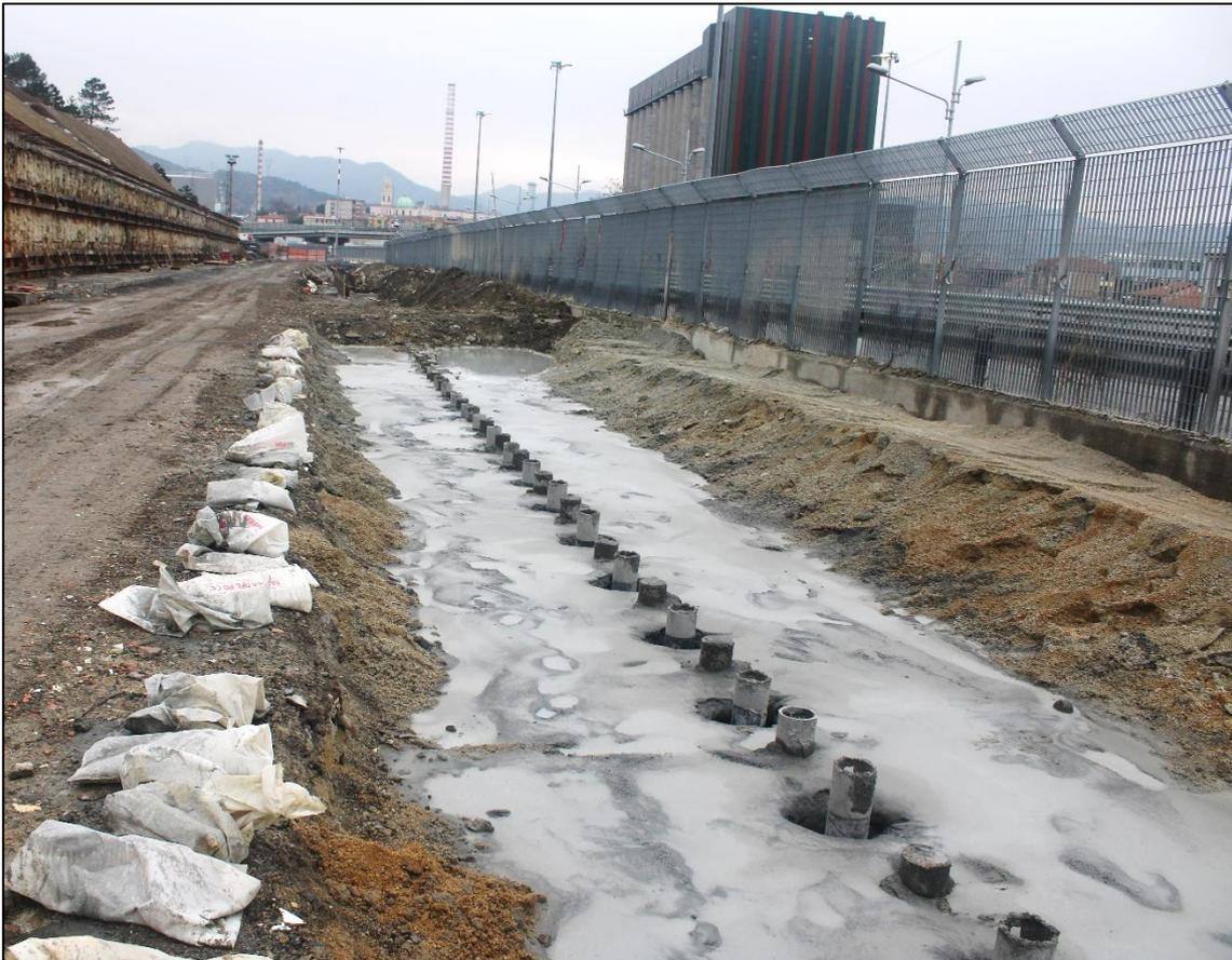
*Figura 8.9: Micropali infissi nel terreno, costituiranno la seconda paratia.*
