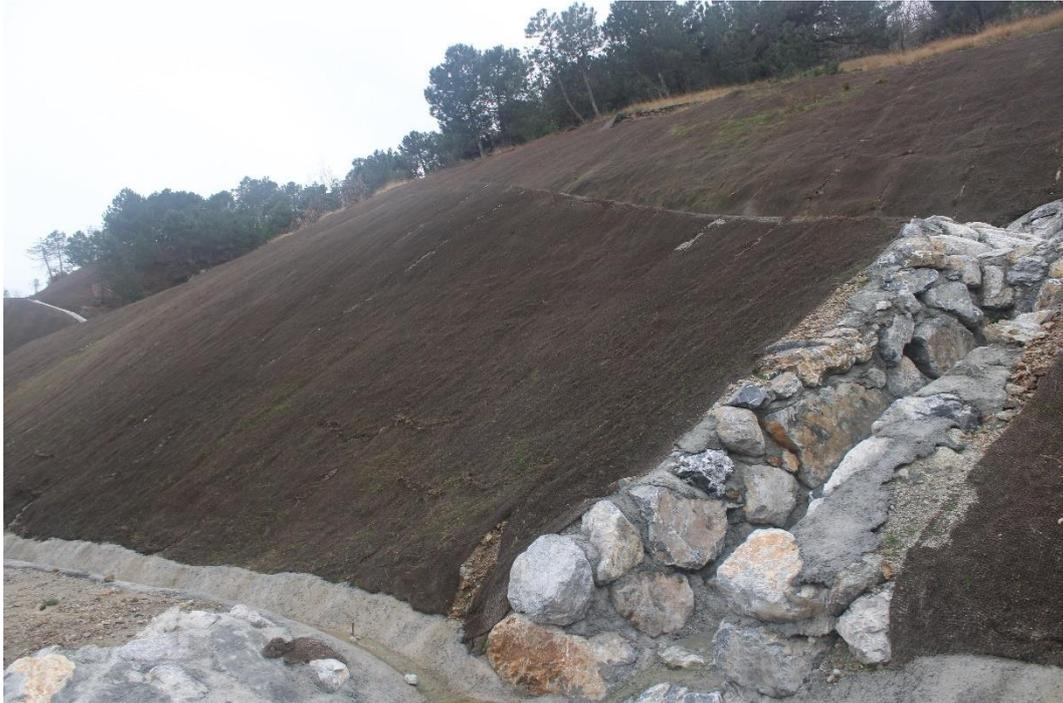
*Figura 2.9: Rivestimento antierosivo in juta idroseminato presente nel cantiere di Vado Ligure.*
