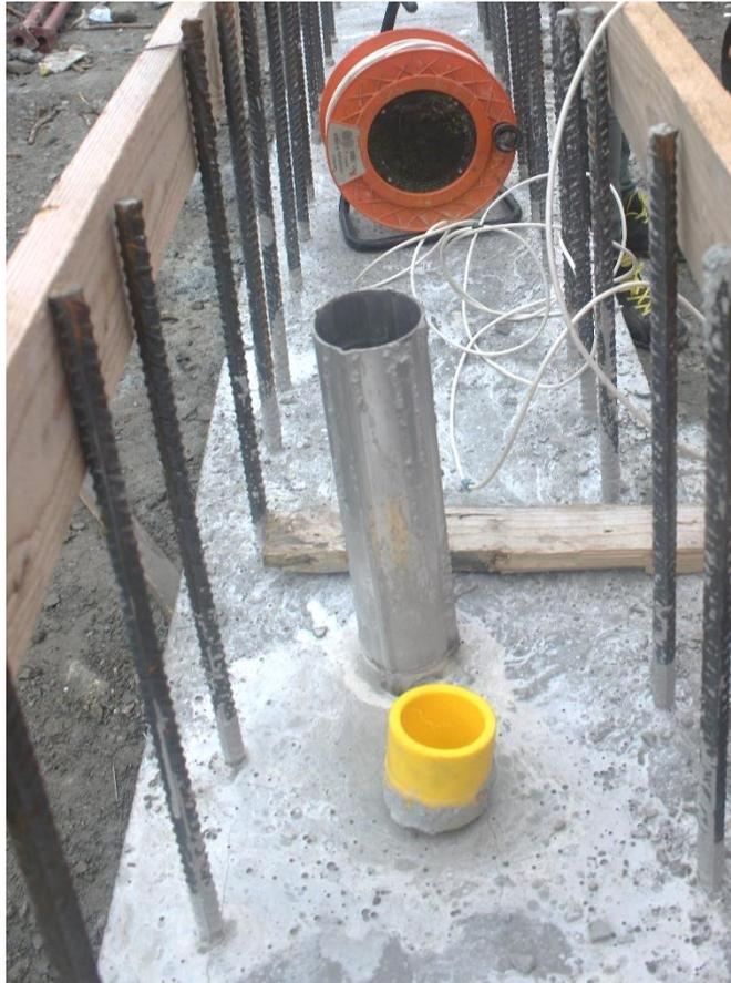
*Figura 5.2: Inclinometro realizzato all'interno delle paratie di micropali in costruzione a Vado Ligure.*
