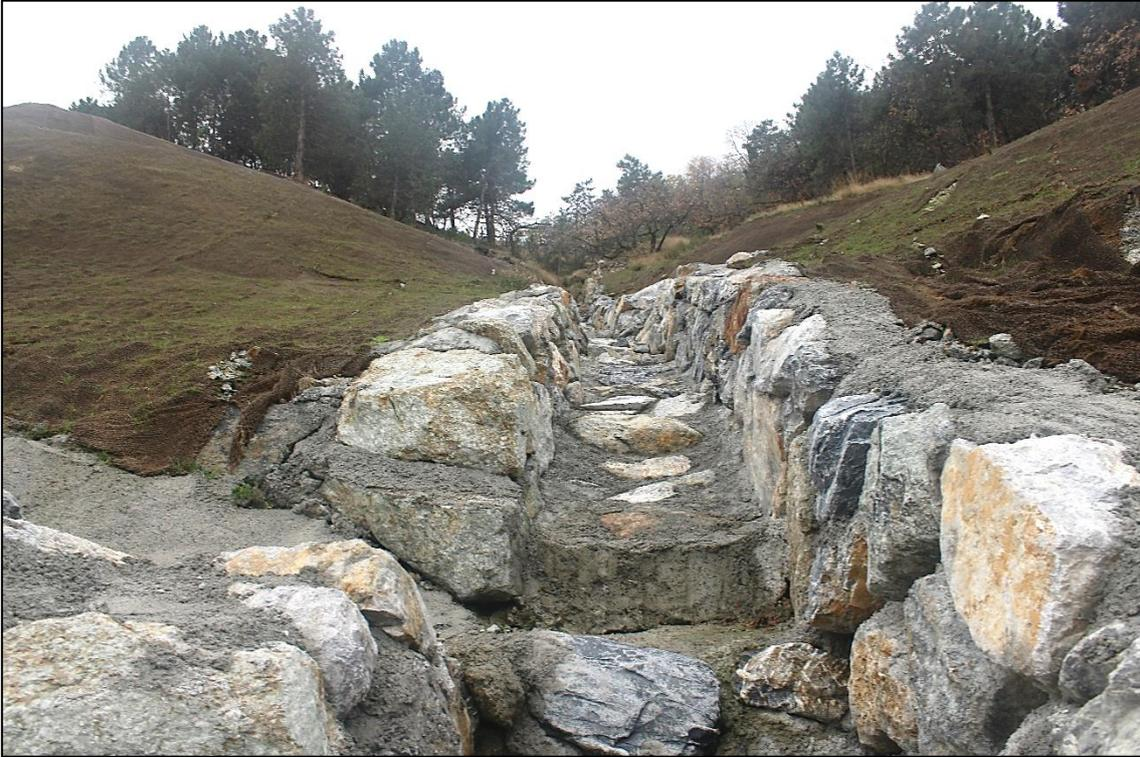
*Figura 8.5: Canale raccolta acque ruscellanti e collettore per le canalette poste ai piedi delle scarpate.*
