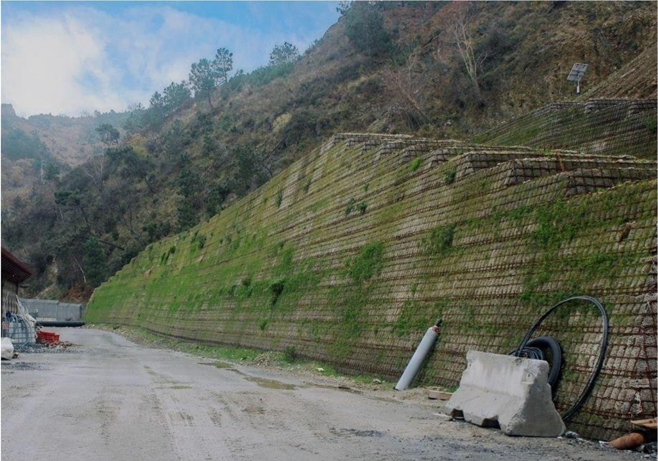
*Figura 2.5: Terre rinforzate con parziale rinverdimento del paramento di valle presenti all'interno del cantiere di Vado Ligure.*
