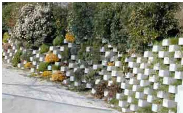
*Figura 2.4: Muro cellulare rinverdito.*
