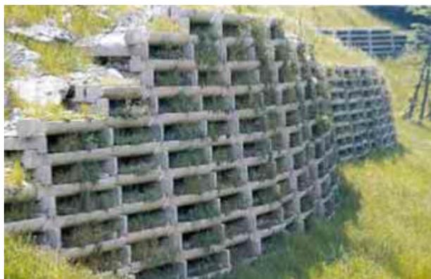
*Figura 2.3: Muro cellulare non rinverdito.*
