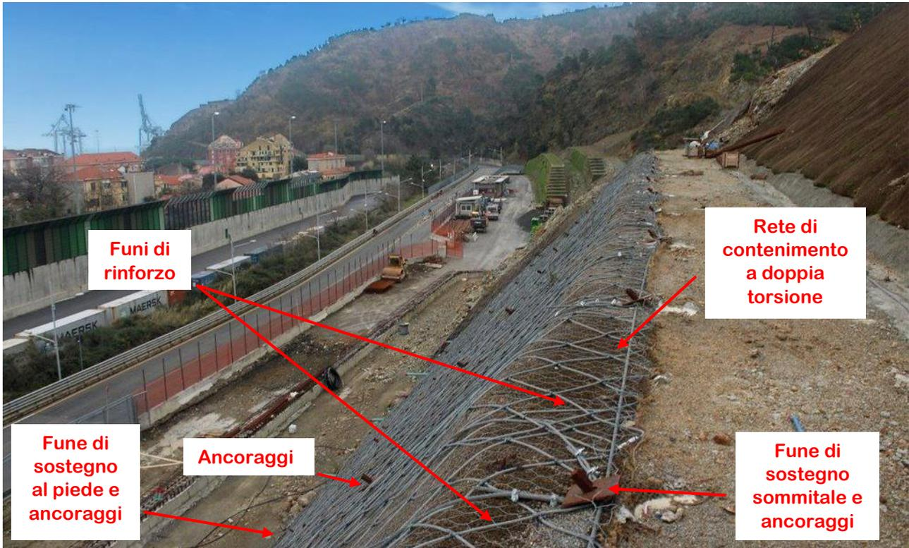
Figura 2.8: Rete in aderenza con chiodatura presente nel cantiere di Vado Ligure.
