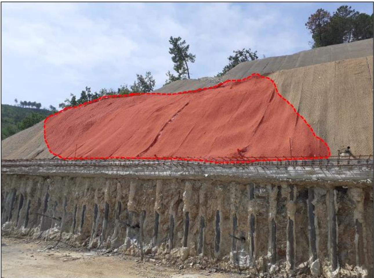
*Figura 4.33: Vista frontale del versante dove si è imposto il fenomeno gravitativo.*
