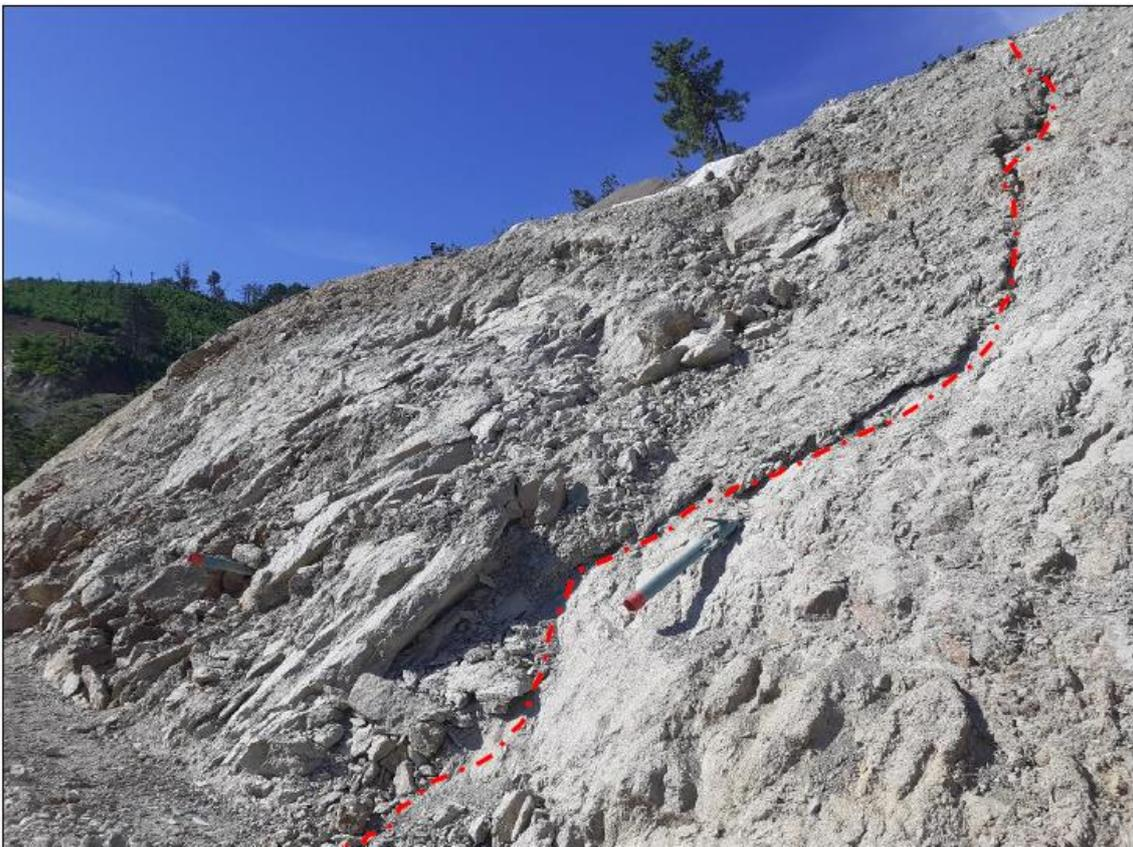
*Figura 4.38: Vista laterale lato nord del fenomeno gravitativo dopo la rimozione delle geostuoie.*
