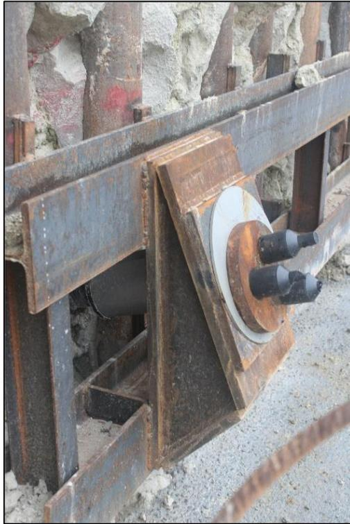
Figura 4.6: Esempio di tirante a 3 trefoli usato nel cantiere.
