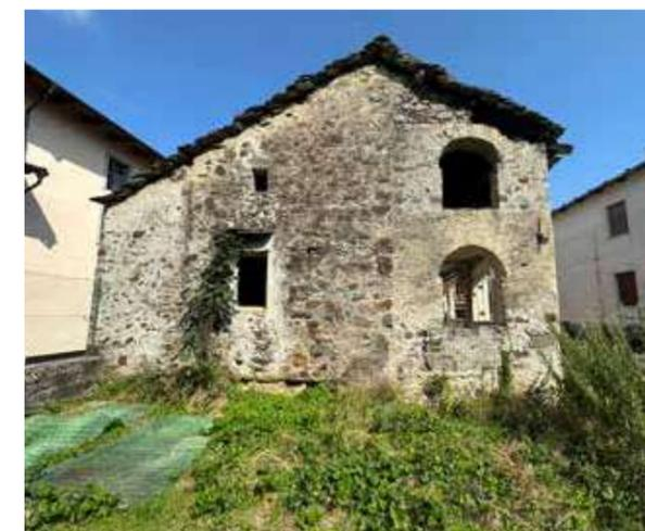
Fig. 58. Edificio n.11 , prospetto Ovest, ampliamento ed espansioni dell'edificio, Brosso, Valchiusella (TO)
