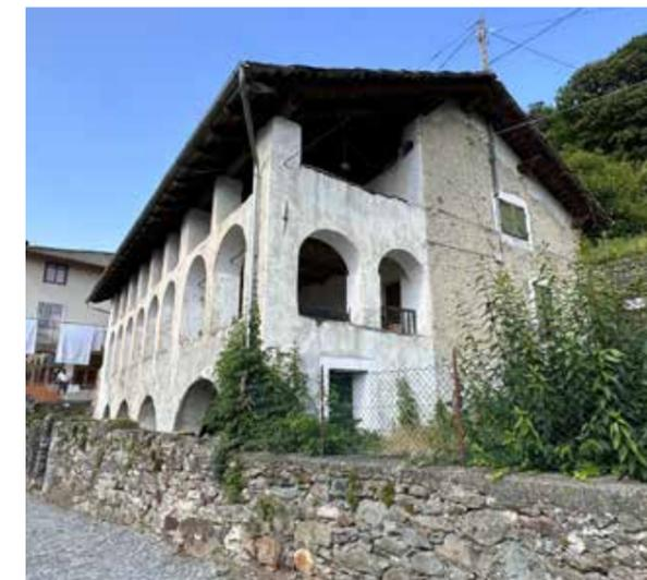
Fig. 56. Edificio n.5 , prospetto Sud-Ovest, ampliamento con aggiunta del loggiato, Brosso, Valchiusella (TO)
