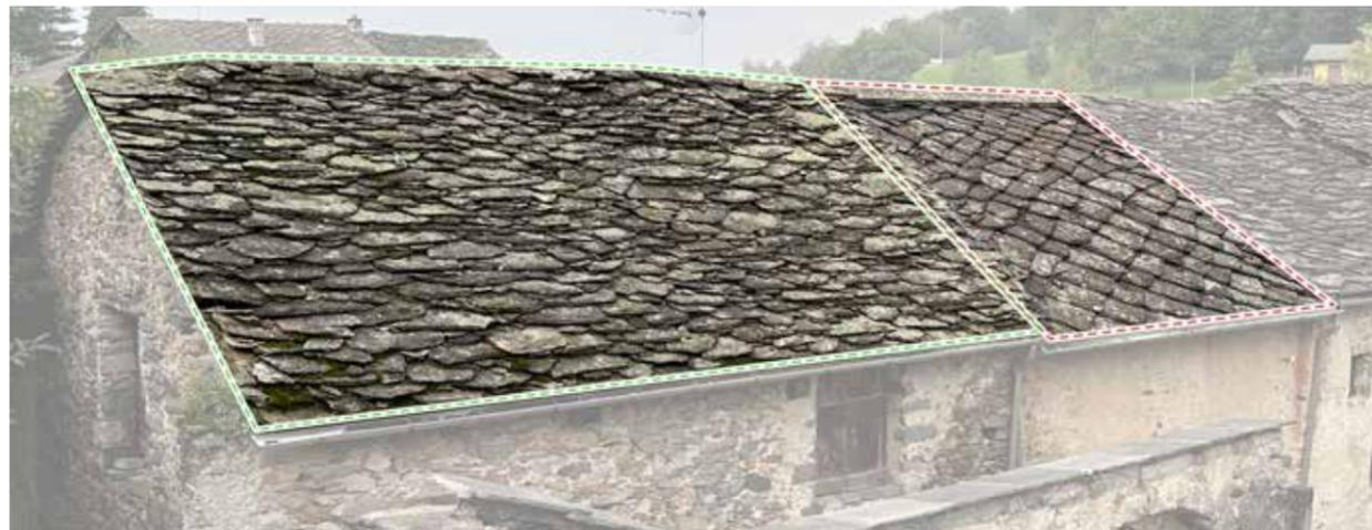
Fig. 08. Manti di copertura individuati nel paese coperture edifici n.3 e n.4, Brosso, Valchiussella (TO)
