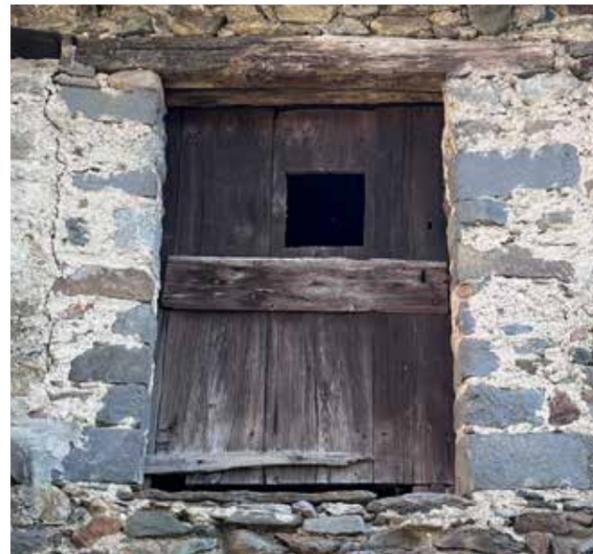
Fig. 54. Esempio di Portone in legno a battente singolo
