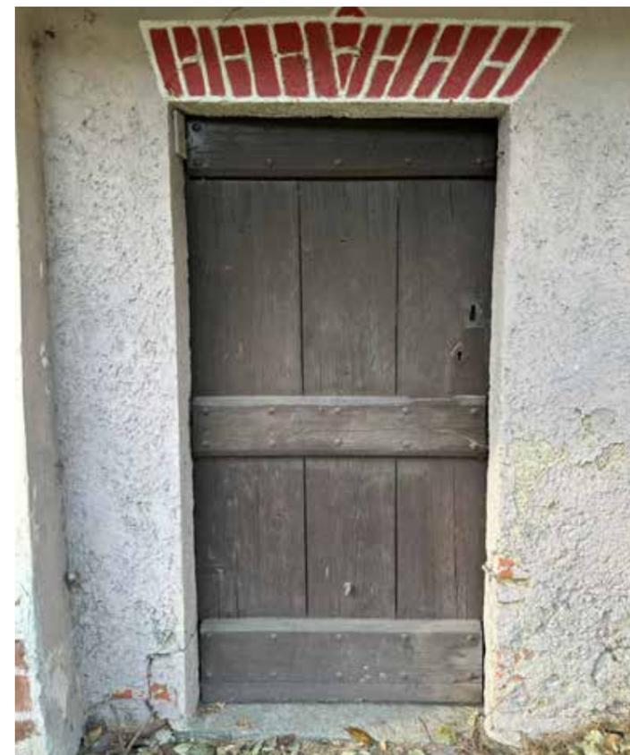
Fig. 32. Foto esplicativa della tipologia di porta in legno con anta singola, edificio n.8, prospetto Sud, Brosso, Valchiusella (TO)
