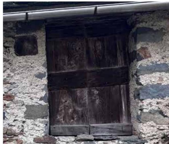
Fig. 53. Esempio di Portone in legno a doppio battente
