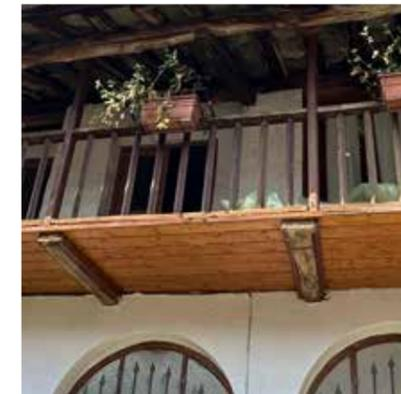
Fig. 14. Dettaglio del tavolato ligneo del ballatoio dell'edificio n.6, prospetto Sud-Est, Brosso, Valchiusella (TO)
