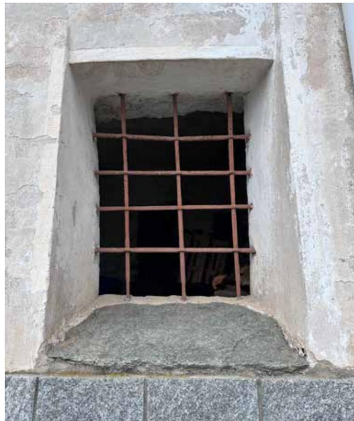
Fig. 47. Foto esplicativa della tipologia di piccole aperture rettangolari, edificio n.12, prospetto Sud-Est, Brosso, Valchiusella (TO)
