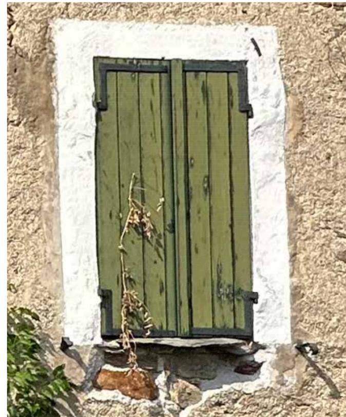
Fig. 53. Foto esplicativa della tipologia di scuri a pannello, edificio n.5., prospetto Sud, Brosso, Valchiusella (TO)
