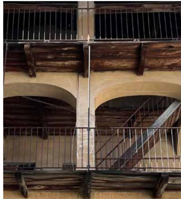
Fig. 44. Esempio di ballatoio in legno e ferro
