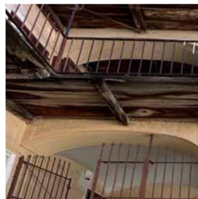
Fig. 18. Dettaglio dei correnti e dei montanti, edificio n.9, prospetto Sud, Brosso, Valchiusella (TO)
