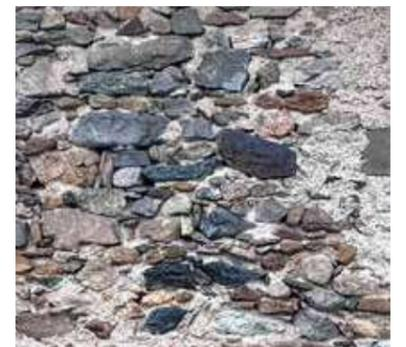
Fig. 17. Esempio di muratura a vista mista calce. Edificio n. 4
