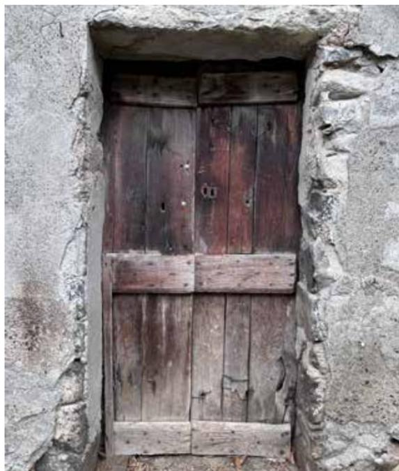
Fig. 30. Foto esplicativa della tipologia di porta in legno con doppia anta, edificio n.2, prospetto Sud., Brosso, Valchiusella (TO)
