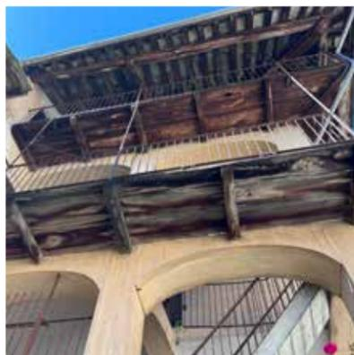
Fig. 17. Dettaglio del tavolato ligneo del ballatoio dell'edificio n.9, prospetto Sud, Brosso, Valchiusella (TO)
