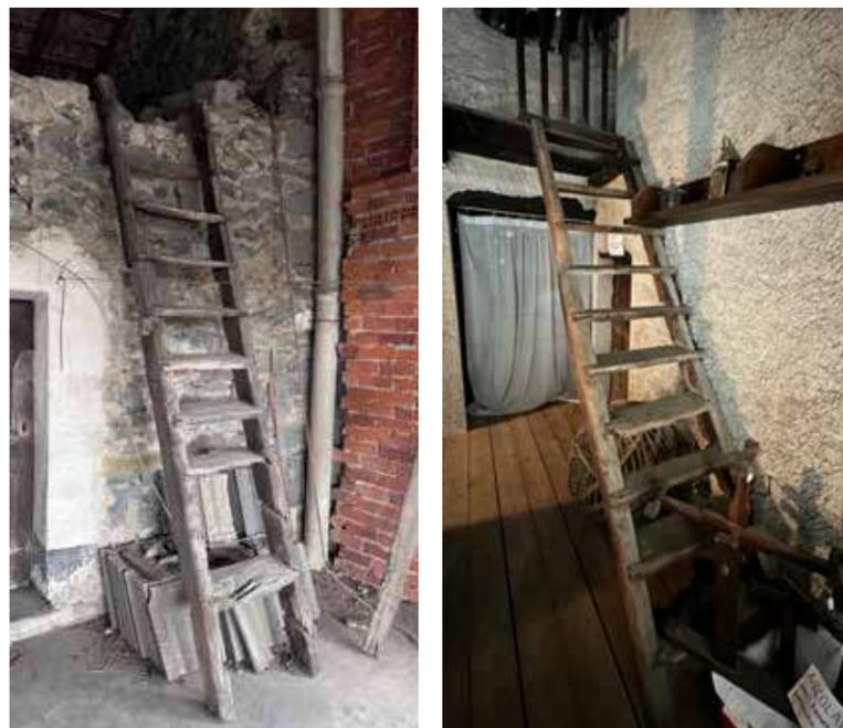
*Fig. 28. Foto esplicativa della tipologia di scala in legno a pioli, edificio n.12 e edificio n.6, Brosso, Valchiusella (TO)*
