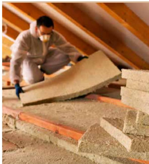
Fig. 38. Esempio di coibentazione in controfalda di un tetto preesistente.
