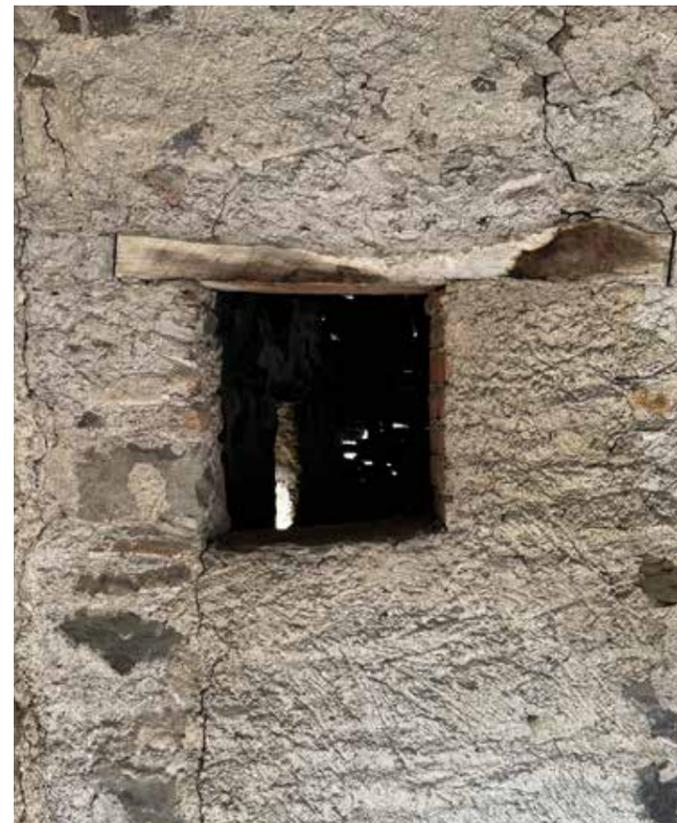
Fig. 49. Foto esplicativa della tipologia di finestra quadrata di grandi dimensioni, edificio n.11, prospetto Sud, Brosso, Valchiusella (TO)
