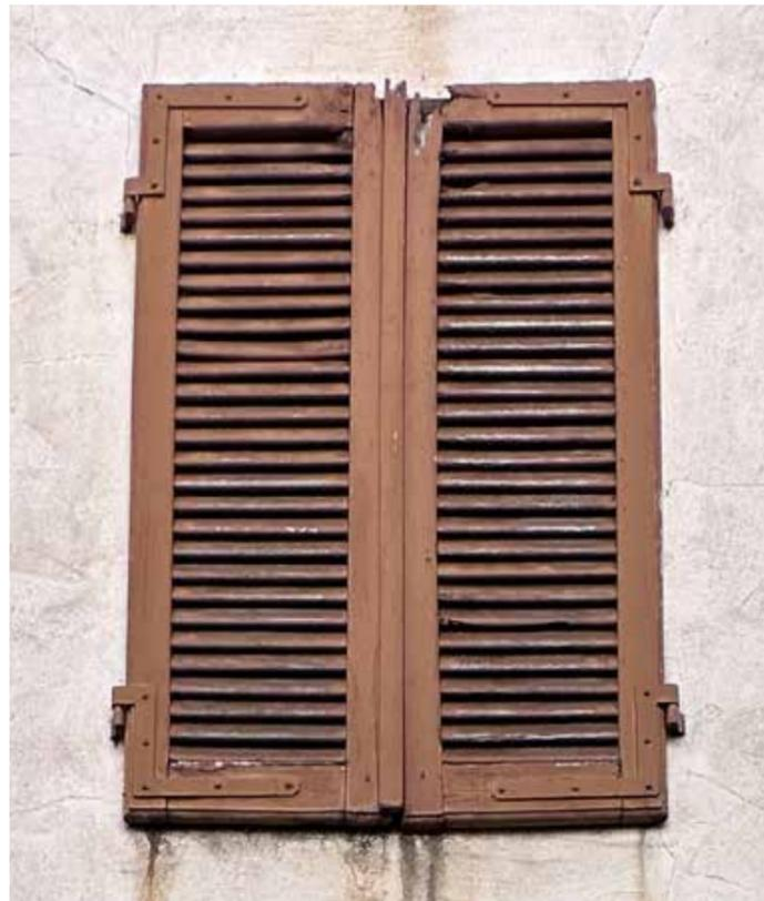
Fig. 51. Foto esplicativa della tipologia di scuri con doghe, edificio n.9, prospetto Nord, Brosso, Valchiusella (TO)
