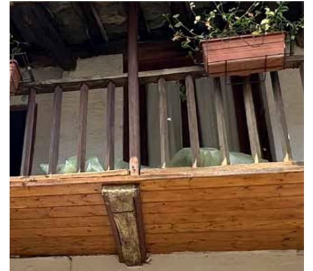
Fig. 42. Esempio di ballatoio in legno. L'immagine mostra una porzione del ballatoio appartenente all'edificio n.6, Brosso, Valchiusella (TO)
