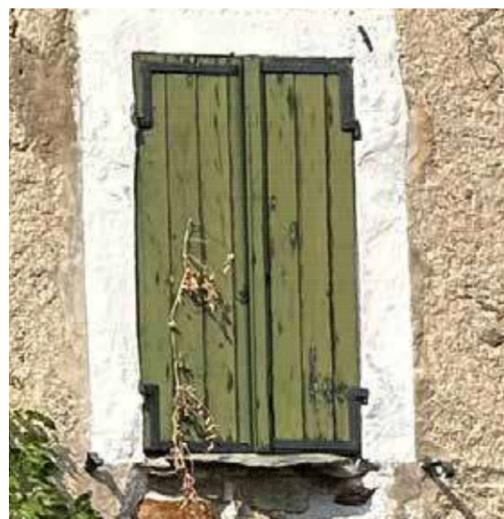
Fig. 97. Esempio di Scuro a pannello in legno
