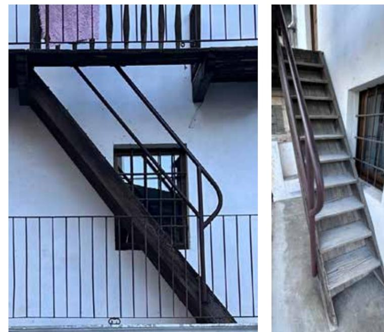
Fig. 26. Foto esplicativa della tipologia di scala in legno, edificio n.14, prospetto Sud, Brosso, Valchiusella (TO)
