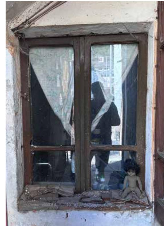
Fig. 41. Foto esplicativa della tipologia di finestra rettangolare, edificio n.9 , prospetto Est, Brosso, Valchiusella (TO)
