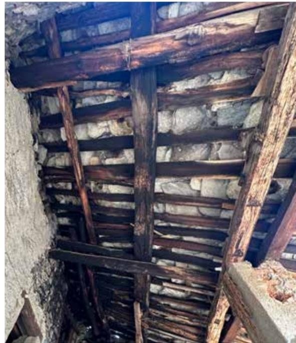
Fig. 34 Esempio di struttura in legno a puntoni
