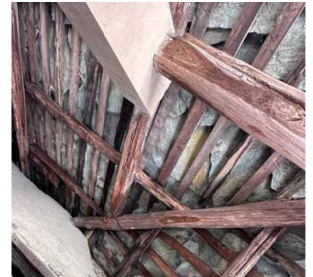
Fig. 32. Esempio di struttura in legno a puntone Edificio n.9, Brosso, Valchiusella (TO)
