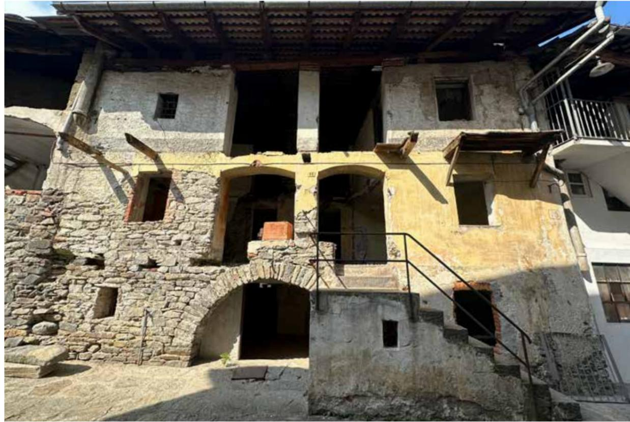
Fig. 35. Edificio loggiato bifamialere, con pilastro in pietrame, Brosso, Valchiusella (TO)
