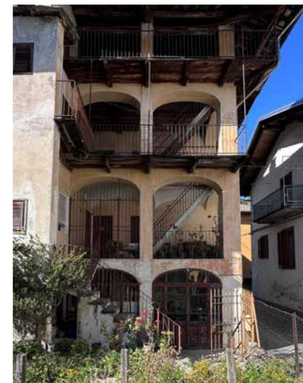
Fig. 26. Prospetto Sud con pilastri e solai voltati a crociera e lignei, ed. n.9, Brosso, Valchiusella (TO)
