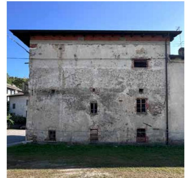
Fig. 95. Esempio di sostituzione e integrazione dei serramenti, edificio n.1, Brozzo, Valchiusella (TO)
