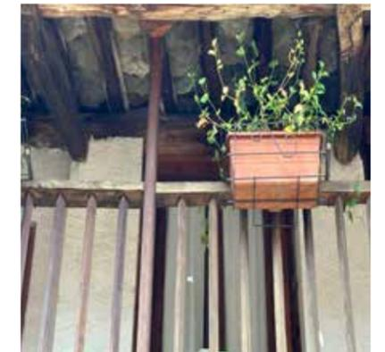
Fig. 15. Dettaglio del corrente superiore e dei montanti, edificio n.6, prospetto Sud-Est, Brosso, Valchiusella (TO)
