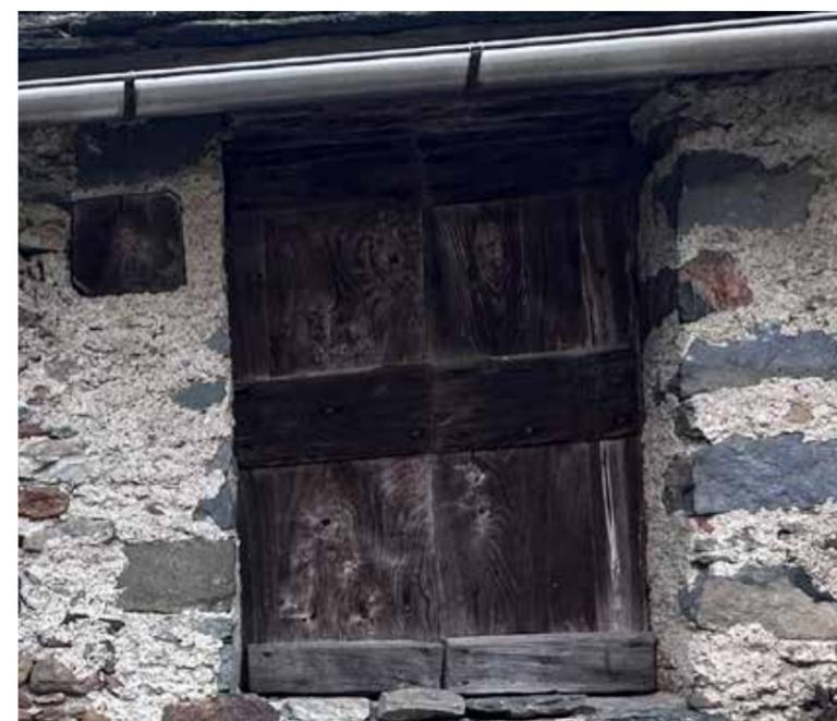
Fig. 34. Foto esplicativa della tipologia di portone in legno con doppia anta, edificio n.3, prospetto Nord, Brosso, Valchiusella (TO)
