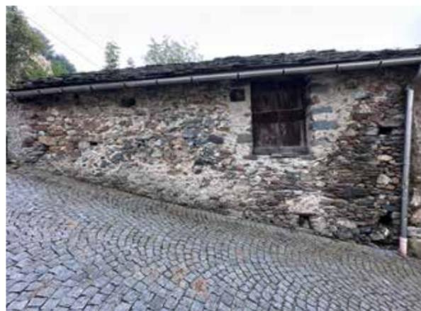
Fig. 63. Esempio di sostituzione e integrazione dei portoni, edificio n.4, Brosso, Valchiusella (TO)
