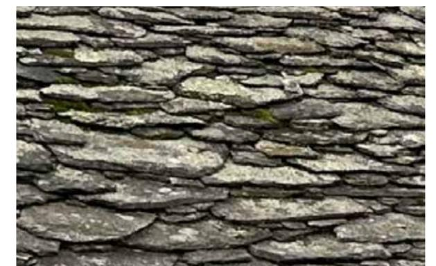
Fig. 33. Manto di copertura realizzato con lose irregolari a spacco naturale Edificio n.4, Brosso, Valchiusella (TO)
