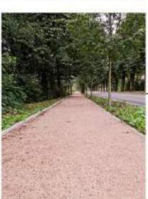
**PAVIMENTAZIONE IN CEMENTO DRENANTE**
