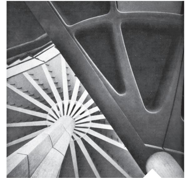
Fig. 23: Vista dal basso dei due elementi simbolo: Pilastro a fungo e soffitto con curve isostatiche, Atlas of Place.
