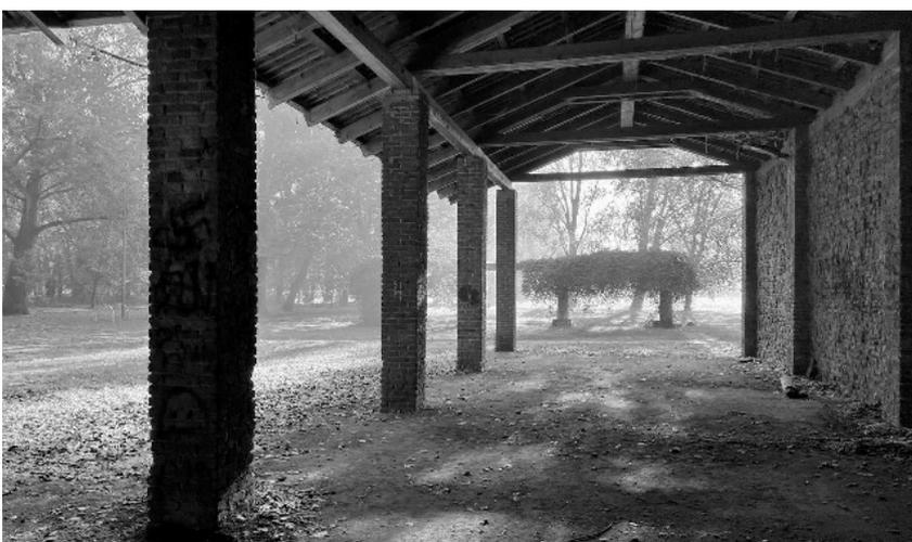
**Fig. 110** Copertura tettoia in legno e muratura in mattoni rossi.
