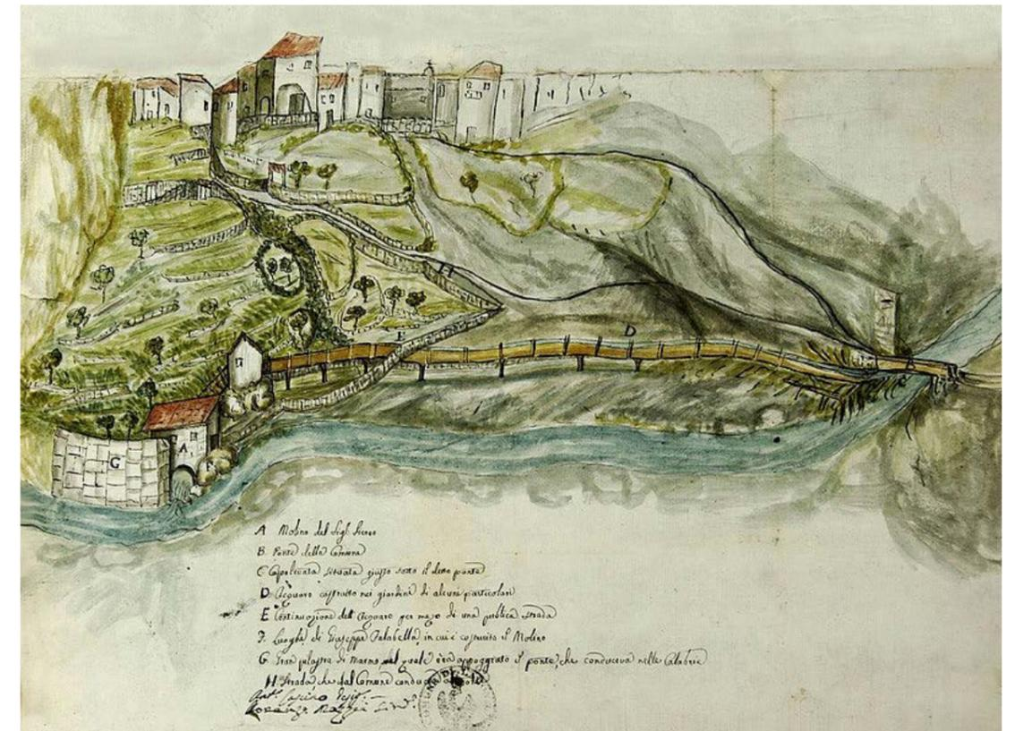
3\_Veduta del mulino del signor Siervo di Lagonegro (PZ) disegnata da Antonio Cascino; le macchine idrauliche sono posizionate a ridosso di canali di derivazione dell'acqua, sopraelevati per un lungo tratto su pali di legno, 1827 (AS Potenza, Fondo Intendenza di Basilicata, b. 622, fasc. 548)
