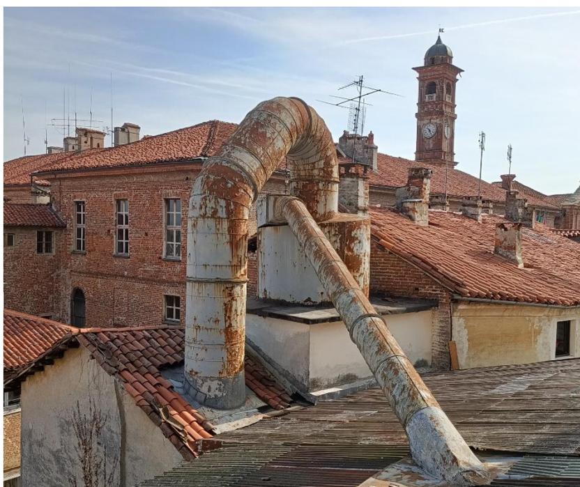
Fig. 33 – L'impianto dell'aspirazione trucioli visto dal piano terra della fabbrica.
