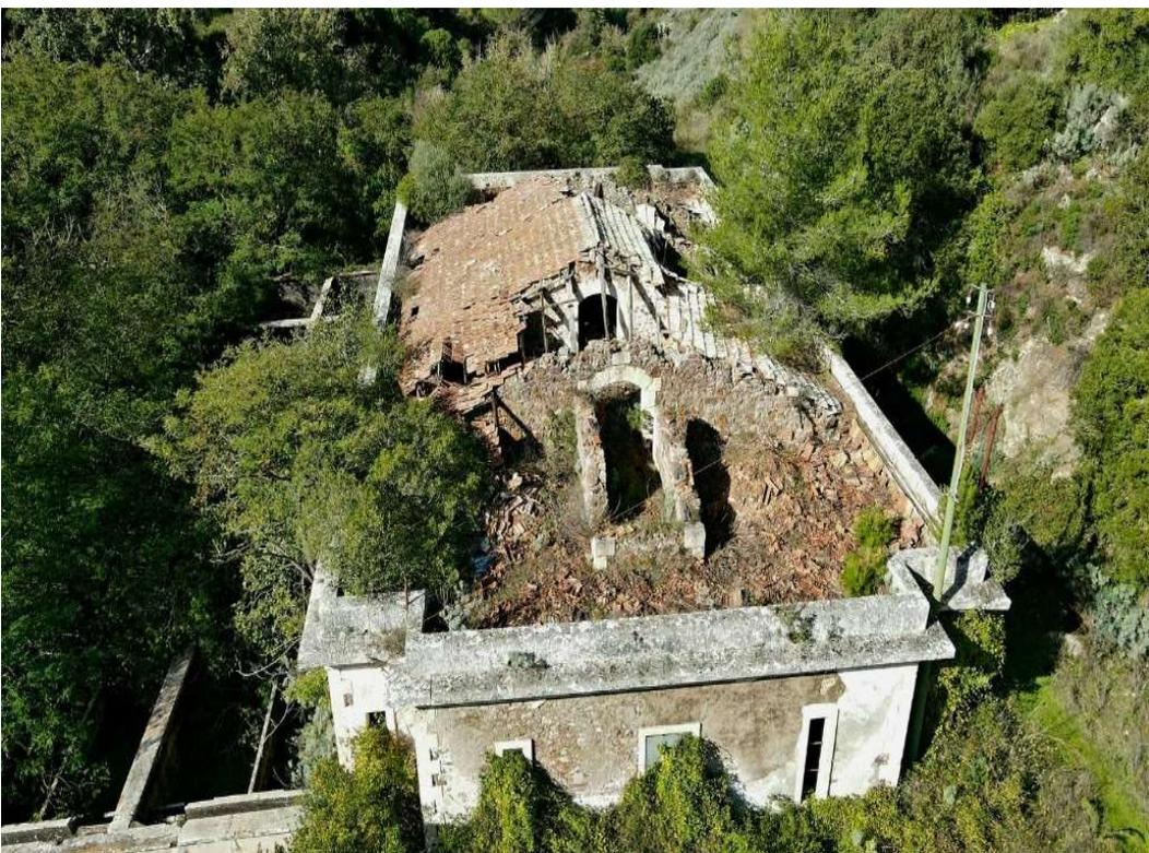
morfologia delle due falde più estese e, grazie ai cantonali, delle teste di padiglione. Le travi principali, di sezione considerevole, sono disposte parallelamente ai muri perimetrali. L'orditura secondaria degli arcarecci, di sezione più ridotta, è consequenzialmente trasversale. Lo stato di degrado in cui versano questa struttura e il manto di copertura ha permesso la deduzione della loro natura costruttiva.
