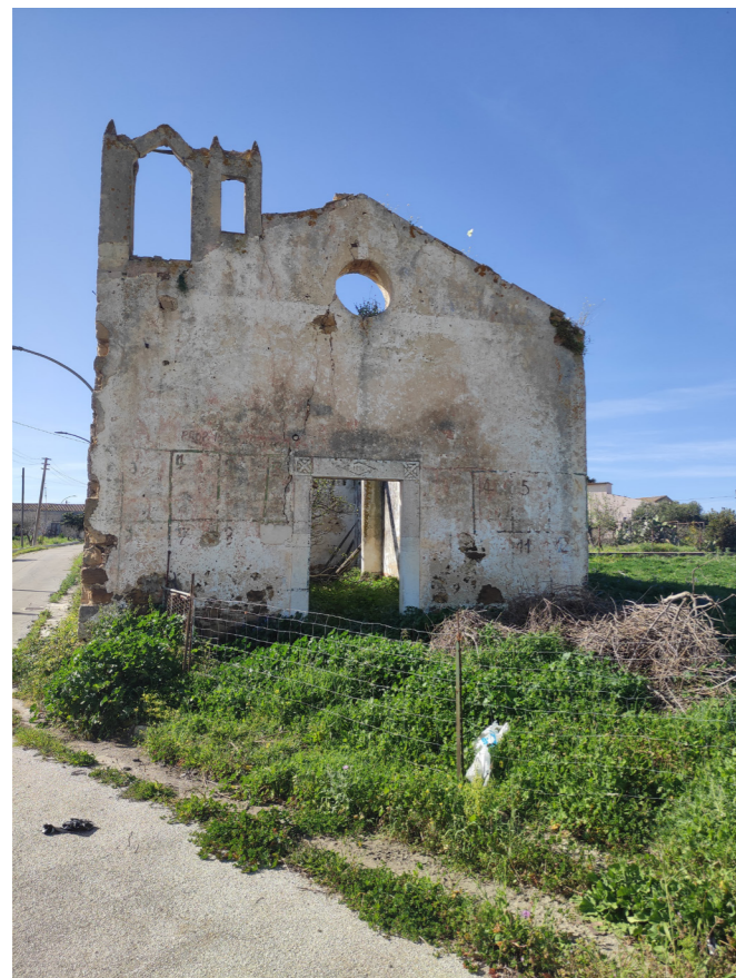
Figura: Foto stato di fatto dei resti della ex Chiesa dedicata a Maria SS. Immacolata
