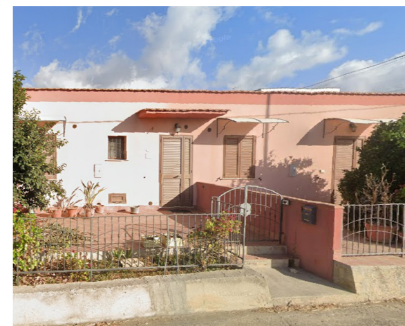
Figura: Edificio di colore rosa, fonte googlemaps
