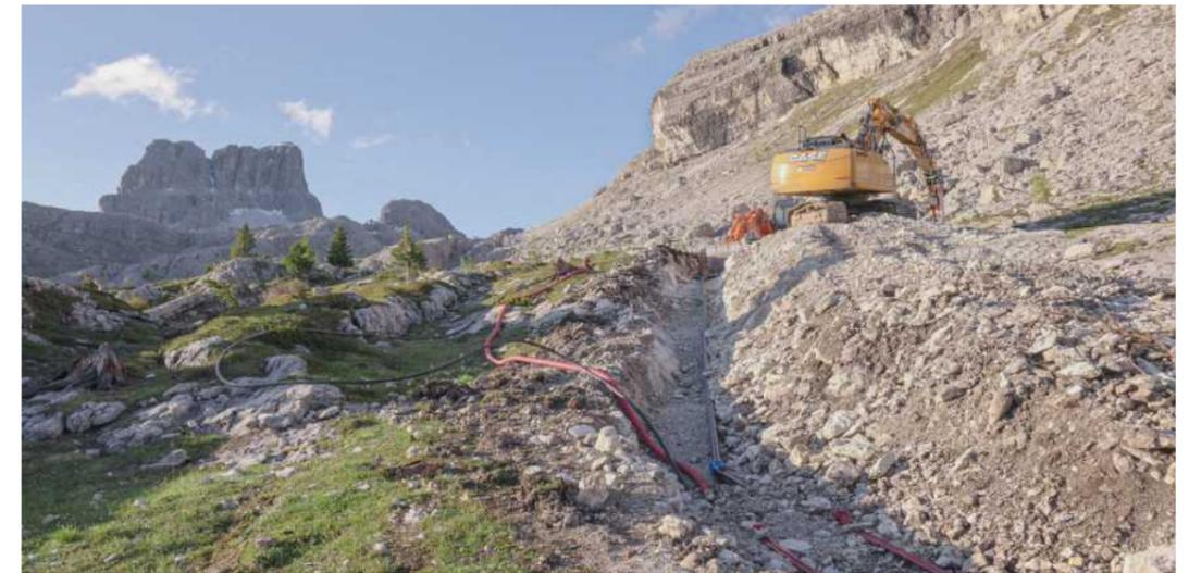
Fig 38 | Predisposizione condotti per infrastrutture per produrre innevamento artificiale
