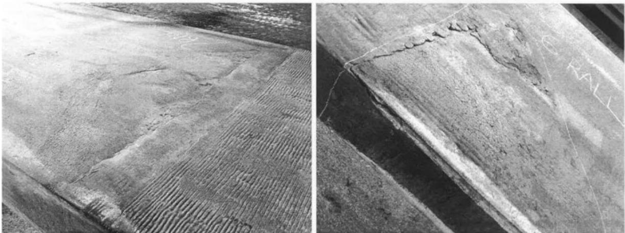
Figura 23 - Area caratterizzata da superficie irregolare senza tracce di oscillazione, più o meno estesa
