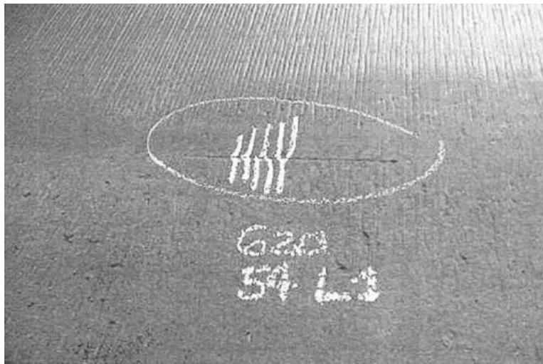
*Figura 20 - stretto avvallamento longitudinale associato ad irregolarità delle marche di oscillazione*
