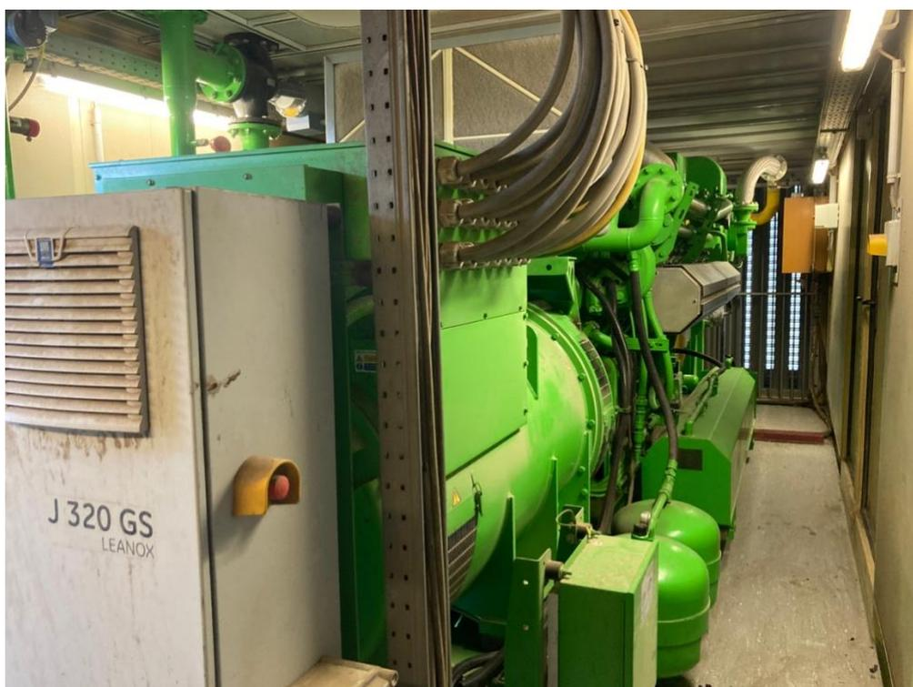
Figura 5.6 Motore Cogenerativo BIO-1
