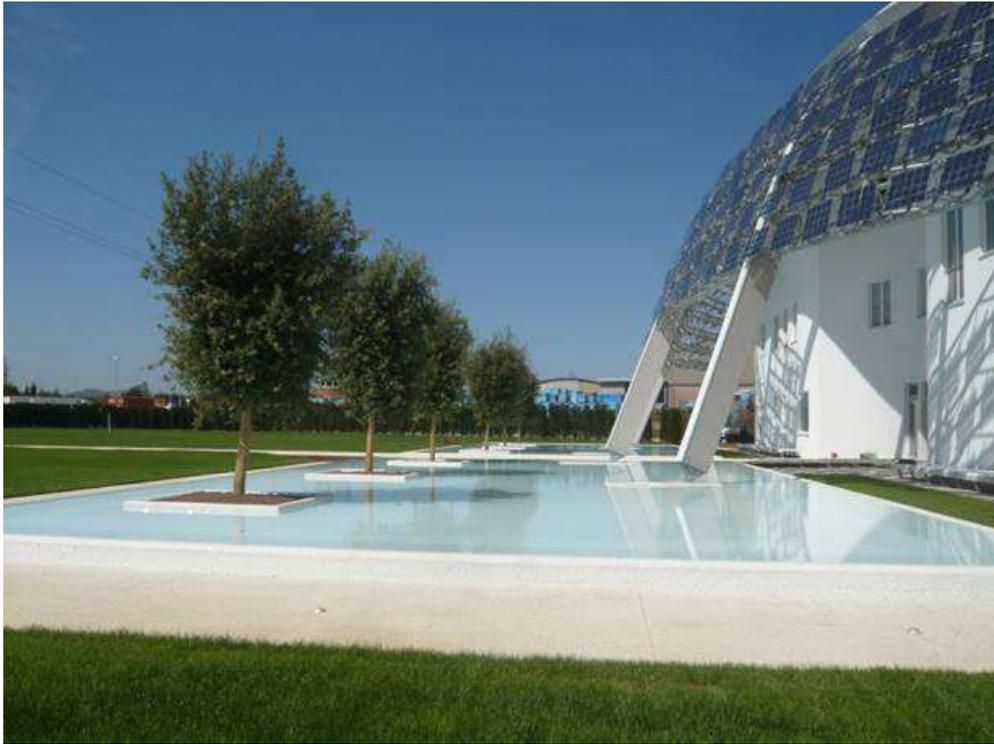
*Figura 54: Vasche d'acque per recupero acque piovane presso il centro ricerche Kerakoll (Sassuolo - MO), progettata da IRIDRA, in collaborazione con BIOS-IS S.r.l. (FONTE: <http://www.irdra.eu>)*
