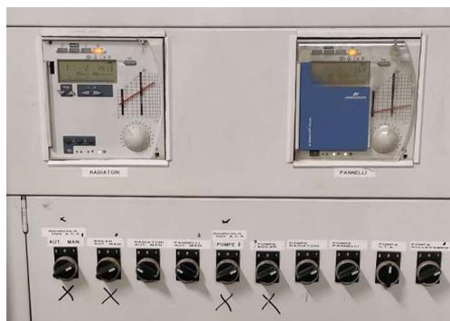
**Fig.18 Pannello di gestione dei circuiti di riscaldamento**
