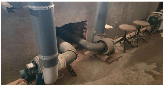
Fig.22 Motore di aspirazione con canalizzazione
