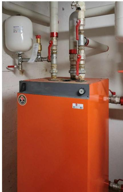
**Fig.17 Serbatoio di accumulo**
