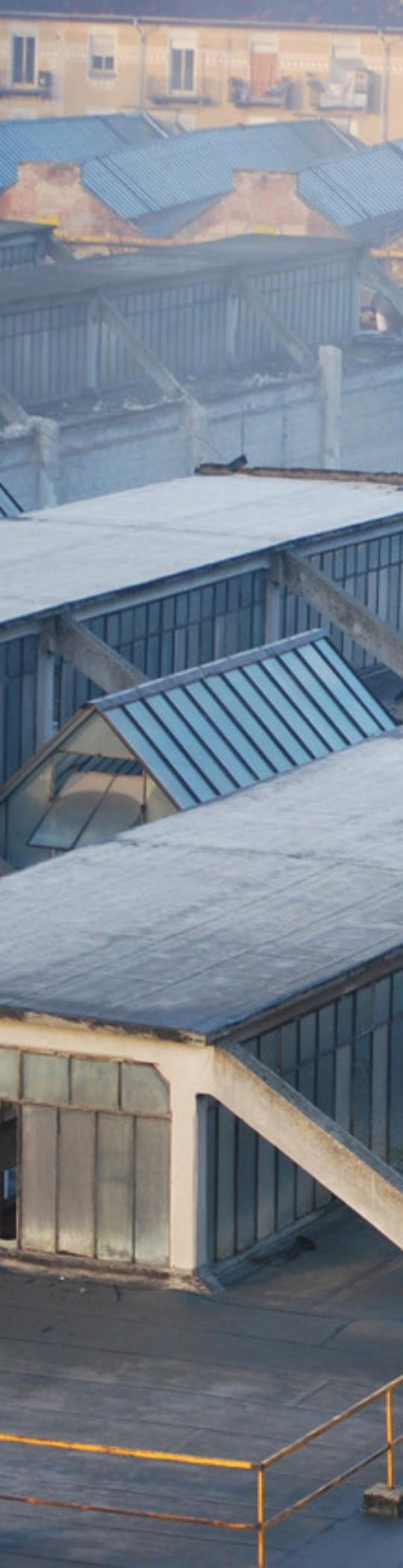
La struttura portante è in cemento con ampie vetrate presenti in facciata a tutta altezza divise da sottili lesene che scandiscono il ritmo del fronte, dividendo il prospetto tramite un sistema a griglia di assi verticali e orizzontali.
