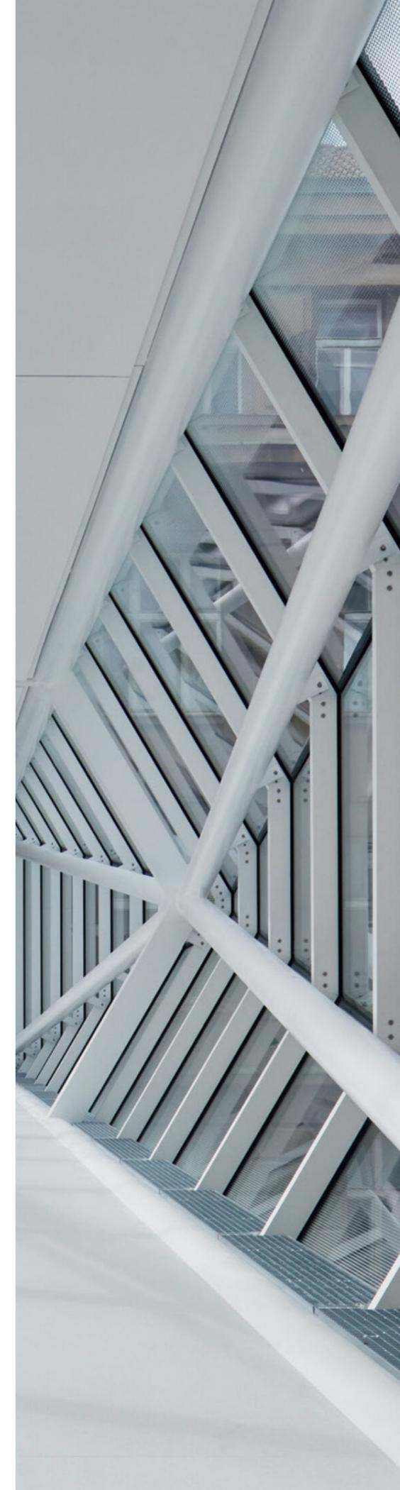
Dal punto di vista materico i due ponti sono chiusi da doppi vetri termoisolanti con giunto sigillato, completati da un soffitto piano che rafforza la struttura ed evita un surriscaldamento eccessivo dovuto all'effetto serra.
