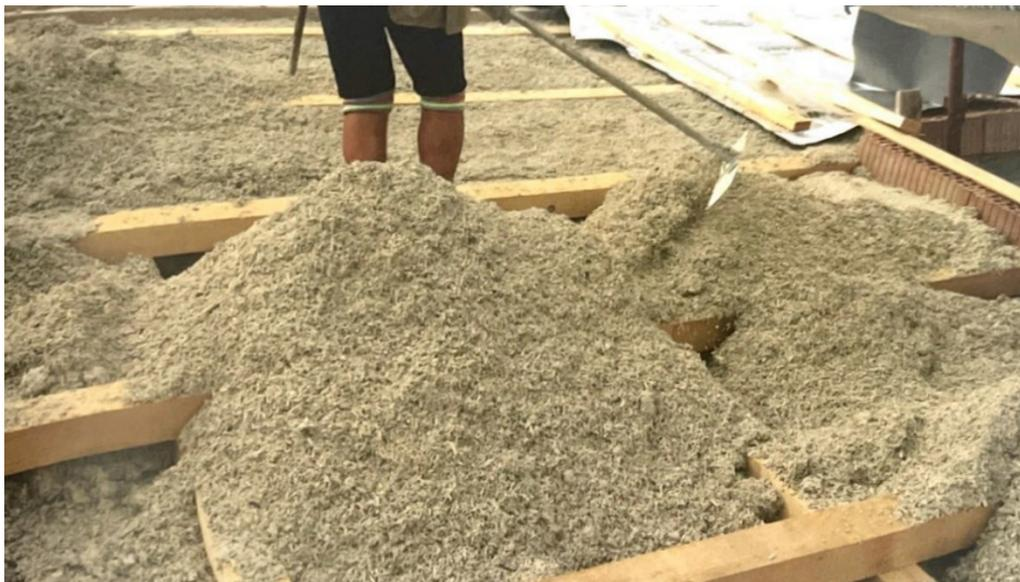
**Figura 3.5:** esempio posa miscela di calce-canapa sul solaio di copertura<sup>121</sup>
