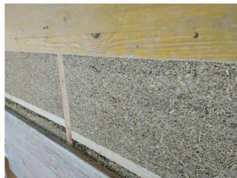
**Figura 2:** dettaglio raffigurante la realizzazione dei casseri per l'esecuzione dell'isolamento in calce-canapa
