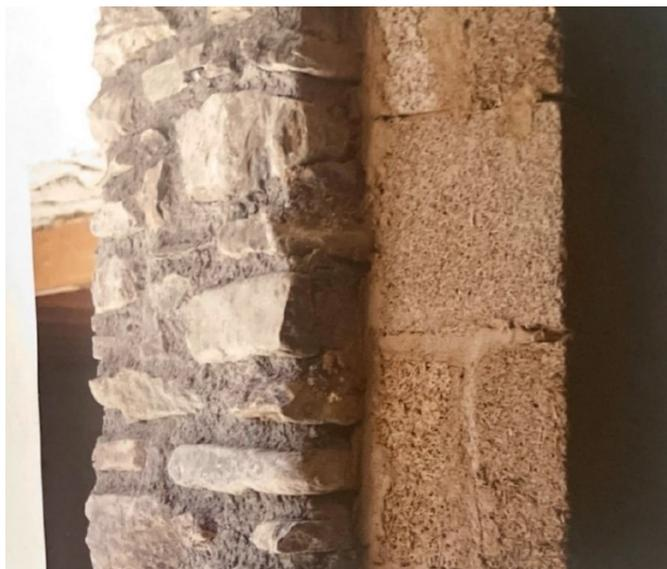
**Figura 3.21:** particolare di una muratura perimetrale con blocco in calce-canapa applicato sulla muratura esistente<sup>154</sup>
