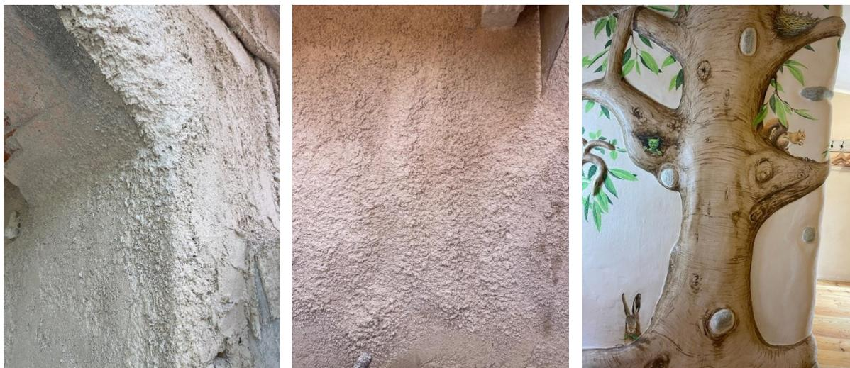
**Figura 4.28:** le prime due fotografie mostrano l'applicazione esterna del biocomposito in calce-canapa, l'ultima mostra un basso rilievo in calce-canapa
