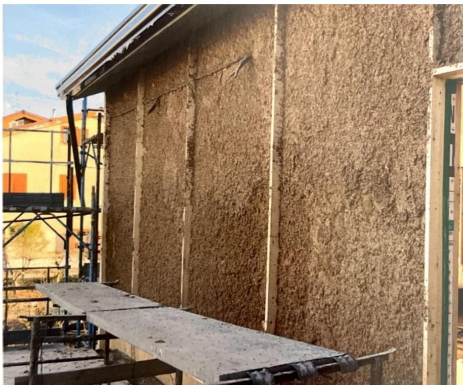
Figura 3.8: posa del primo strato di termointonaco sull'esterno di un'abitazione<sup>126</sup>
