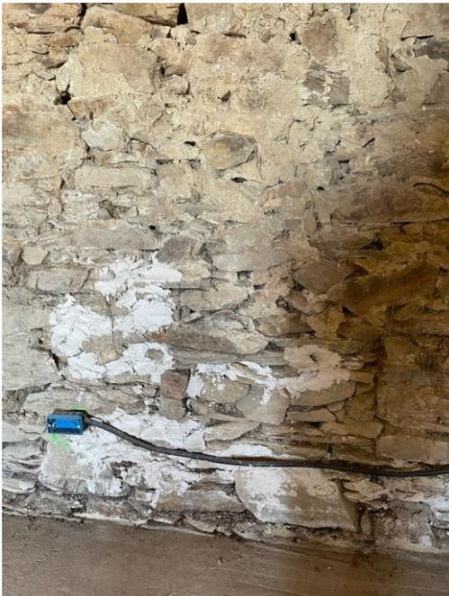
**Figura 4.20:** dettaglio esecuzione impianti: lo spessore del calce-canapa consente di non dover rompere la muratura per inserire gli impianti
