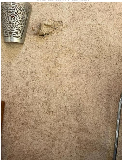
**Figura 4.24:** dettaglio raffigurante una finitura in calce-canapa
