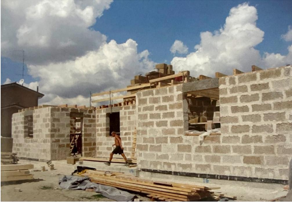
**Figura 3.19:** esempio applicazione blocchi di calce-canapa<sup>146</sup>
