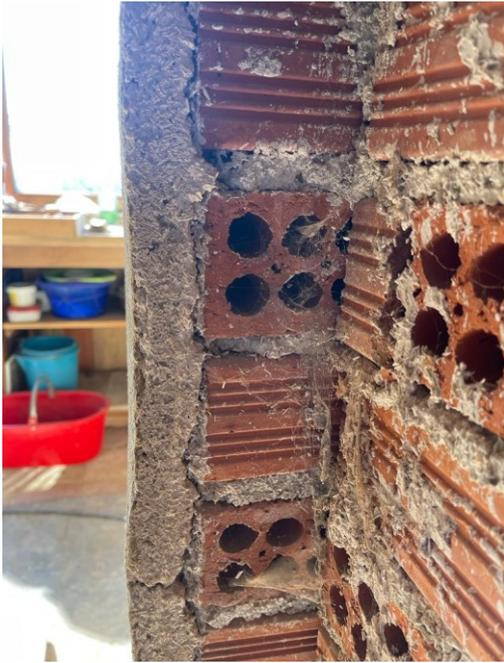
**Figura 9:** dettaglio raffigurante lo spessore dell'intonaco interno
