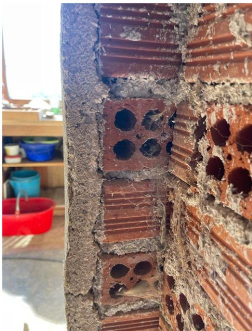
**Figura 4.22:** dettaglio raffigurante lo spessore dell'intonaco interno
