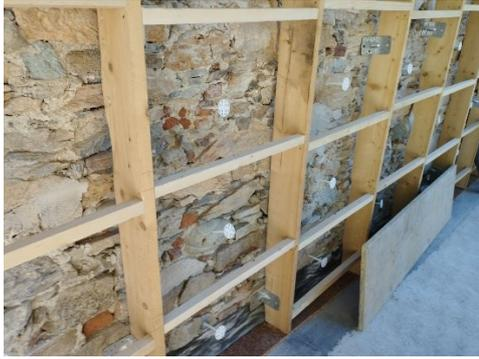
**Figura 3:** dettaglio esecuzione dei casseri durante l'applicazione del calce-canapa
