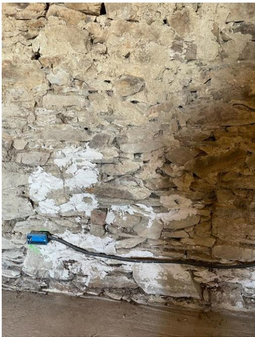
**Figura 7:** dettaglio esecuzione impianti: lo spessore del calce-canapa consente di non dover rompere la muratura per inserire gli impianti
