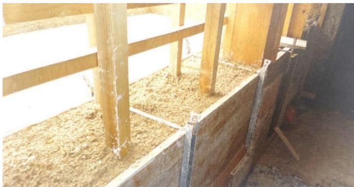
**Figura 3.17:** esempio di un getto in calce-canapa con casseri per la realizzazione di una muratura di tamponamento<sup>143</sup>
