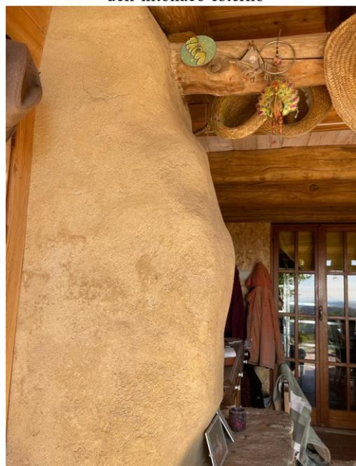
**Figura 4.25:** dettaglio raffigurante la finitura in argilla sul calce-canapa eseguita seguendo l'andamento del muro esterno
