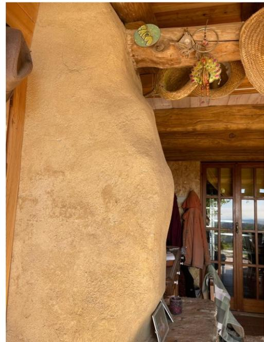
**Figura 12:** dettaglio raffigurante la finitura in argilla sul calce-canapa eseguita seguendo l'andamento del muro esistente
