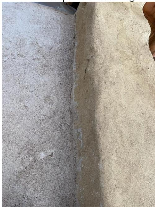
**Figura 8:** dettaglio raffigurante a sinistra lo strato grezzo del calce-canapa e a destra l'intonaco finito in argilla
