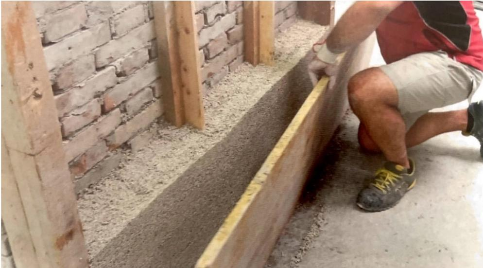
**Figura 3.22:** esecuzione di una controparete di un muro esistente in calce-canapa<sup>156</sup>
