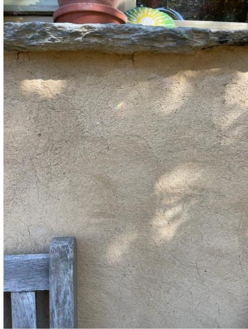
**Figura 4.19:** dettaglio esterno intonaco di calce-canapa con finitura in argilla
