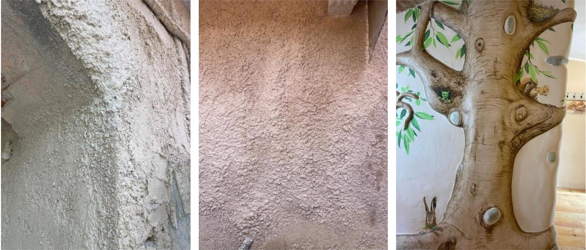
**Figura 15:** le prime due fotografie mostrano l'applicazione esterna del biocomposito in calce-canapa, l'ultima mostra un basso rilievo in calce-canapa
