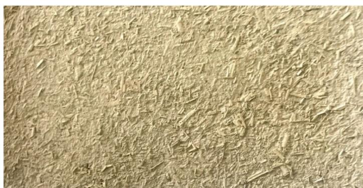
**Figura 3.10:** dettaglio intonaco calce-canapa eseguito con una granulometria di canapulo media<sup>128</sup>
