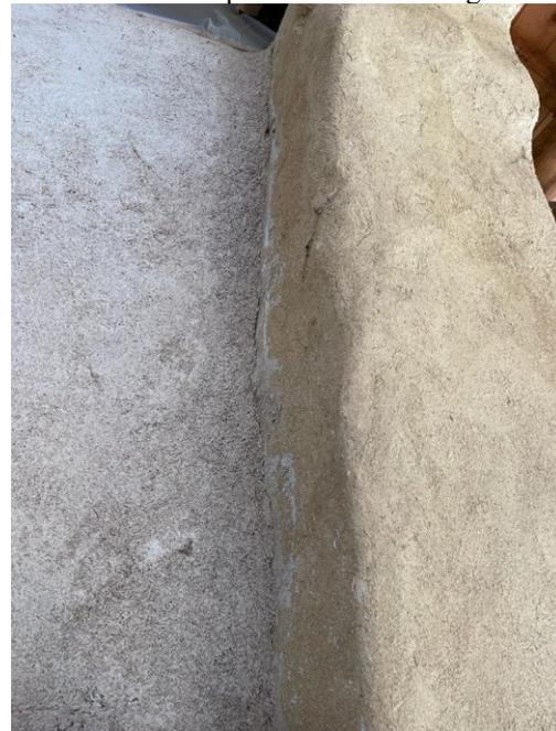
**Figura 4.21:** dettaglio raffigurante a sinistra lo strato grezzo del calce-canapa e a destra l'intonaco finito in argilla
