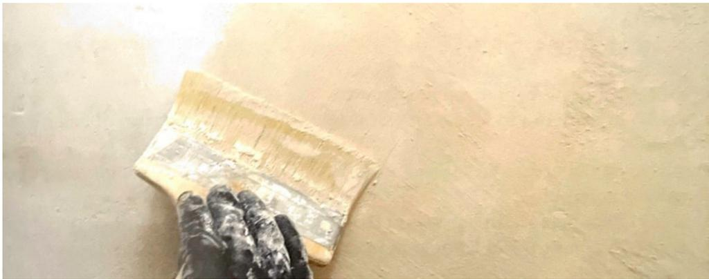
**Figura 3.12:** pittura in calce-canapa<sup>132</sup>
