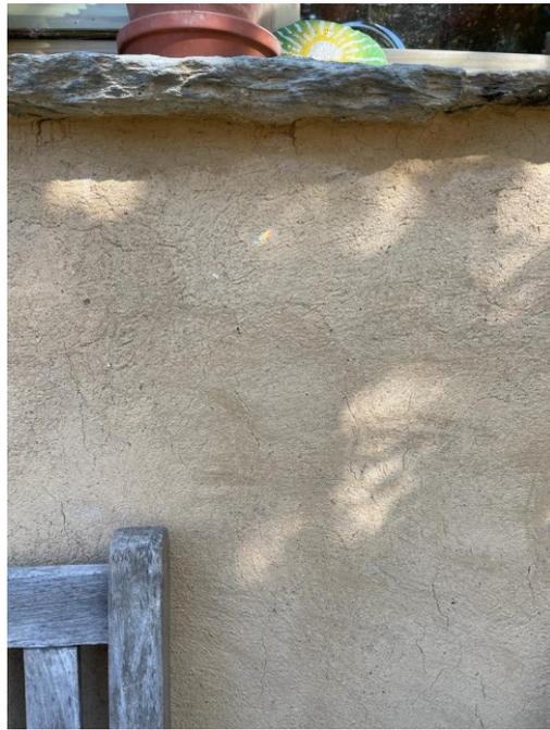
**Figura 6:** Dettaglio esterno intonaco di calce-canapa con finitura in argilla
