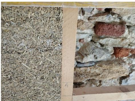
**Figura 1:** dettaglio esecutivo della realizzazione dell'isolamento in calce-canapa raffigurante anche la muratura esistente
