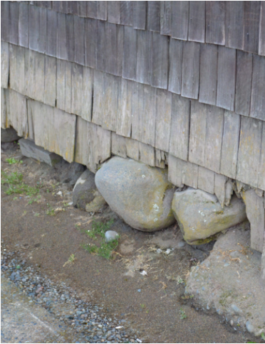
Figura 56: Fondazione della chiesa di Achao
