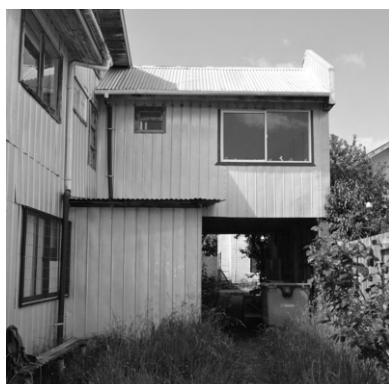
Figura 17: Giardino retrostante dell'edificio
