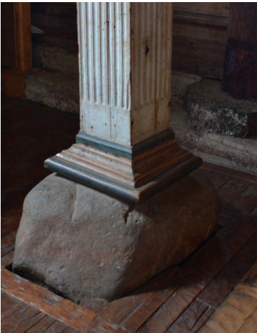
Figura 57: Fondazione della chiesa di Achao
