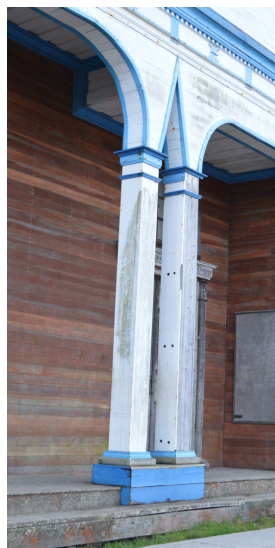
Figura 53: Pilastro della chiesa di Tenaún
