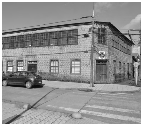
Figura 15: Facciata dell'edificio caso studio
