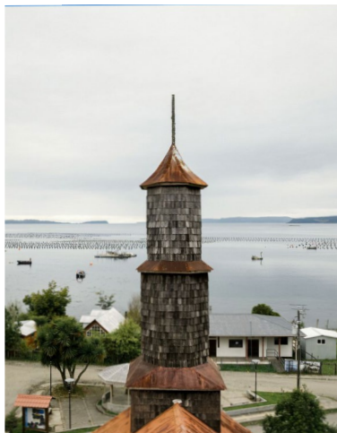
Figura 61: Torra campanaria della chiesa di Quehui
