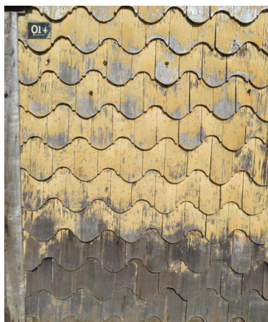
Figura 71: Tejuelas di un edificio di Achao
