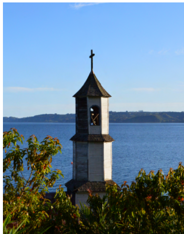
Figura 59: Torre campanaria della chiesa di Chelín
