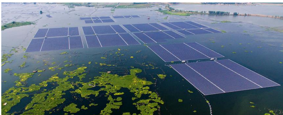
Figura 7 - Impianto fotovoltaico galleggiante
