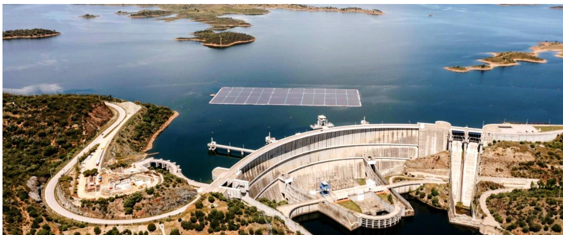
Figura 9 - Impianto fotovoltaico galleggiante (diga dell'Alto Rabagão)
