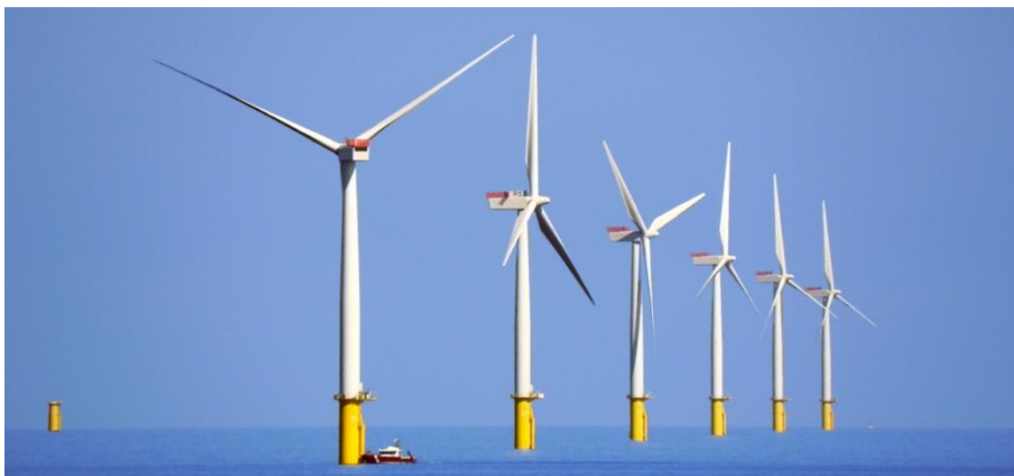
Figura 10 - Parco eolico offshore (Beleolico)
