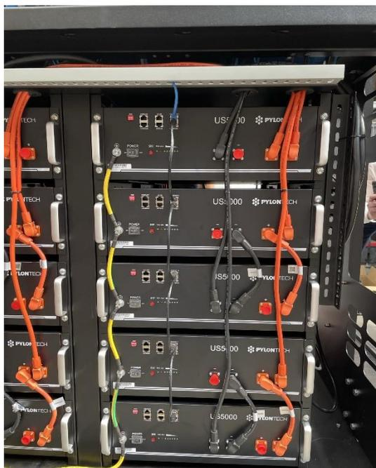
Figura 44- Particolare nuovo pacco batterie
