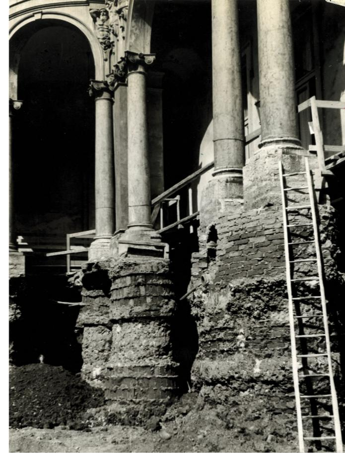
**fig.21** Foto di cantiere: le vecchie fondazioni a pozzo in muratura di laterizio messe a nudo durante la prima fase dello scavo.
