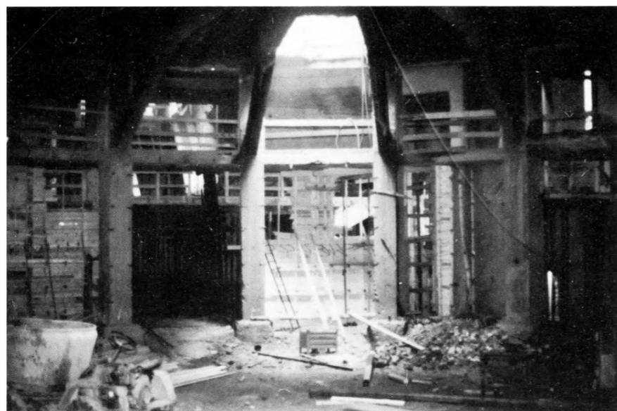
**fig. 35** Fotografia di cantiere: casseri in legno e posa dei ferri di armatura per il getto della copertura del salone.
