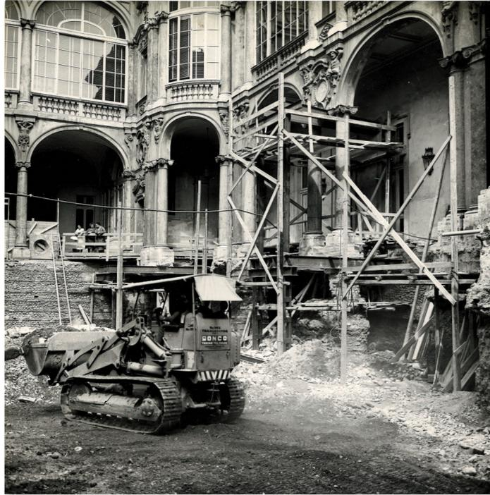
**fig.19** Foto di cantiere: prima fase dello scavo, si intravedono le fondazioni a pozzo tra le incastellature lignee.
