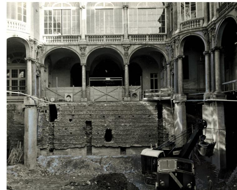
**fig.25** Sottofondazioni in calcestruzzo armato (alte circa 7m) del gruppo di colonne all'angolo sud-ovest del porticato sul cortile.
