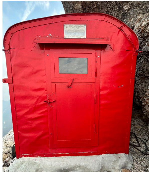
Fronte Bivacco Suringar dopo i lavori di manutenzione
