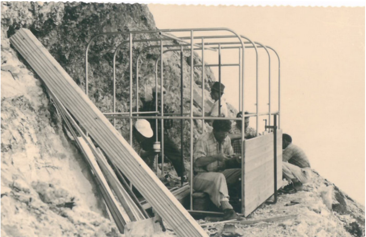
Foto del cantiere sulla parete Nord del Bivacco Suringar
