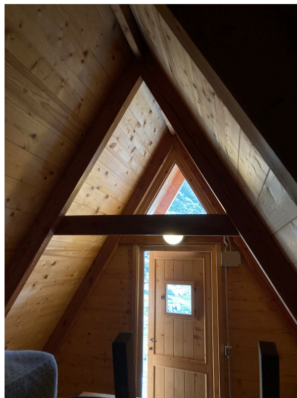
Dettaglio copertura interna
