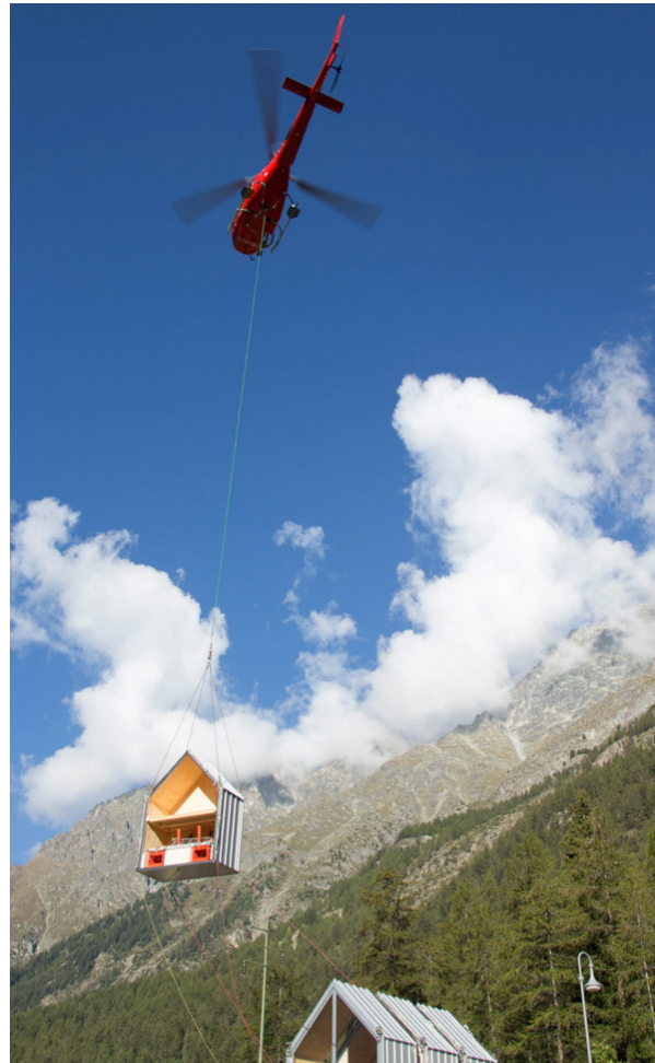
Fig. 13 | Elitrasporto dei singoli moduli in loco post pre-assemblaggio a valle, Bivacco Pasqualetti, Valpelline, Ao, 2017
