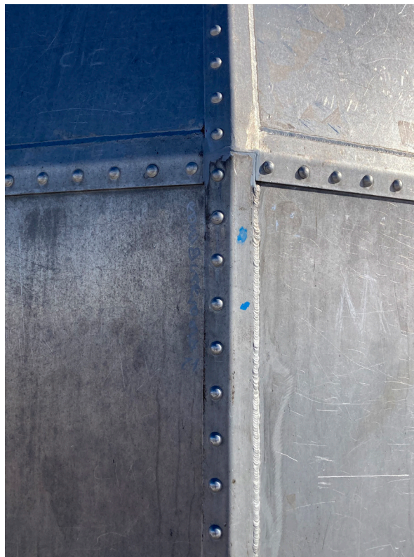
Dettaglio giunti rivestimento esterno
