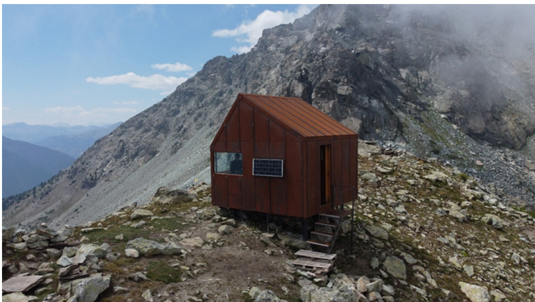
Bivacco Salvasera, esempio di struttura rivestita in corten, Val Pellice, Cn, 2021
