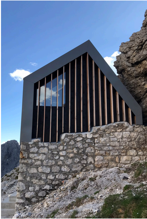
Esterno parete laterale finestrata
