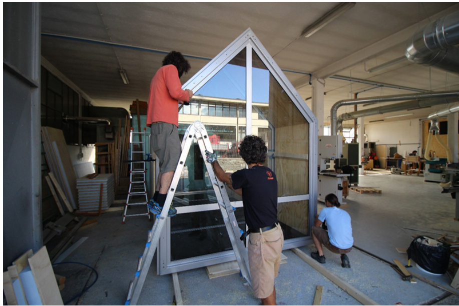
Fig. 15 | Fasi avanzate primo assemblaggio bivacco Pasqualetti in officina, Ollmont, Ao, 2017
