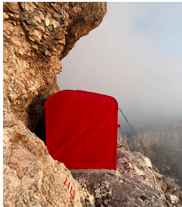
Retro Bivacco Suringar dopo i lavori di manutenzione
