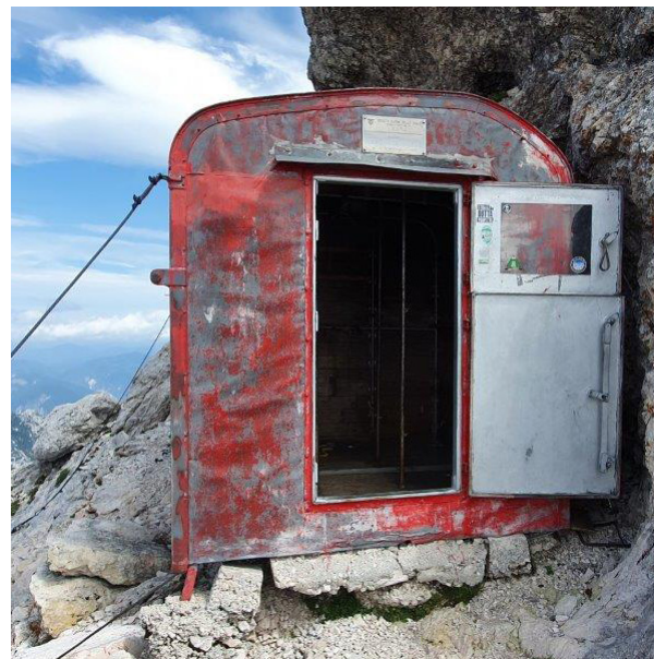
Fig. 44 | Stato di fatto del Bivacco Suringar prima dei lavori di manutenzione
