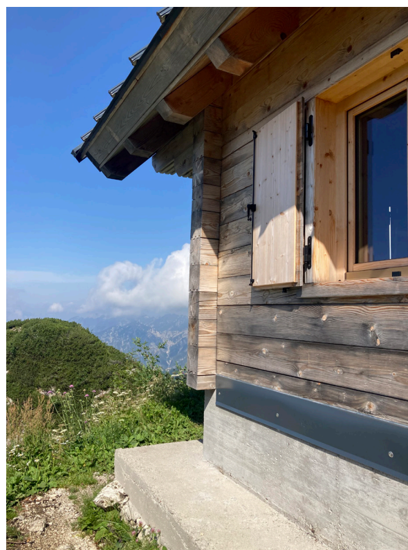
Esterno con basamento di cemento
