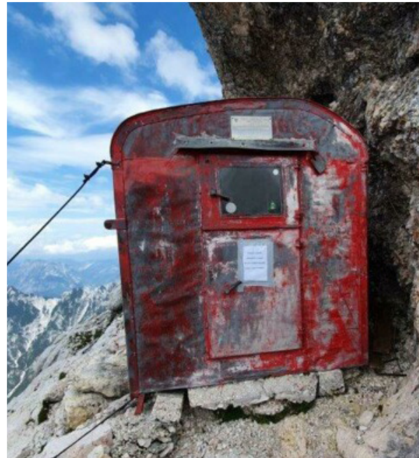
Stato di fatto del Bivacco Suringar prima dei lavori di manutenzione
