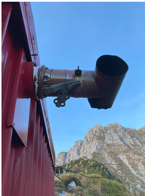
Dettaglio camino esterno
