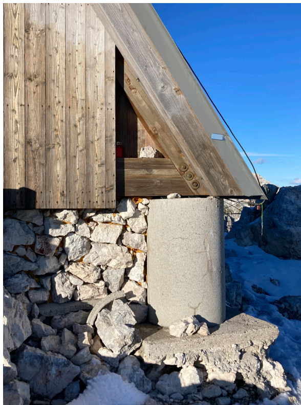
Dettaglio pilastri di cemento
