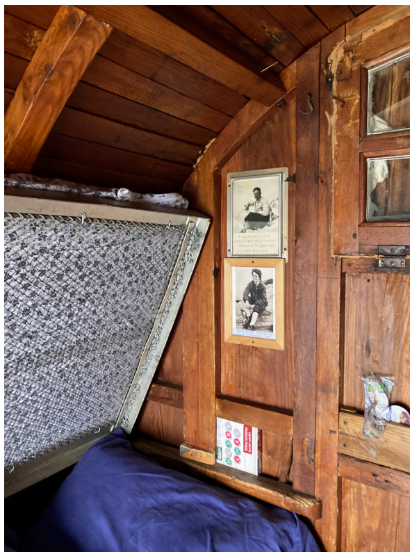
Dettaglio pareti interne
