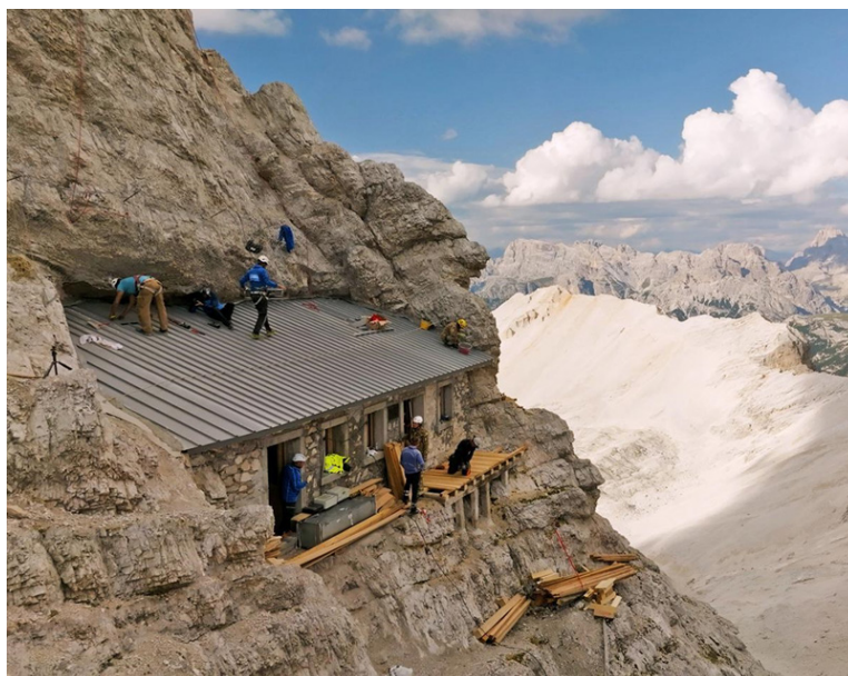
Fig. 16 | Lavori di ripristino bivacco Buffa di Perrero al Cristallo, Cortina d'Ampezzo, BI, 2021
