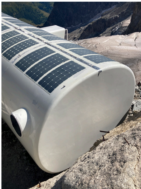
Copertura esterna con pannelli solari
