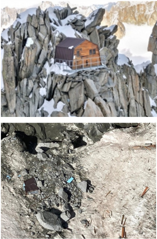
Fig. 23 | Bivacco Alberico Borgna pre crollo (2018) e post crollo (2022)
