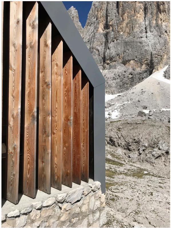
Dettaglio parete con assi di legno
