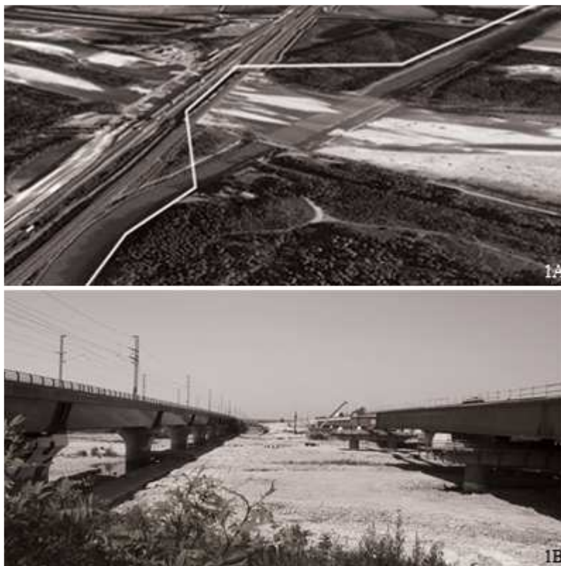
Fig.1A: il sito di progetto in una vista aerea; Fig.1B: larghezza dell'alveo del Sesia, nell'area compresa tra le infrastrutture della TAV e dell'A4
