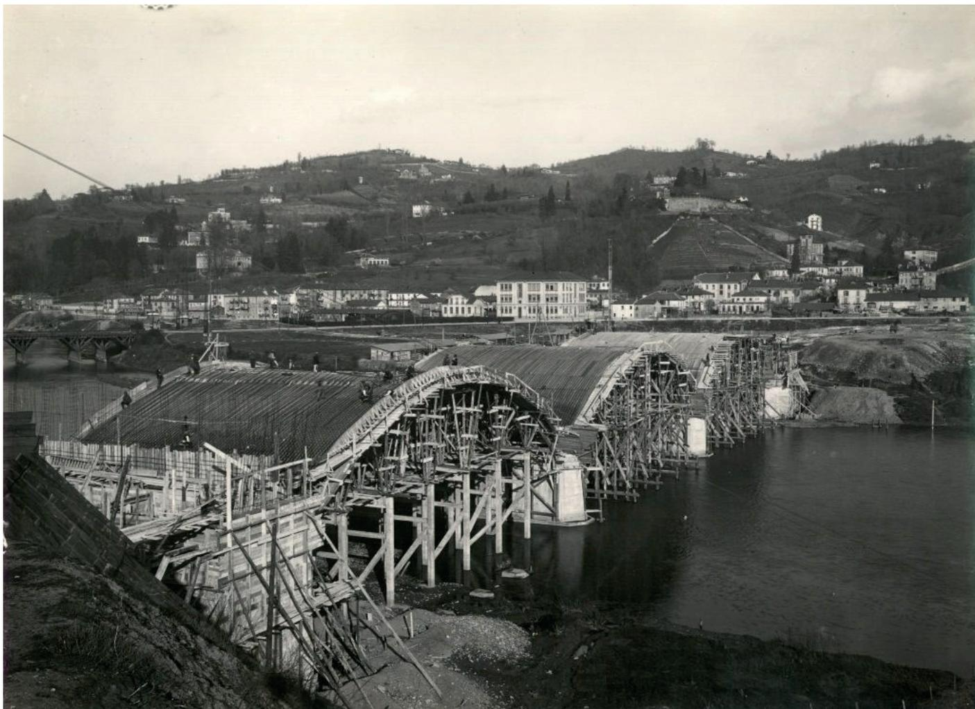
Mario Gabinio - 1927, Ponte Balbis, vista del cantiere da sud durante la posa delle armature delle volte.
