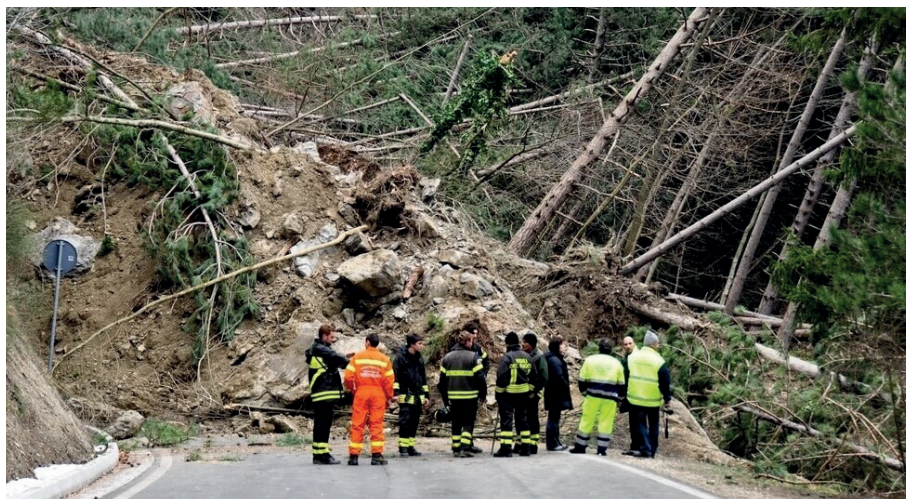
FIGURA: Frana in area montana, 2018 Fonte: < https://www.reteclima.it/dissesto-idrogeologico-in-italia-i-dati-di-ispra-descrivono-un-rischio-molto-alto/ >
