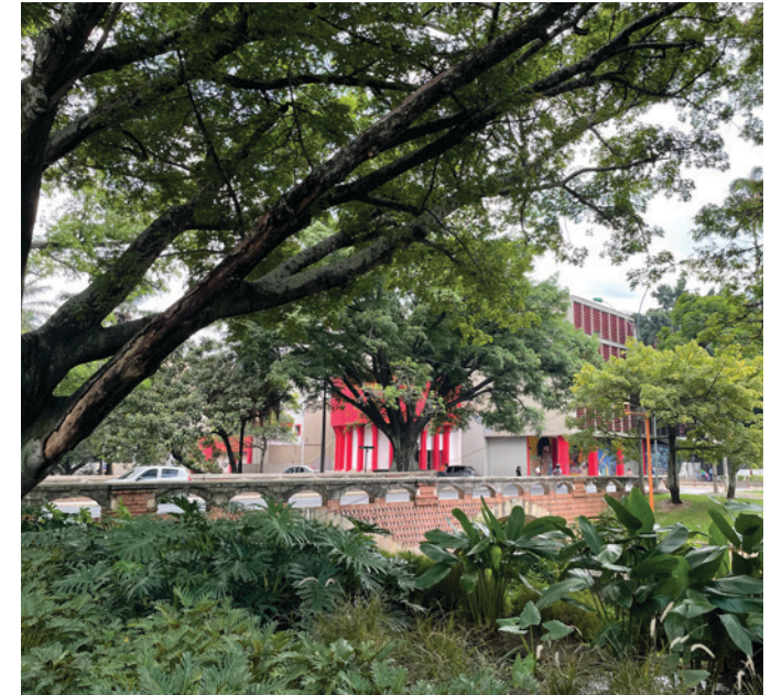
Puente de la Cervecería- BICM1-68
