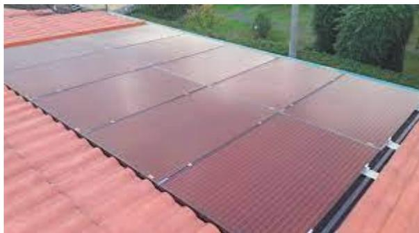
*Figura 27. Moduli Fotovoltaici Interamente Integrati e Colorati in maniera simile alla Copertura*
