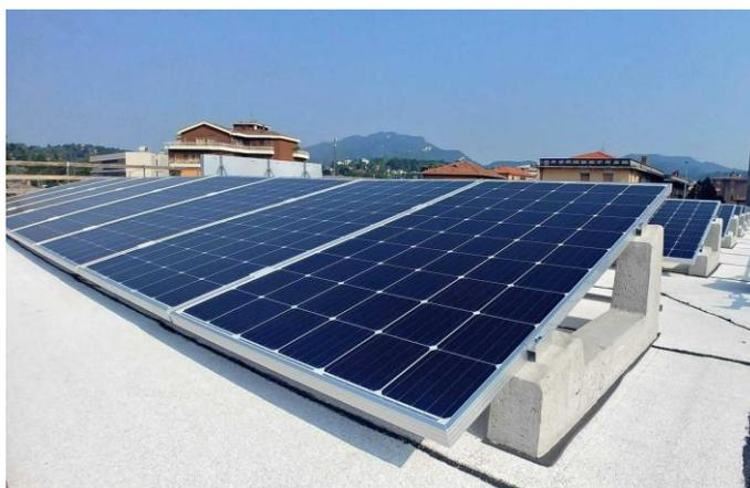
*Figura 38. Zavorre per Moduli Fotovoltaici*
