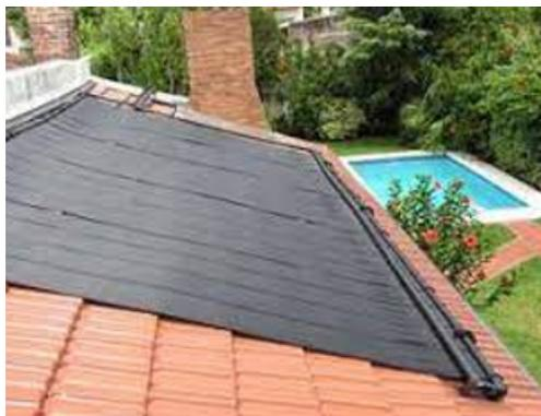
Figura 2.14. Esempio di collettori solari scoperti [14]
