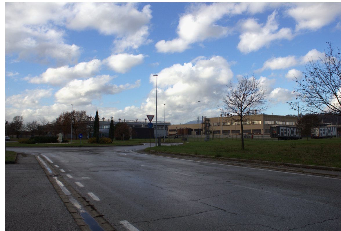
La Nuova Bretella del Cuoio (sopra) e la Strada Provinciale Nuova Francesca (sotto)
