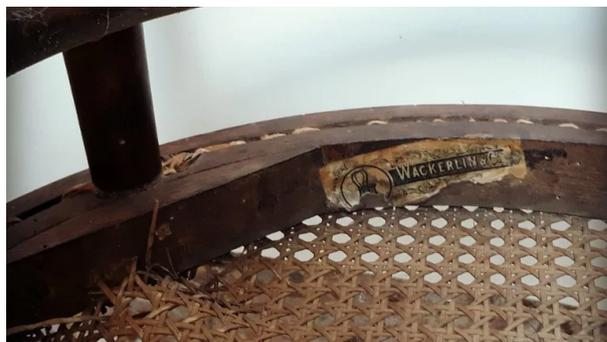
**Figura 86** "Tacchetto" di rinforzo della seduta brevettato da Wäckerlin.
