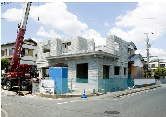
Figura 58 - Casa prefabbricata in assemblaggio a Fukuoka.
