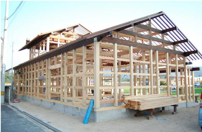
Figura 57 - Intelaiatura in legno di una casa in costruzione in stile convenzionale.
