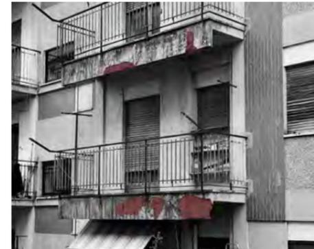
140\_Evidente stato di degrado, dettaglio dei balconi del prospetto Nord.
