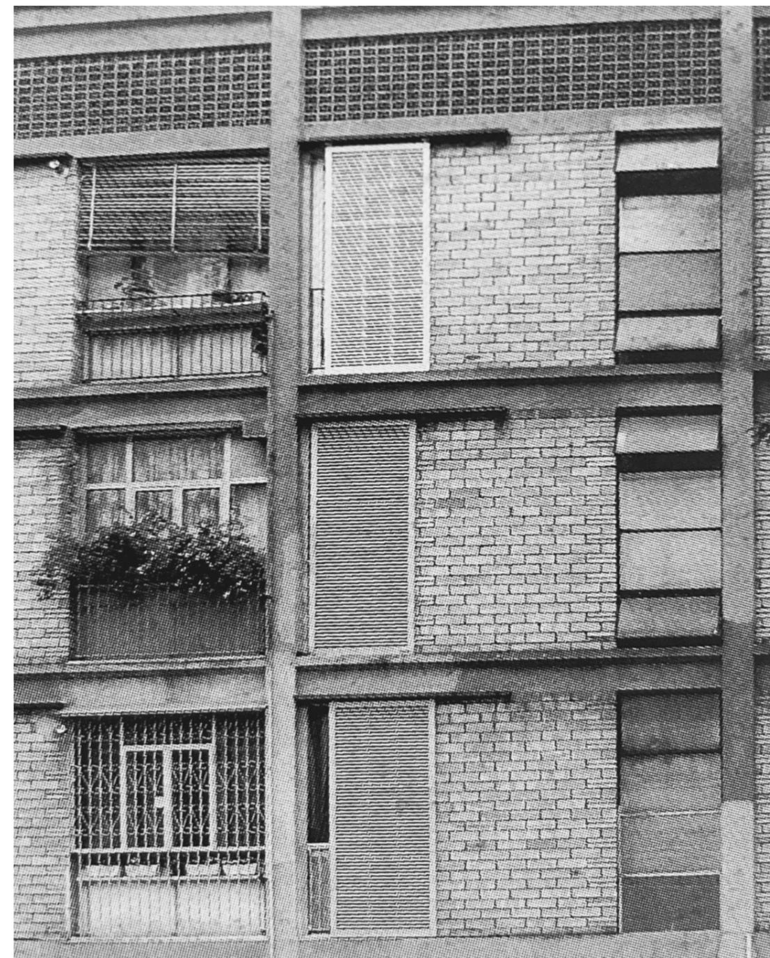
117\_Dettaglio della chiusura delle logge e sostituzione dei serramenti.
