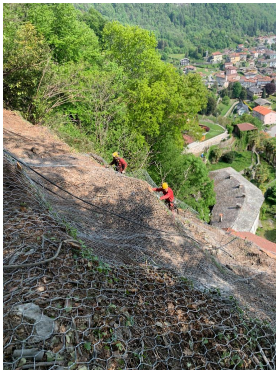
Figura 128: Installazione di nuove reti in aderenza armate. [72]
