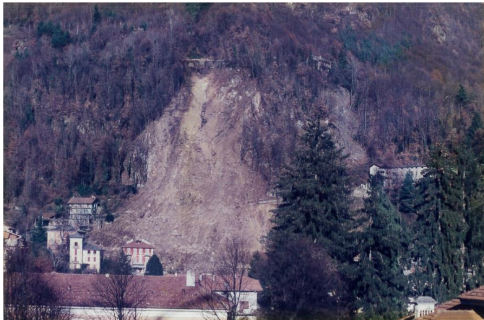
Figura 98: Pendio in seguito alla frana del 1994. [50]
