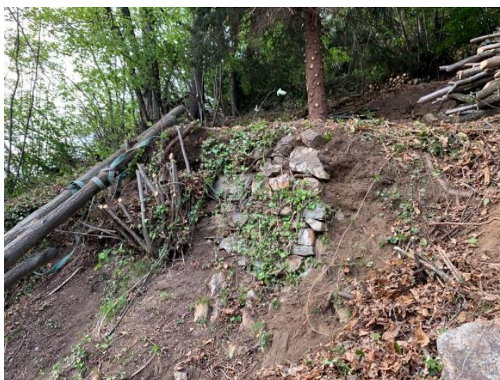
Figura 127: Rimozione e accatastamento di vegetazione ad alto fusto in corrispondenza di muretti a secco. [72]
