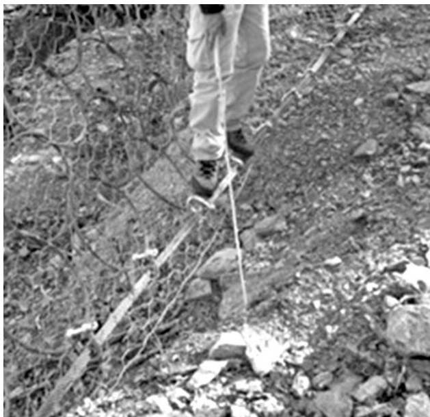
Figura 83: Esempio di vuoto al piede della barriera. [61]
