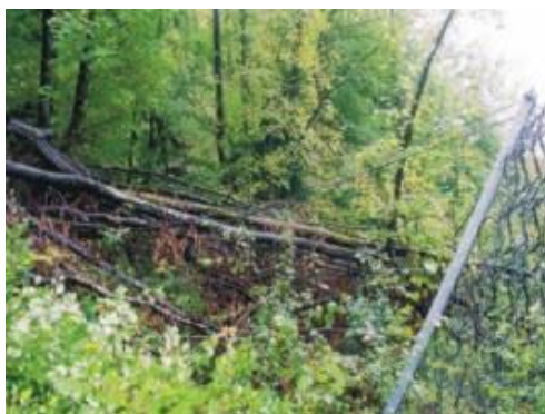
Figura 89: Diminuzione dell'altezza della barriera dovuta al ribaltamento di tronchi a monte. [65]
