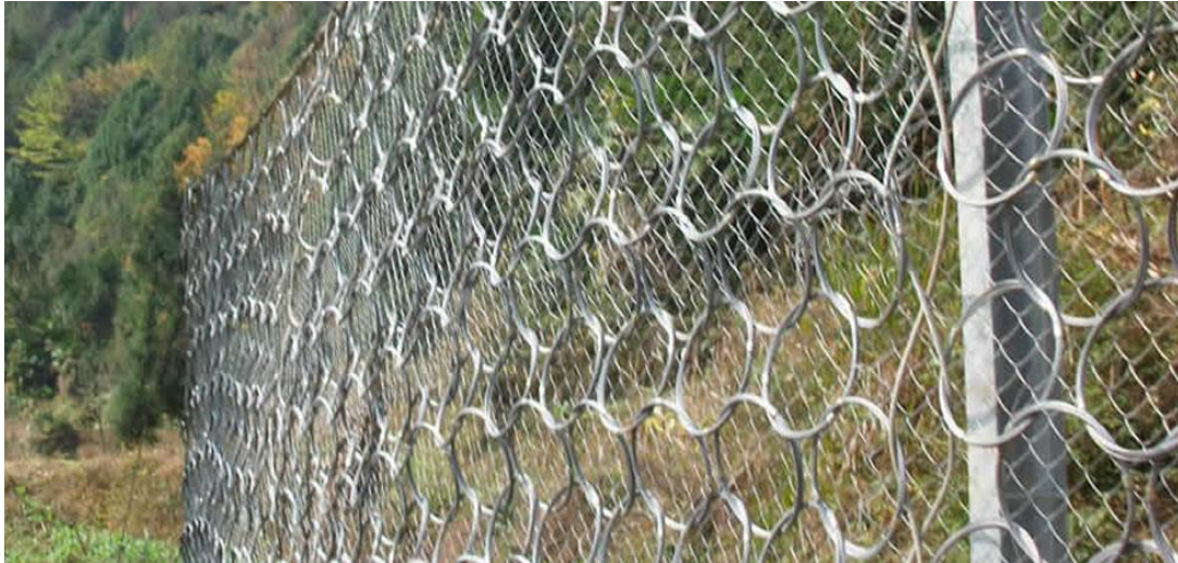
Figura 25: Dettaglio di pannello di rete metallica ad anelli.[12]
