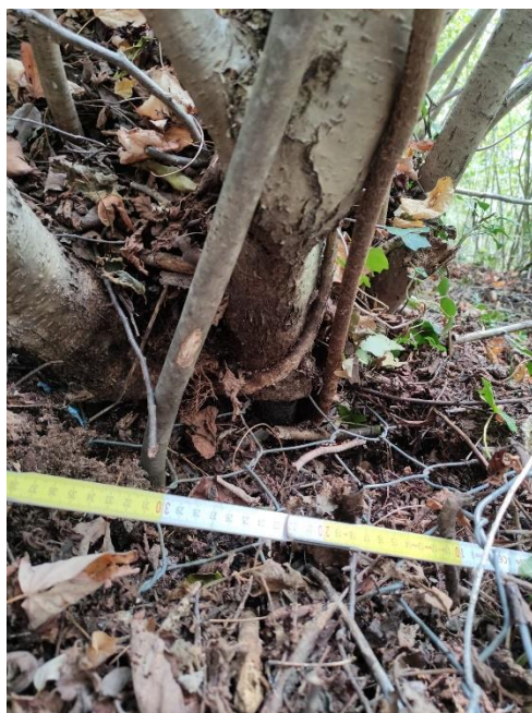
Figura 91: Vegetazione ad alto fusto totalmente solidale al sistema di difesa.
