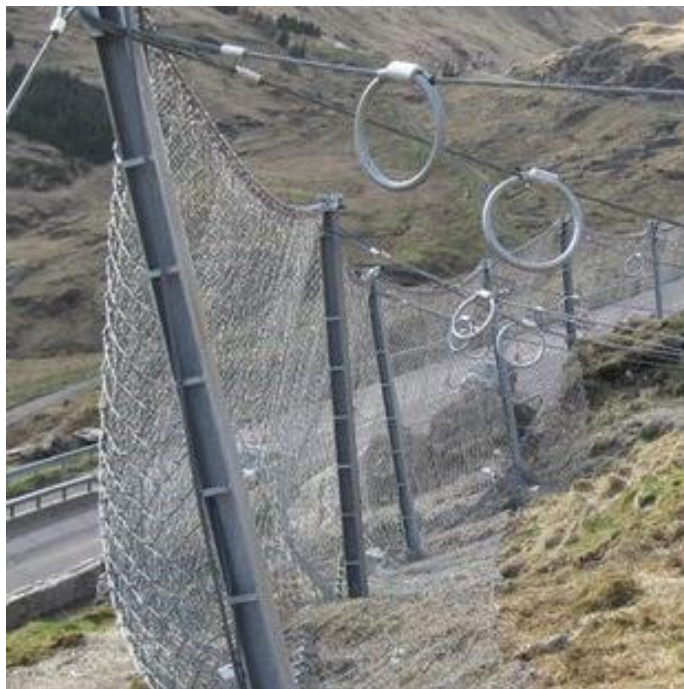
Figura 26: Particolare di struttura di sostegno. [5]
