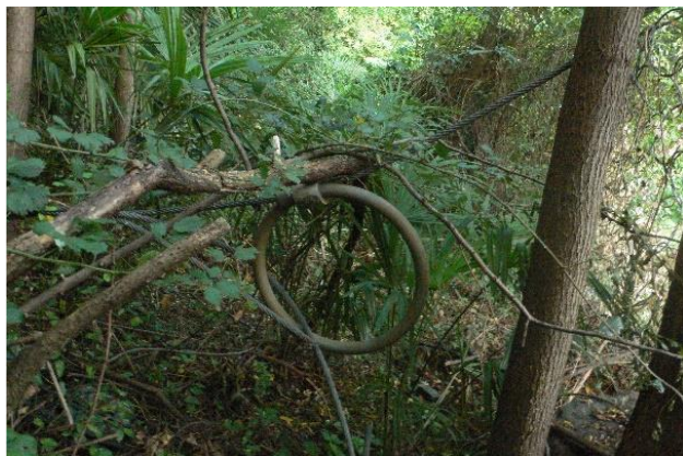
Figura 30: Particolare di dissipatore [69].
