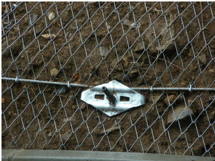
Figura 42: Esempio di rete a singola torsione a maglia romboidale [28]
