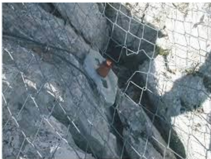
Figura 75: Lacerazione di rete a singola torsione in prossimità di sistema di ancoraggio.[19]
