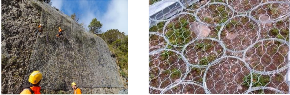
Figura 45: Pannelli in funi d'acciaio (a sinistra) [29] e pannelli ad anelli (a destra) [30].
