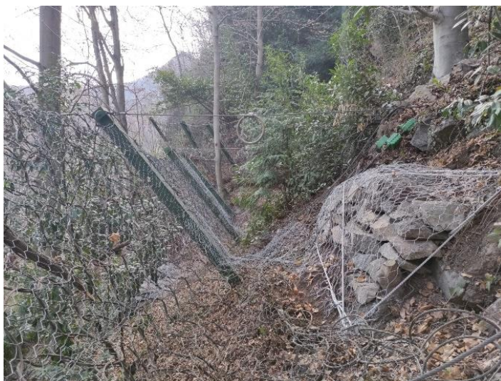
Figura 131: Accatastamento del detrito rimosso dalle barriere ricoperto da reti in aderenza armate.
