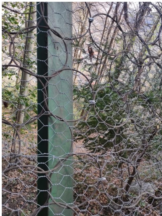
Figura 130: Aggiunta di morsetti, prima assenti, tra pannelli di rete della barriera n°7.
