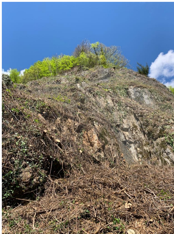
Figura 126: Rimozione totale della vegetazione nell'area adiacente le reti in aderenza. [72]
