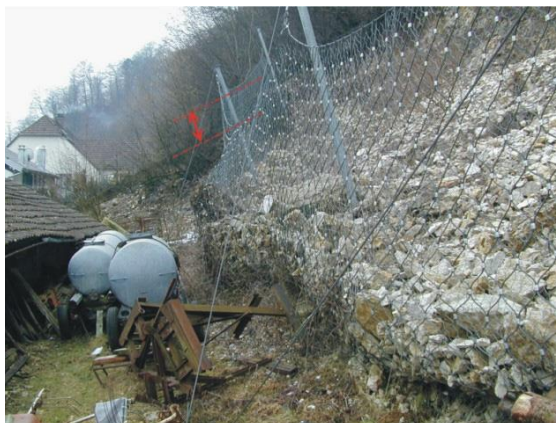
Figura 86: Barriera piena di detrito con riduzione dell'altezza di intercettazione. [65]
