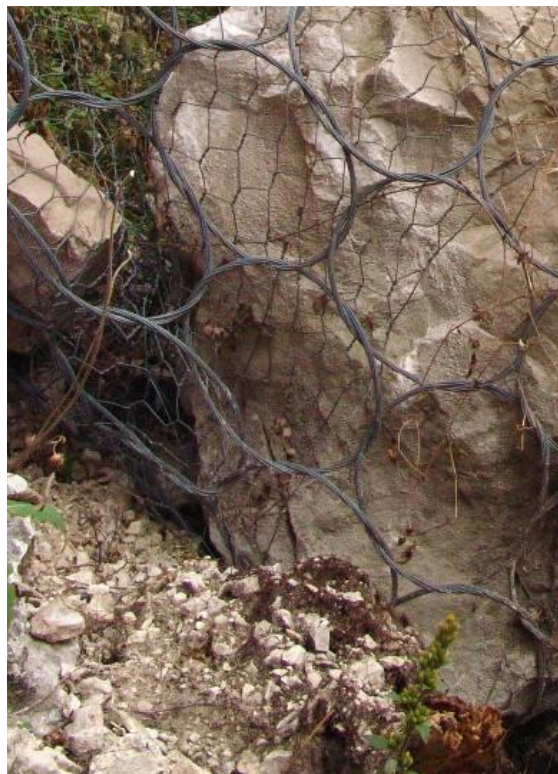
Figura 68: Anelli ovalizzati. [24]
