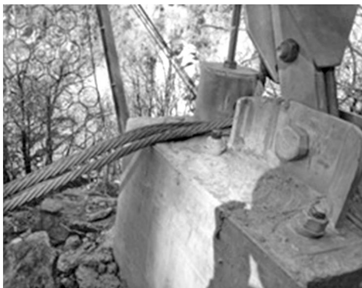
Figura 81: Interferenza tra plinto e fune. [61]
