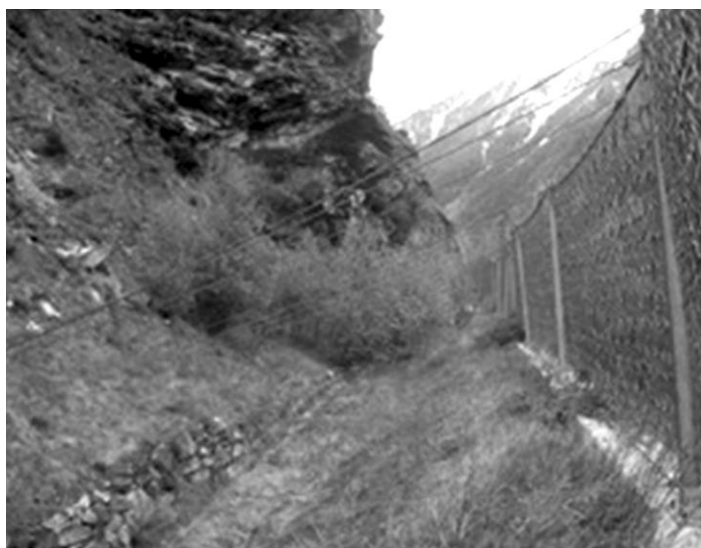
Figura 82: Incongruenza tra installazione e manuale di montaggio. [61]
