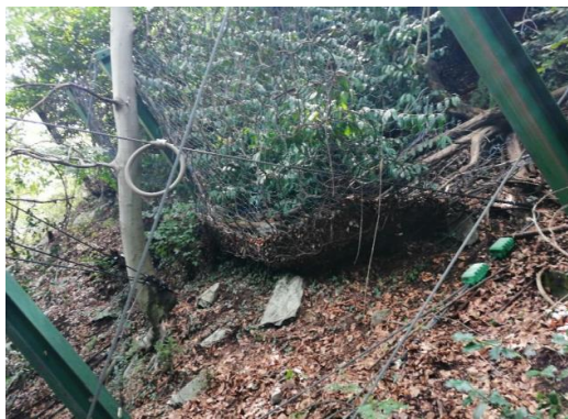
Figura 88: Tronco a ridosso della rete di una barriera. [66]
