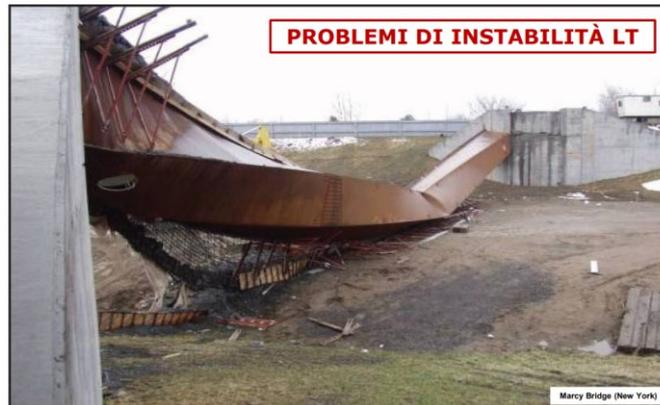
Figura 20: Esempio di instabilità flesso-torsionale
