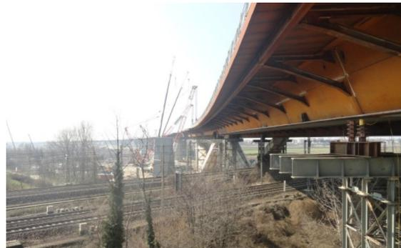
*Figura 4: Ponte metallico a sezione mista (Viadotto sul fiume Lambro TEEM, Milano, 2015)*
