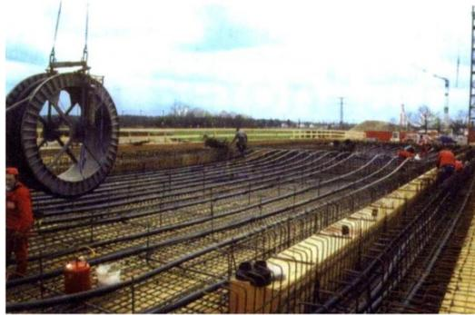
Figura 33: Esempio di tracciato delle guaine da pre-compressione
