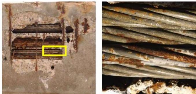
Figura 30: Esempio di cavi non iniettati con guaina non più esistente sull'intradosso del bulbo inferiore della trave
