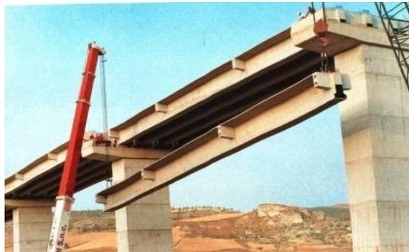
Figura 56: Elementi prefabbricati per impalcato a graticcio
