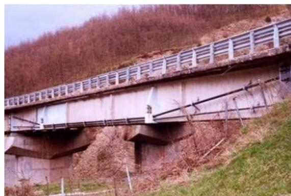
Figura 37: Esempi di precompressione esterna
