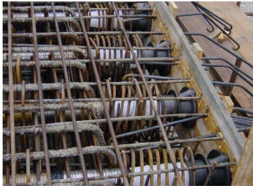
Figura 29: Esempio di errore costruttivo: spirali posizionate in modo errato in quanto non sono direttamente dietro la più esterna superficie dell'ancoraggio
