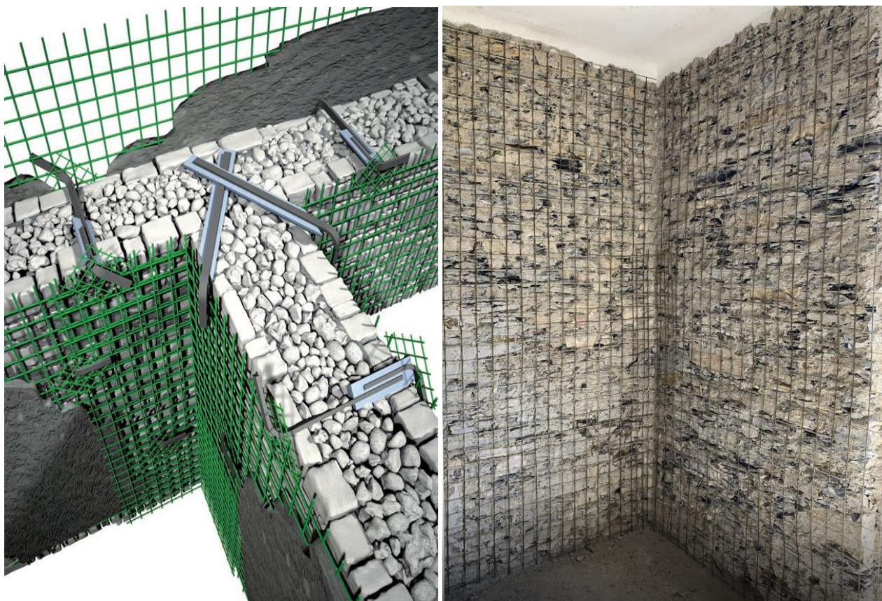
Fig.54 Tecnica di rinforzo dell'intonaco armato sottile
