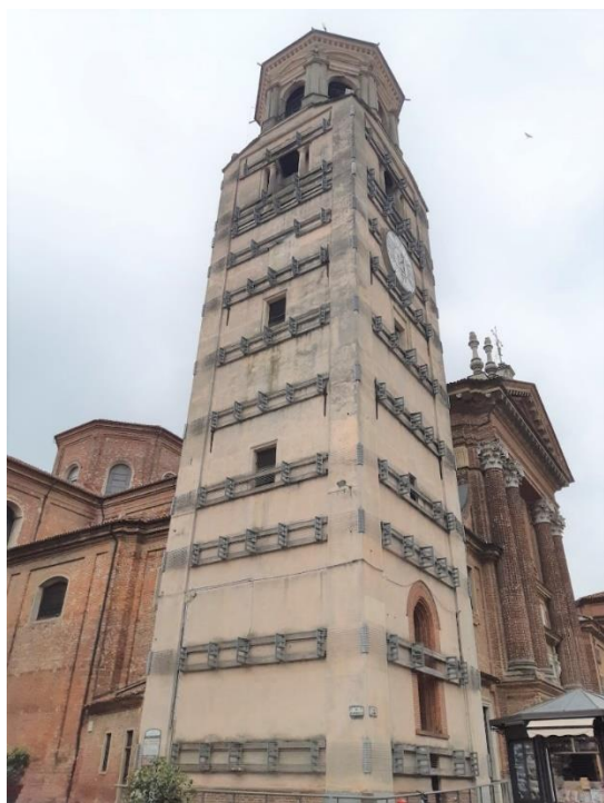
Fig. 6 Stato attuale con intervento di cerchiatura della struttura
