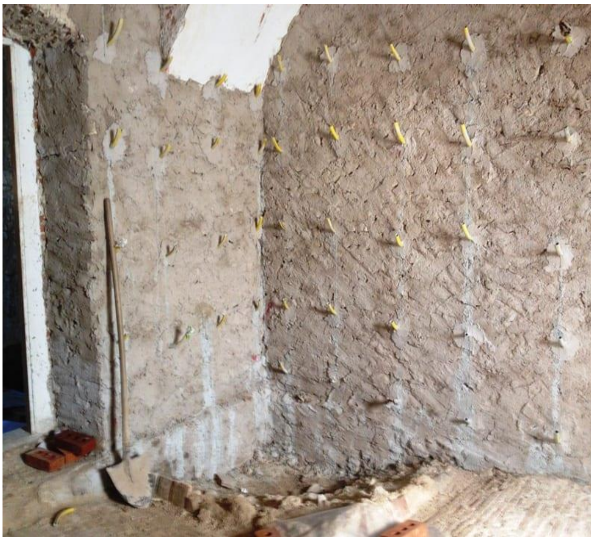
Fig.55 Applicazione di malta per iniezione
