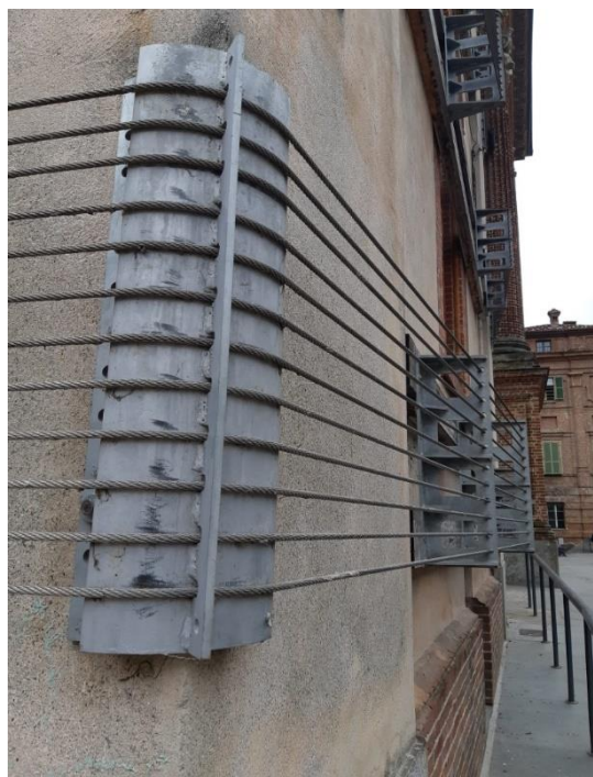
Fig. 6 Stato attuale con intervento di cerchiatura della struttura
