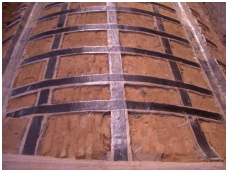
Fig.56 Rinforzo di volta mediante FRP
