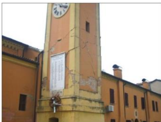
Fig.51 Facciata sud ed est del campanile di Casumaro Cento (FE) in seguito al sisma dell'Emilia del 2012 e sistema di pronto intervento a puntello
