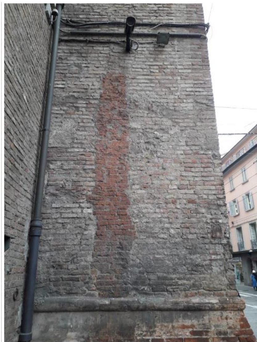
Fig.53 Bologna, Palazzo d'Accursio: esempio di antica sarcitura di una lesione con la tecnica dello scuci-cuci.
