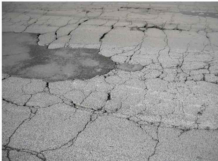
*Figura 36 Un esempio di fessurazione per fatica,*
