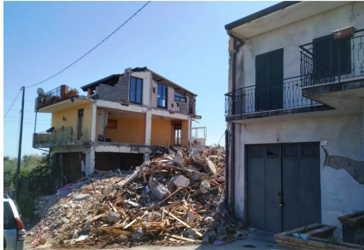
Figura 27 - crollo edificio ad uso abitativo, frazione di Fleri (ingvterremoti.com [8]).
