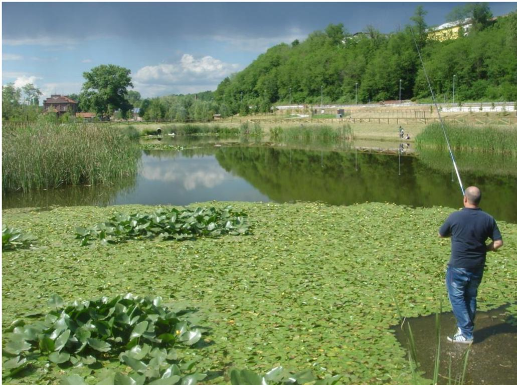
*Figura 5.8 Sistema di fitodepurazione per sfioro fognario realizzato a Gorla Maggiore (VA), progettato da IRIDRA. Intervento multiobiettivo che integra diversi servizi ecosistemici (ecosystem services) nel nuovo "Parco dell'Acqua".*
