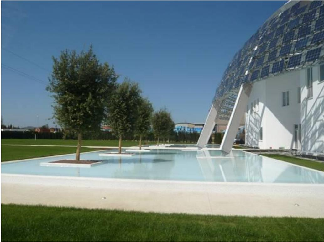
*Figura 5.8. Vasche d'acqua per recupero acque piovane presso il centro ricerche Kerakoll (Sassuolo - MO), progettata da IRIDRA, in collaborazione con BIOS-IS S.r.l.*
