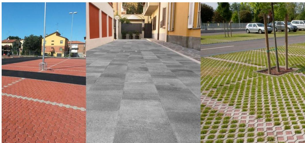
*Figura 5.6 Esempi di pavimentazioni permeabili: discontinue disperdenti, continue porose, prati armati (Fonte: Ferrari Bk)*
