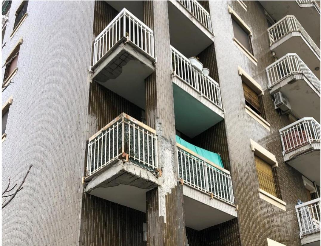
*Figura 9 Stato di conservazione del rivestimento.*
