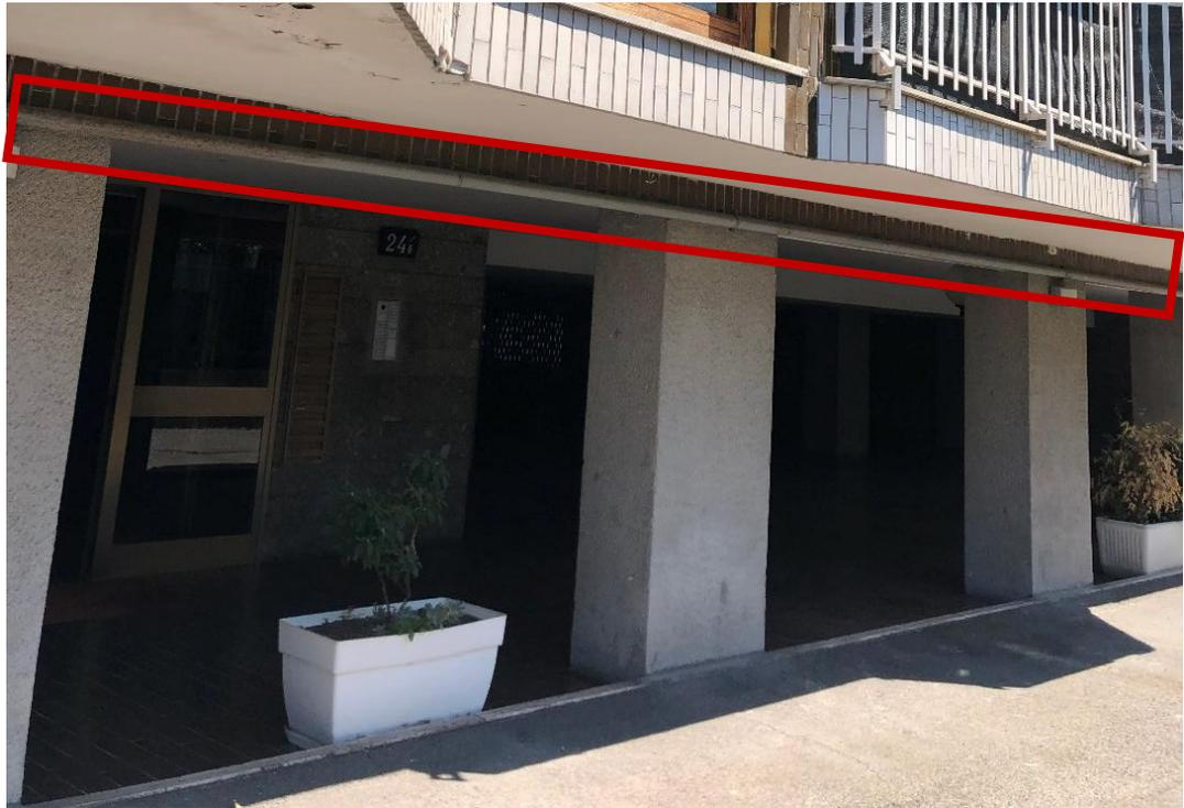
*Figura 46 Piano pilotis e tubo gas*
