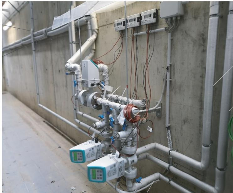
Figura 4.7 Collettori circuito primario GeothermSkin - Isola2 (Baralis, 2021)
