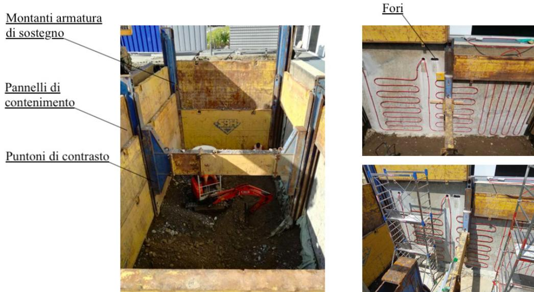
Figura 4.4 Fasi dell'installazione di GeothermSkin (Baralis and Barla, 2021)
