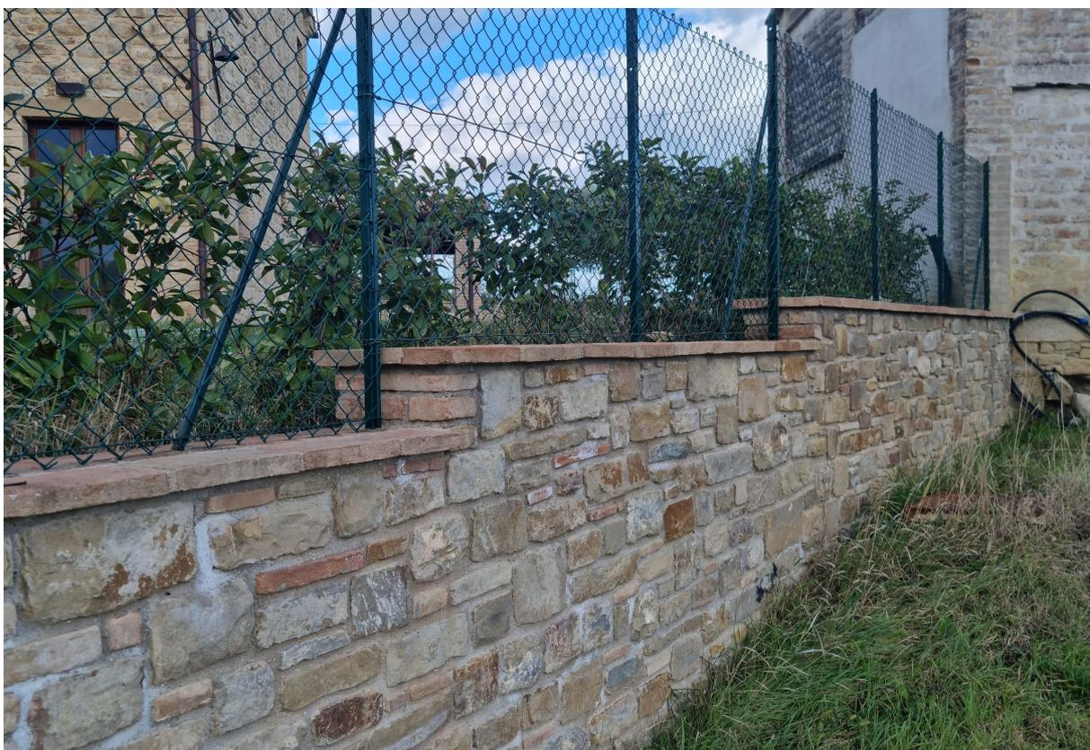
*Figura 13 -14 - esempi di costruzione con materiali locali: esempi di rivestimento dei muri di confine con pietra arenaria*
