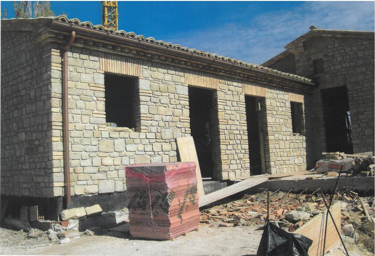
Figure 11 e 12 - esempi di costruzione con materiali locali: prospetti con pietra arenaria
