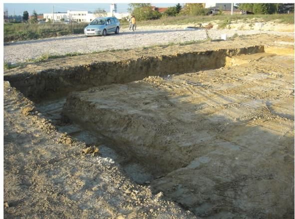
Figure 6 - sbancamento e realizzazione Lotto 4 (credit: Studio tecnico Coppari&Pierangeli)
