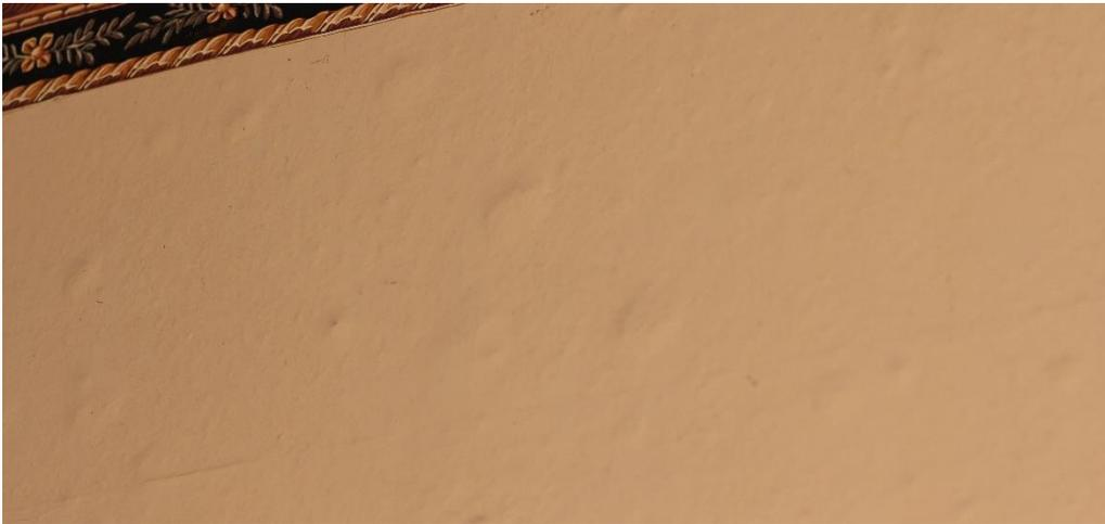
*Fig. 234 Rigonfiamento della carta da parati dovuto a formazione di calcinelli sull'intonaco di base, in alcove (secondo piano nobile)*
