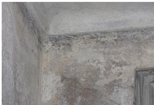
*Fig. 226 Presenza di muffa nei locali comuni del camerino degli attori e del guardaroba (secondo piano nobile)*
