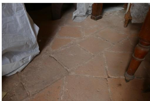
*Fig. 222 Presenza di usura e deposito superficiale su pavimentazione camerino degli attori*
