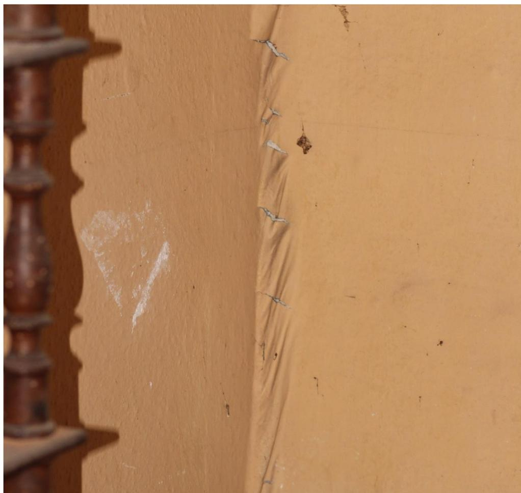
*Fig. 236 Rigonfiamento della carta da parati dovuto a perdita di aderenza della colla originaria, in alcove (secondo piano nobile)*
