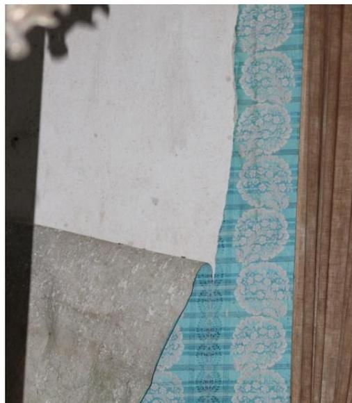
Fig. 130 Presenza di distacco di carta da parati nella camera dell'attrice (secondo piano nobile)
