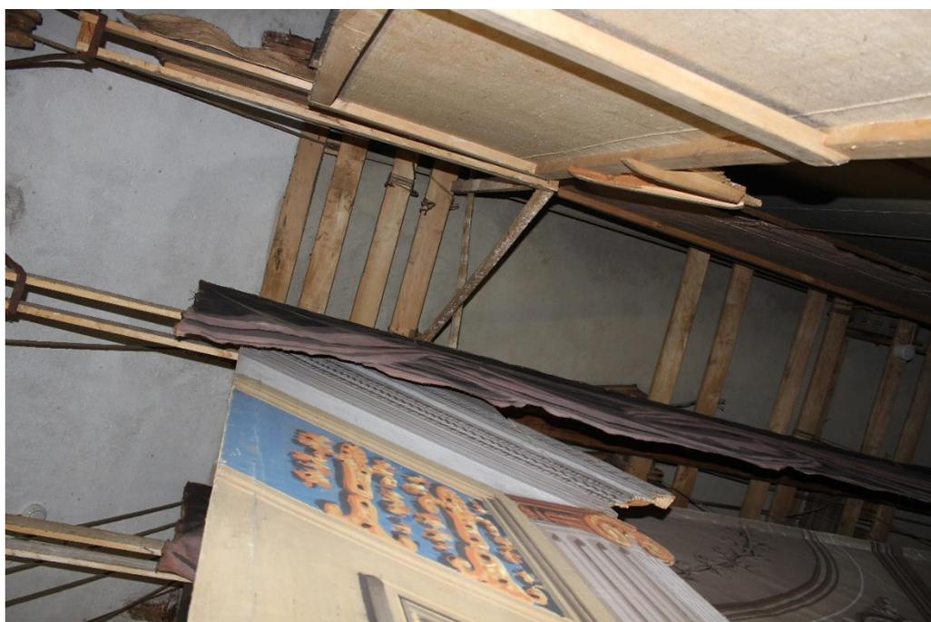
*Fig. 40 Fissaggio quinte mobili nel retropalco (primo piano nobile)*
