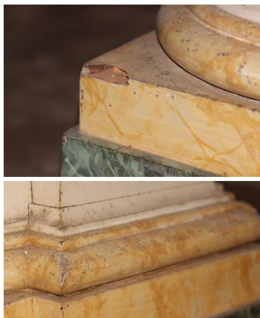
*Fig. 95 Deterioramento dovuto a usura su basamento colonne del teatro (primo piano nobile)*
