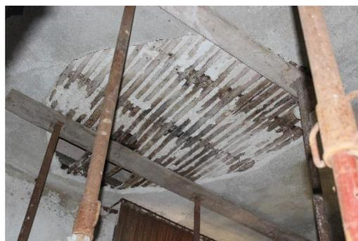
*Fig. 99 Deterioramento del soffitto in cannaccio nella camera dell'attrice (secondo piano nobile)*
