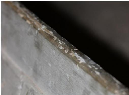
*Fig. 94 Deterioramento dovuto a usura su palcoscenico del teatro, dettaglio del fermapiede (primo piano nobile)*
