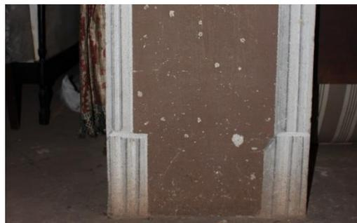
*Fig. 105 Muratura con presenza di distacchi dovuti a calcinelli nel camerino degli attori (secondo piano nobile)*
