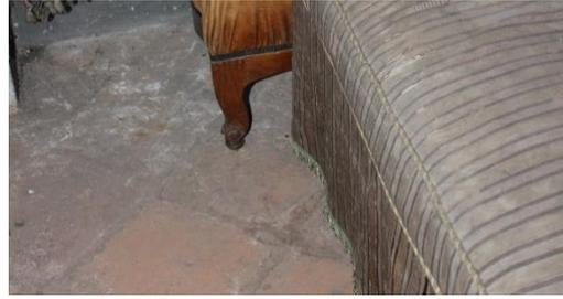
Fig. 96 Deterioramento dovuto a usura su pavimento in cotto, alcova C (secondo piano nobile)
