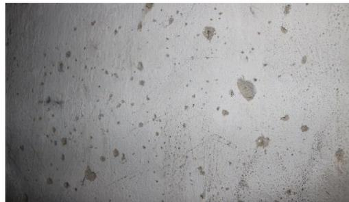
*Fig. 104 Muratura con presenza di distacchi dovuti a calcinelli nel camerino attiguo al retropalco del teatro (primo piano nobile)*
