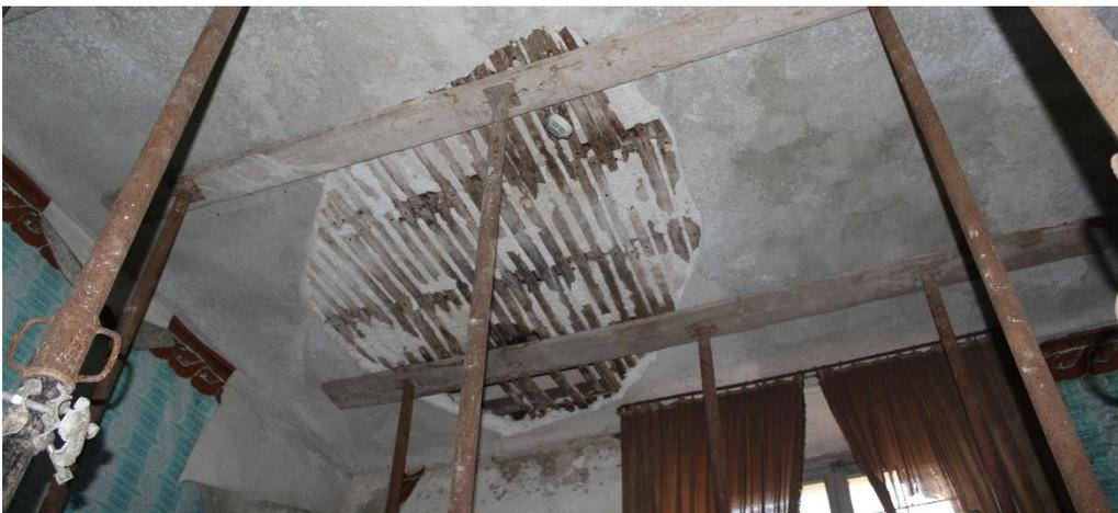
Fig. 59 Soffitto camera dell'attrice in canniccio (secondo piano nobile)
