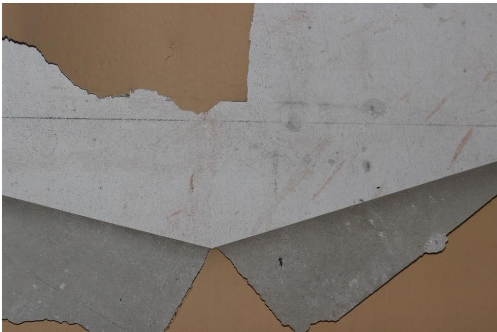
*Fig. 240 Distacco della carta da parati dovuto alla perdita di aderenza della colla originaria, in alcove (secondo piano nobile)*
