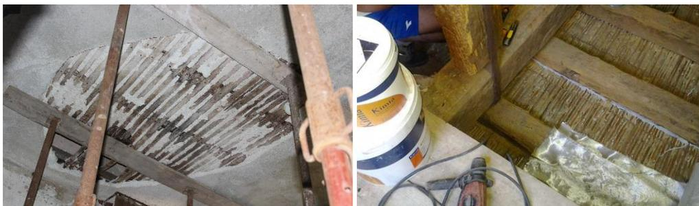
Fig. 224 Mancanza porzione di solaio in canniccio in camera dell'attrice (secondo piano nobile)
