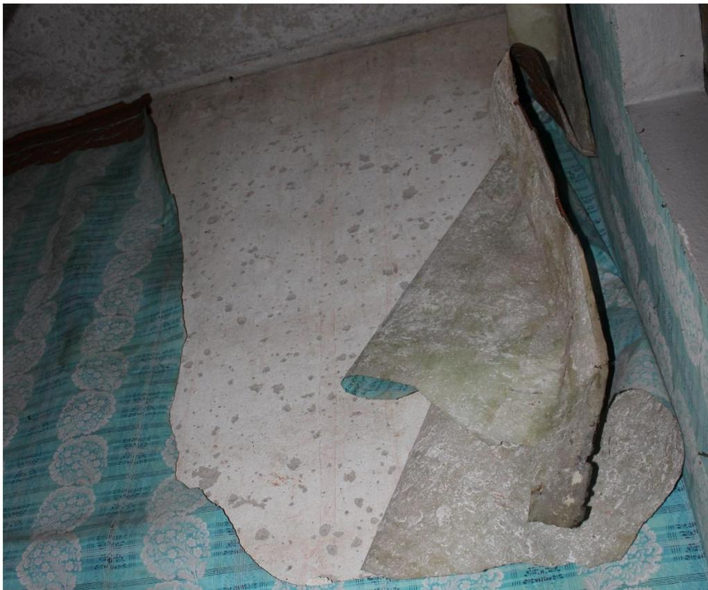
*Fig. 238 Distacco della carta da parati dovuto alla formazione di calcinelli sull'intonaco di base, in camera dell'attrice (secondo piano nobile)*
