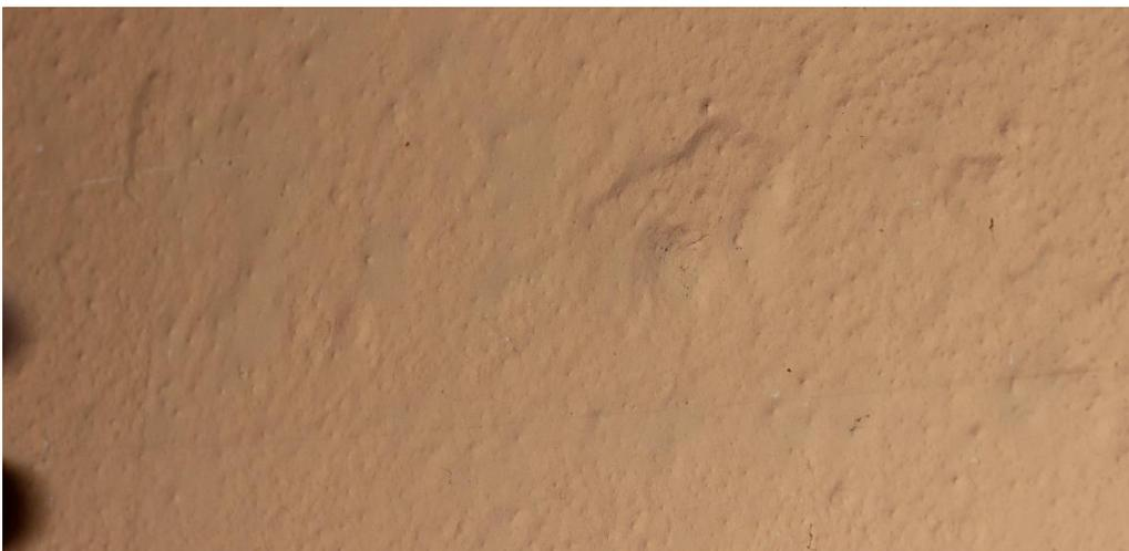
*Fig. 235 Rigonfiamento della carta da parati dovuto a formazione di calcinelli sull'intonaco di base, in alcove (secondo piano nobile)*
