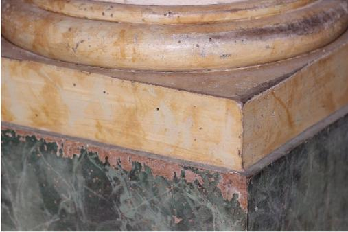
Fig. 218 Presenza di usura su basamenti delle colonne del teatro di corte (primo piano nobile)
