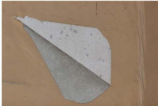
*Fig. 128 Presenza di distacco di carta da parati in alcova sinistra attigua al guardaroba (secondo piano nobile)*
