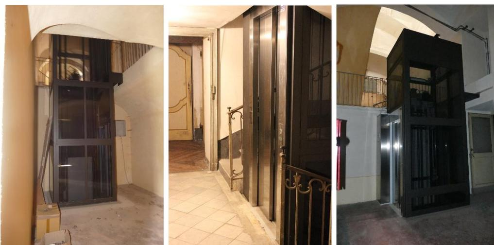
*Fig. 195 Ascensore di collegamento verticale. Fermate previste: cucine, piano ammezzato, primo piano nobile, secondo piano nobile. In figura, in sequenza, fermata al piano ammezzato, al primo piano nobile e al secondo piano nobile*
