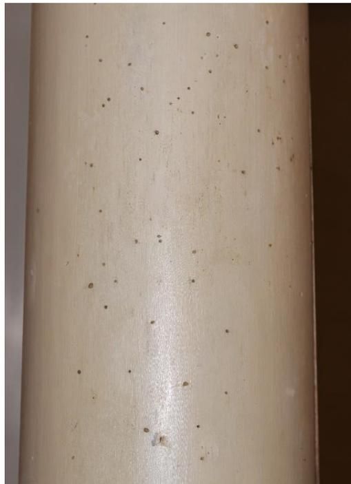
L'ultimo danno riscontrabile su questo tipo di materiale è dovuto all'usura. L'usura non è dovuta a fattori fisici o chimici, ma a effetti continui: attrito e calpestio. *“La resistenza all'usura è notevole per le essenze forti ad elevato peso specifico, come la quercia, il bosso, la robinia, il noce, l'eucalipto, l'ulivo, il teak”*<sup>55</sup>.
