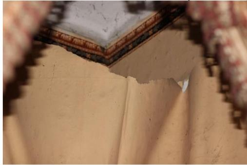
*Fig. 127 Presenza di distacco di carta da parati in alcova destra attigua al guardaroba (secondo piano nobile)*
