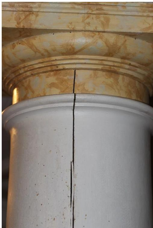
*Fig. 214 Fessurazione presente sulle colonne del teatro di corte (primo piano nobile)*
