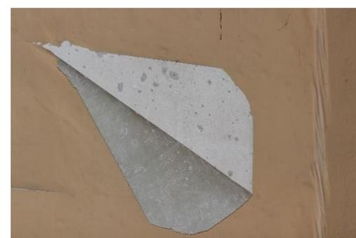
*Fig. 107 Muratura con presenza di distacchi della carta da parati dovuto ai calcinelli nell'alcova destra del guardaroba (secondo piano nobile)*
