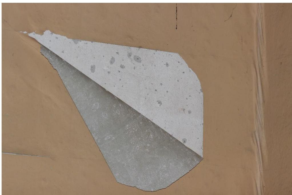
*Fig. 237 Distacco della carta da parati dovuto alla formazione di calcinelli sull'intonaco di base, in alcove (secondo piano nobile)*
