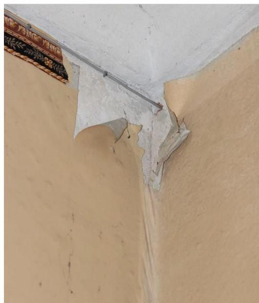
*Fig. 129 Presenza di distacco di carta da parati in alcova centrale attigua al guardaroba (secondo piano nobile)*
