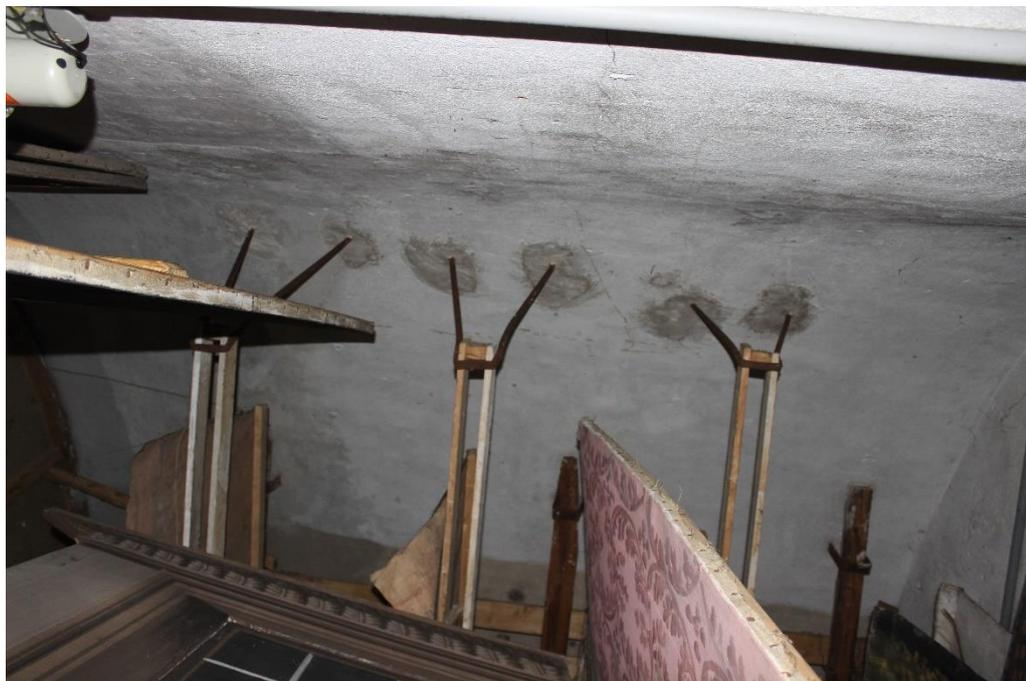
*Fig. 39 Fissaggio quinte mobili nel retropalco (primo piano nobile)*
