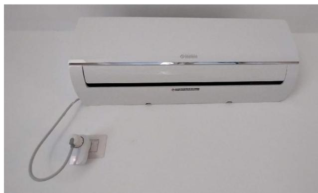
*Figura 24: unità interna climatizzatore split.*
