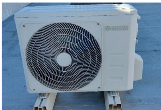
*Figura 23: unità esterna climatizzatore split.*
