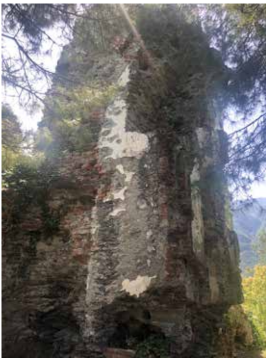
Foto 24-25 Parte della muratura di facciata speculare alle foto precedenti, il grande spessore murario è volto a sostenere un sistema voltato a prova di bomba, foto scattate il 15/05/20.
