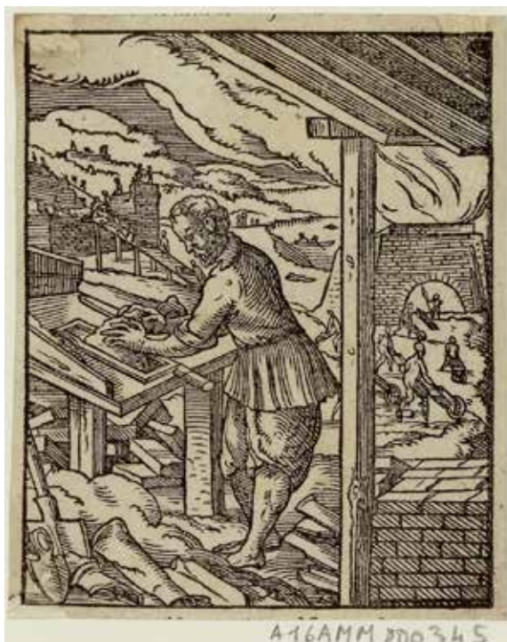
Fig. 19 Stampa seicentesca raffigurante la produzione di coppi e mattoni per la costruzione in cantiere con loro relativi forni per la cottura, Le fabricant de tuiles et de briques , Amman Jost, 1539-1591, https://numelyo.bm-lyon.fr/f_iew/BML:BM-L_02EST01000A16AMM000345
