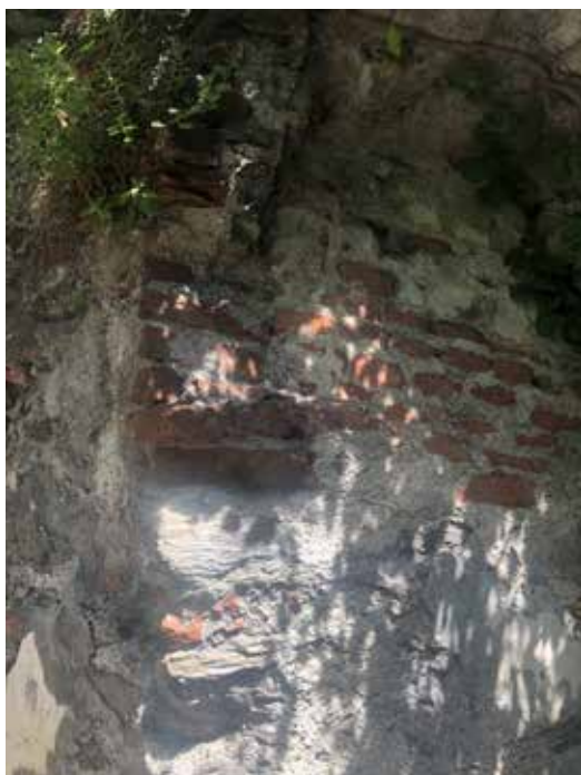
Foto 34-35 Particolare dello spigolo tra l'abside e il volume del transetto. Dettaglio muratura di parte dell'abside, si nota un utilizzo maggiore di laterizio rispetto alle altre parti della chiesa, proprio per la forma semicircolare del volume più facilmente ottenibile con esso, foto scattate il 15/05/20.
