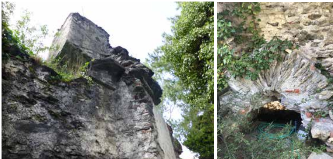
Foto 26-27 Dettaglio sommità delle rovine parte di levante, si nota la pietra lavorata ove correva il cornicione interno alla chiesa. Fig 6 Particolare di una volta sommersa dai detriti in una delle cappelle di levante, da notare come la solidità a prova di bomba sia data dalla pietra locale e non dal laterizio, foto scattate il 15/05/20.
