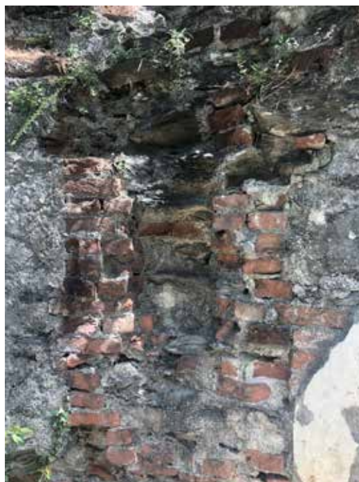
Foto 34-35 Particolare dello spigolo tra l'abside e il volume del transetto. Dettaglio muratura di parte dell'abside, si nota un utilizzo maggiore di laterizio rispetto alle altre parti della chiesa, proprio per la forma semicircolare del volume più facilmente ottenibile con esso, foto scattate il 15/05/20.
