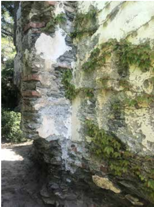
Foto 22-23 Resti della muratura di ponente dello pseudo pronao della facciata, di altezza considerevole e dalla forma particolare suggeriscono una complessità tra le parti dove la timpanatura era stata realizzata con un gioco di volumi aggettanti e rientranti e da un apertura circolare al centro, foto scattate il 15/05/20.
