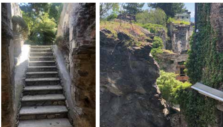
Foto 17 Dettaglio della scalinata successivamente costruita, la quale ben evidenzia di quanti metri è sommersa internamente di detriti. Con i suoi 12 gradini ciascuno alto 15 cm collega un dislivello di ben 1,8 metri. Foto 18 Vista dal lato nord del Palazzo del Governo del lato di ponente dell'alloggio del cappellano, significativamente più basso rispetto al corpo principale della chiesa, foto scattata il 25/05/20.
