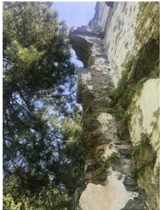
Foto 22-23 Resti della muratura di ponente dello pseudo pronao della facciata, di altezza considerevole e dalla forma particolare suggeriscono una complessità tra le parti dove la timpanatura era stata realizzata con un gioco di volumi aggettanti e rientranti e da un apertura circolare al centro, foto scattate il 15/05/20.
