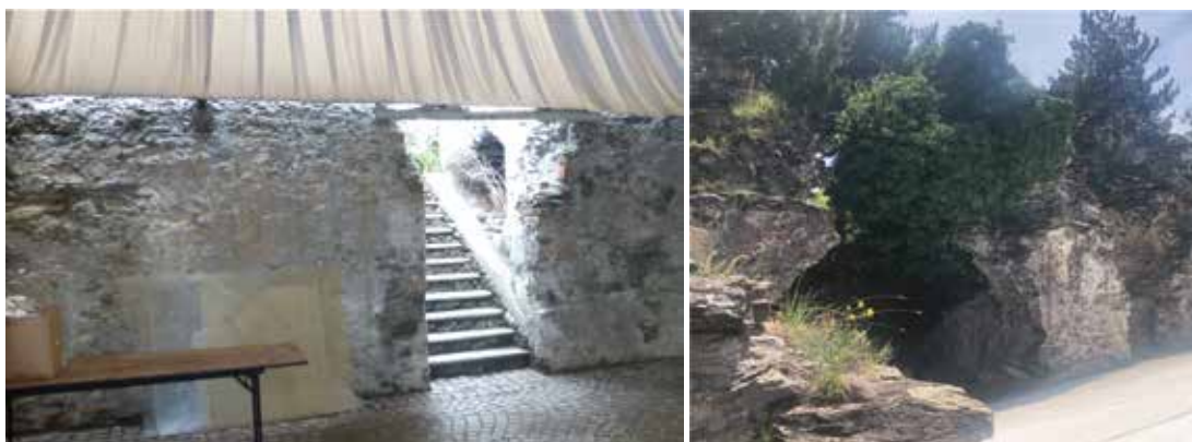
Foto 15-16 Resti del prospetto di ponente della chiesa, rispettivamente parte bassa ( livello originario base chiesa, collegato al livello attuale piano terra da una scala costruita successivamente) e piano superiore dove si notano ancora le aperture arcuate delle finestrature precedenti alla copertura, foto scattata il 25/05/20.
