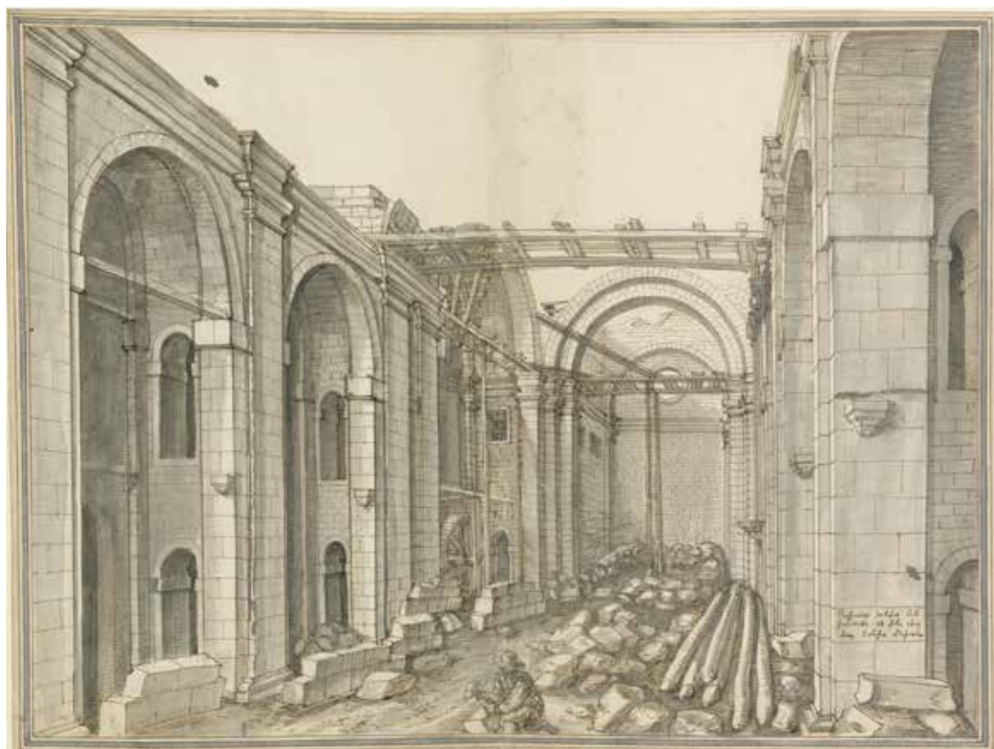
Fig. 18 Stampa seicentesca raffigurante il cantiere per la costruzione di una chiesa, ben evidenti i ponteggi e le armature per la costruzione delle superfici voltate, Veüe du Bâtiment del'Eglise collégiale du Puy , Martellange Etienne ,1617, https://gallica.bnf.fr/services/engine/search/sru?operation=searchRetrieve&version=1.2&startRecord=90&maximumRecords=15&page=7&query=%28gallica%20all%20%22echafaudage%22%29%20and%20dc.type%20all%20%22image%22
