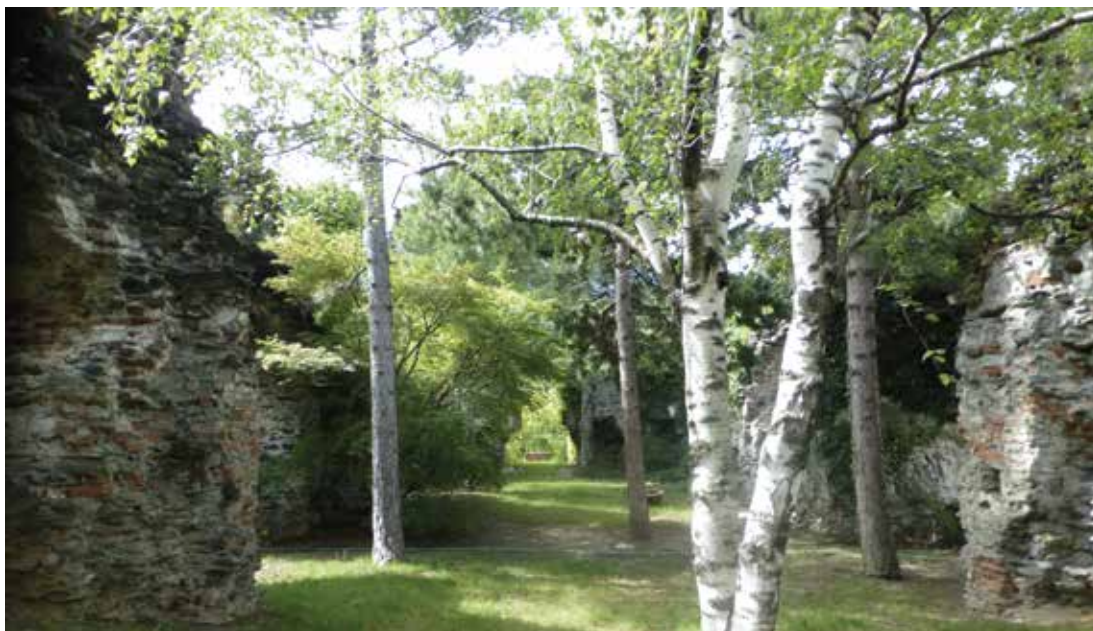
Foto 21 L'interno della chiesa vista dall'abside verso ciò che resta dell'entrata, i detriti e il materiale accumulato a seguito della demolizione hanno creato uno strato di terra dove la vegetazione ha preso il sopravvento, foto scattata il 15/05/20.
