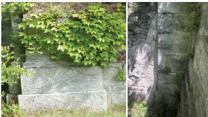
Foto 33-34 Dettaglio in facciata di basi, lesene e controlesene con pietra lavorata, foto scattate durante il sopralluogo del 10/11/20
