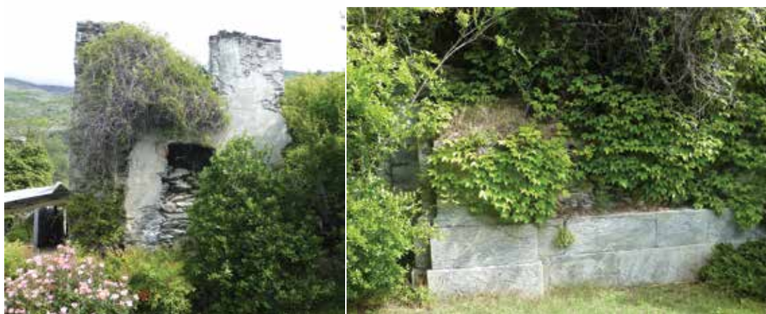
Foto 2 I resti dell'alloggio del cappellano del forte, non completamente demolito, arrivavano sin al secondo piano dove è mancante parte di muratura ed il tetto. L'apertura al primo piano è parzialmente murata da materiale di risulta. Foto 3 Parte rimanente dello pseudo pronao ove c'era l'entrata della chiesa; è evidente la pietra lavorata che coronava la facciata fortunatamente scampata alla distruzione, foto scattate il 25/05/20.
