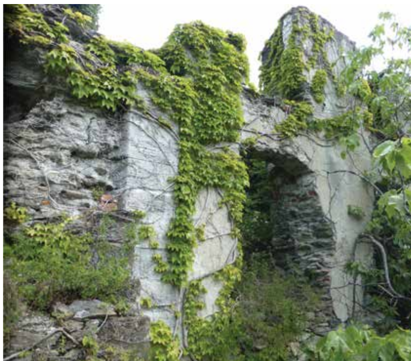
Figura 20-21, Dettaglio delle murature in facciata con loro rivestimento in pietra lavorata per la zoccolatura e basi per le lesene, foto scattate durante il sopralluogo del 10/11/20
