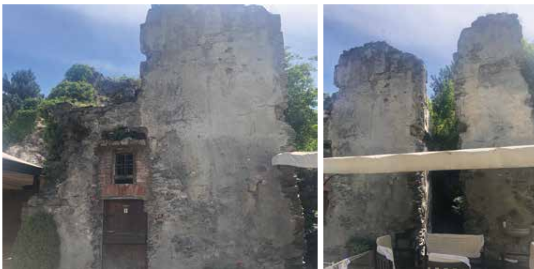
Foto 19-20 Dettaglio di ciò che resta della facciata di ponente del corpo aggettante alla chiesa dell'alloggio del cappellano, la porta è stata aggiunta successivamente ed il volume è usato come bagno. L'apertura finestrata al primo piano è stata parzialmente murata e ne è stata ricreata una di dimensioni più piccole. L'apertura invece del secondo piano è quasi completamente distrutta e ne rimane solo parte dello sviluppo laterale di destra, foto scattate il 25/05/20.
