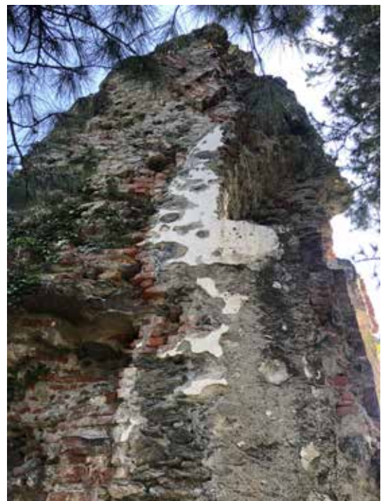
Foto 24-25 Parte della muratura di facciata speculare alle foto precedenti, il grande spessore murario è volto a sostenere un sistema voltato a prova di bomba, foto scattate il 15/05/20.
