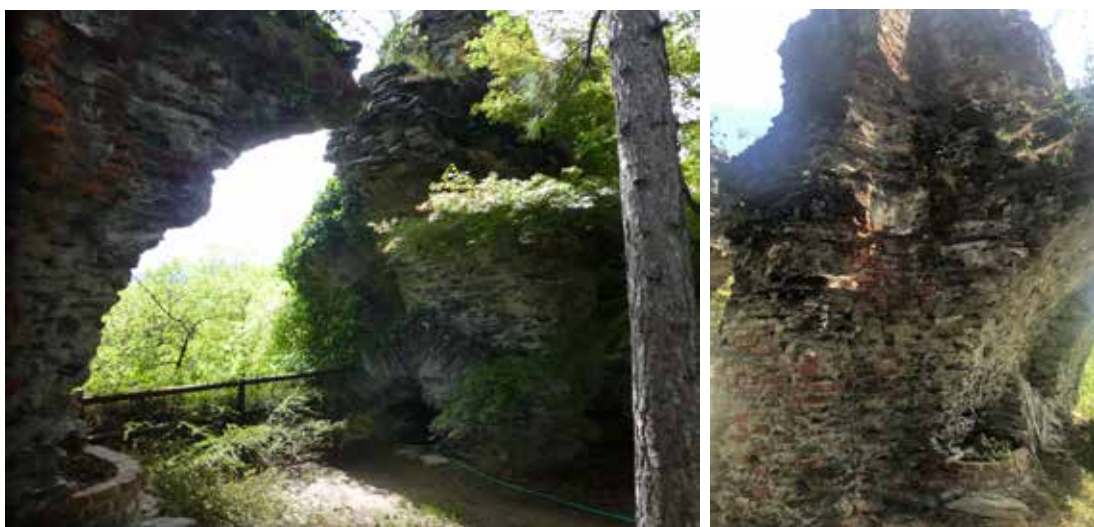
Foto 28-29 Foto dell'interno lato di levante, si nota come erano presenti cappelle laterali coperte da strutture voltate di cui rimangono soltanto delle parti, foto scattate il 15/05/20.
