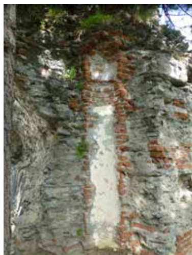
Foto 44 Dettaglio di uno degli spigoli tra imposte di volta dell'interno, si nota come la superficie fosse smussata con un gioco di concavità date dall'utilizzo del laterizio poi intonacato Foto 45 Cappelletta di ponente ove è stata creata una scala a gradini di collegamento tra la parte esterna del palazzo del governo e la chiesa, foto scattate il 15/05/20.
