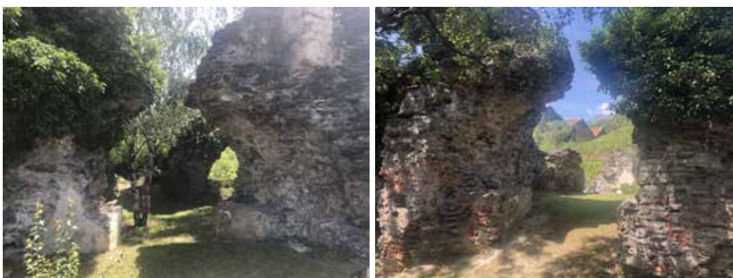
Foto 40-41 Vista delle arcate del transetto di ponente della chiesa del Beato Amedeo, foto scattate il 15/05/20.
