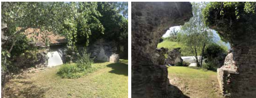
Foto 38-39 Vista del transetto lato di ponente della chiesa, scampato alla totale demolizione rispetto, alla sua controparte di levante dà ancora un'idea spaziale del suo sviluppo, le imposte degli archi suggeriscono la copertura anticamente voltata dello spazio, foto scattate il 15/05/20.
