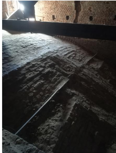
Foto: Particolare della catena di sinistra e di destra della prima campata di volta adiacente alla facciata, 2022, Martina Aparo
