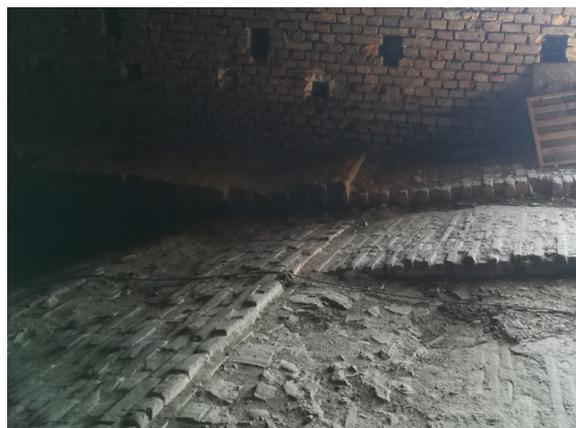
Foto: Particolari inspessimenti profilo della volta e l'arcone e capriate nello sfondo, 2022, Martina Aparo
