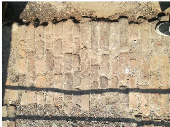
Foto (sinistra): Particolare di mattoni e tavelle, a sinistra l'arcone con i mattoni, a destra la volta con le tavelle., 2022, Martina Aparo
