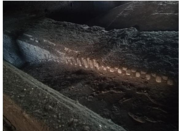
Foto: Particolari inspessimenti profilo dell'arcone con morse di attesa per la volta, 2022, Martina Aparo
