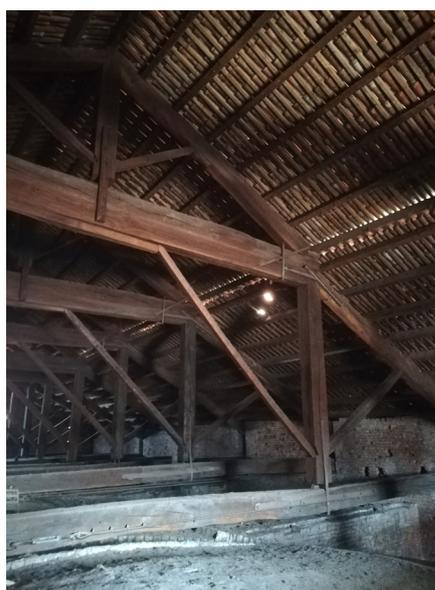
Foto (sinistra): Particolare della struttura portante con travi trasversali di collegamento con la “facciata provvisoria”, 2022, Martina Aparo
