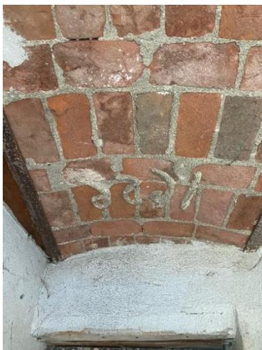
Voltina della soletta al piano terra del fienile con impressa in rilievo la data di costruzione.
